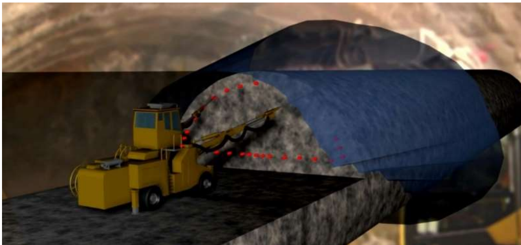
Figura 59.- Perforación de una etapa de inyección en Avance
