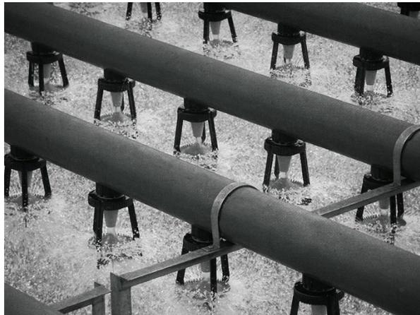
Figura 4.2.-Sistema de distribución a presión
