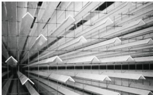
Figura 3.16.- Relleno de goteo para torre de refrigeración
