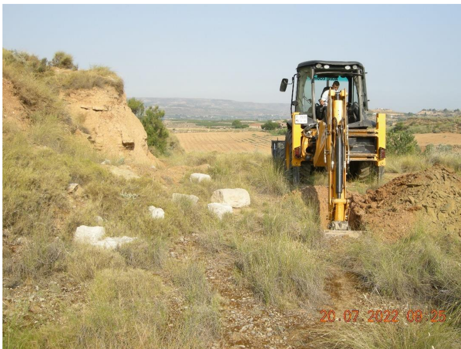
Figura 2.3 Trabajos de ejecución de la calicata C-3.
