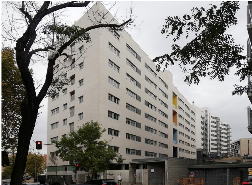
Figura 5.1.- Imagen de la fachada exterior de la NSA09
