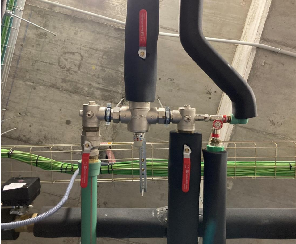
Figura 5.6 Válvula termostática mezcladora
