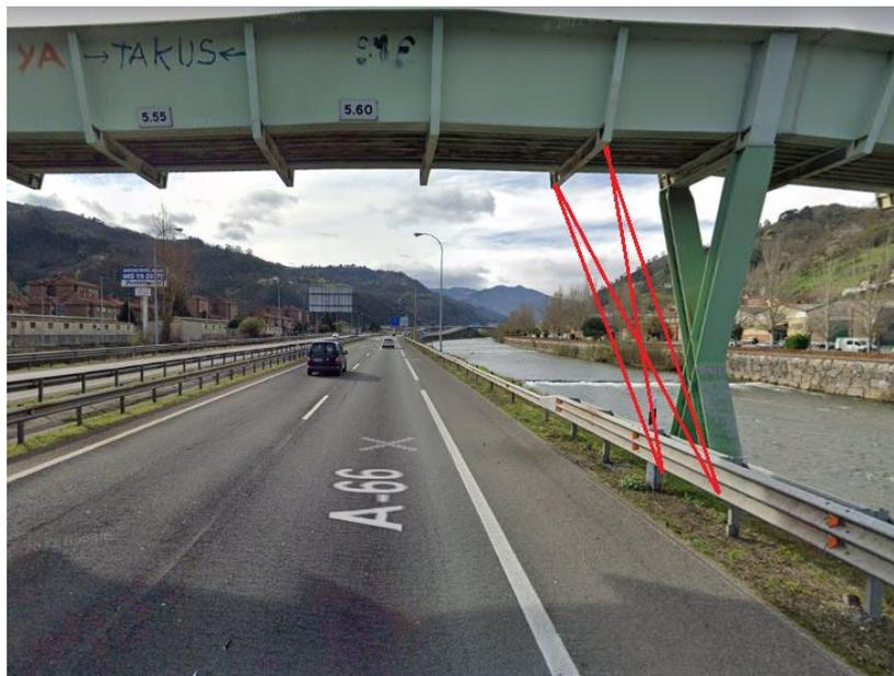
*Ilustración 1. Ocupación aproximada del refuerzo intermedio, en el lado de la autovía.*
