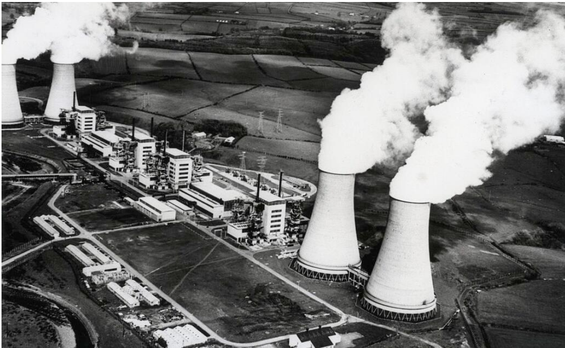
ILUSTRACIÓN 2. CENTRAL NUCLEAR (POWER TECHNOLOGY, S.F.)
