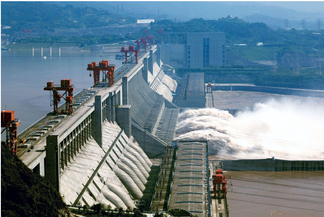
ILUSTRACIÓN 16. PRESA DE LAS TRES GARGANTAS EN EL CURSO DEL RÍO YANGTSÉ, EN CHINA. LA CENTRAL HIDROELÉCTRICA MAS GRANDE DEL MUNDO (BRITANNICA, 2022)
