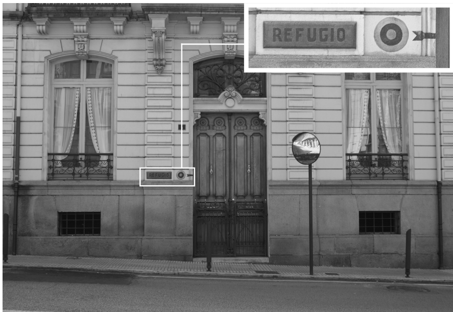
Figura 6. Fachada del edificio y detalle del cartel.
