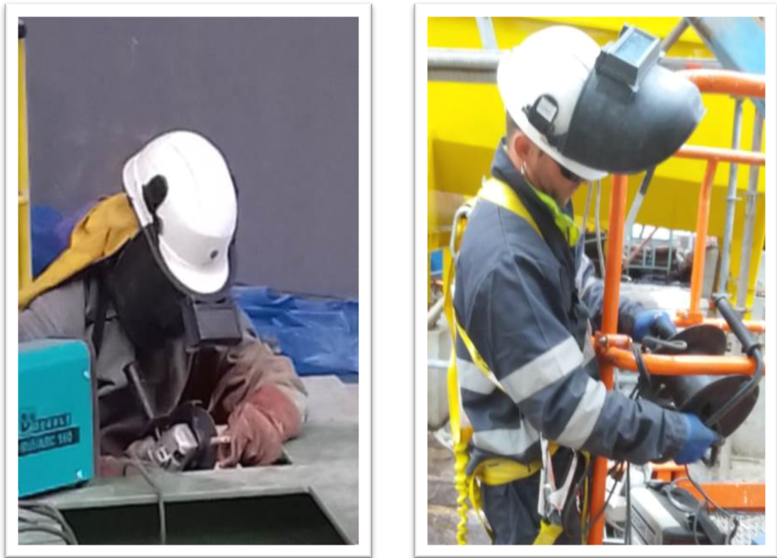
Ilustración 45. Trabajos de soldadura. Pantalla de seguridad.
