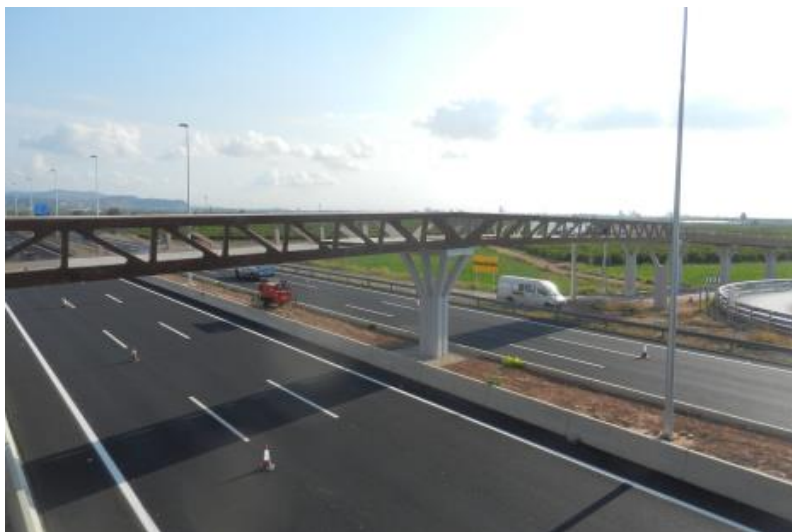
Figura 29. Pasarela Formex® Howe sobre la V-21, España.
