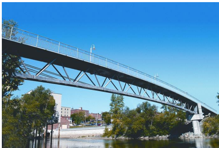
Figura 3. The Sherbrooke Pedestrian Bridge (Canadá) [11].
