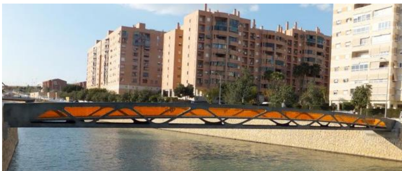
Figura 28. Pasarela de HMAR sobre el Barranco de las Ovejas, España.
