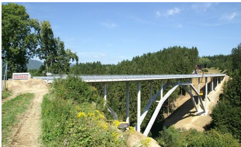
Figura 26. Puente Wild-Brücke de Mühlgraben, en Austria [125].
