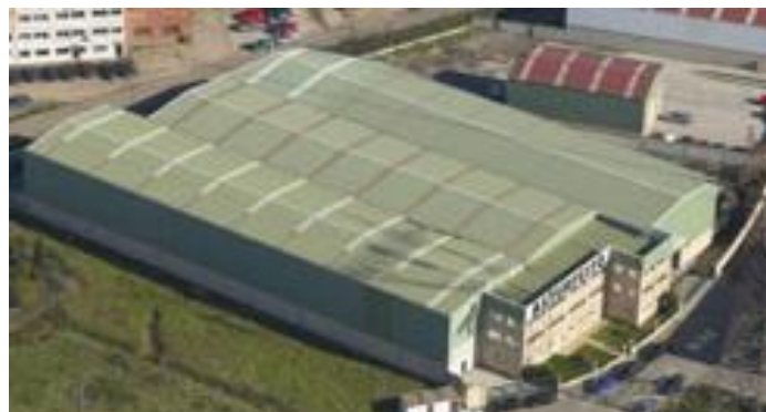
Figura 2.1. Instalaciones de Asturfeito S.A. en Tabaza [1]
