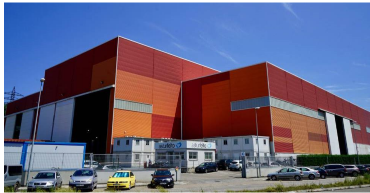
Figura 2.2. Instalaciones de Asturfeito S.A. en el PEPA [1]
