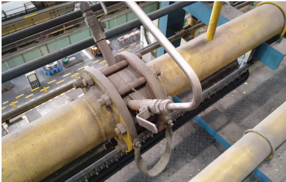
Figura 3.1. Caudalímetro de gas existente antes de la válvula de gas de cada zona.
