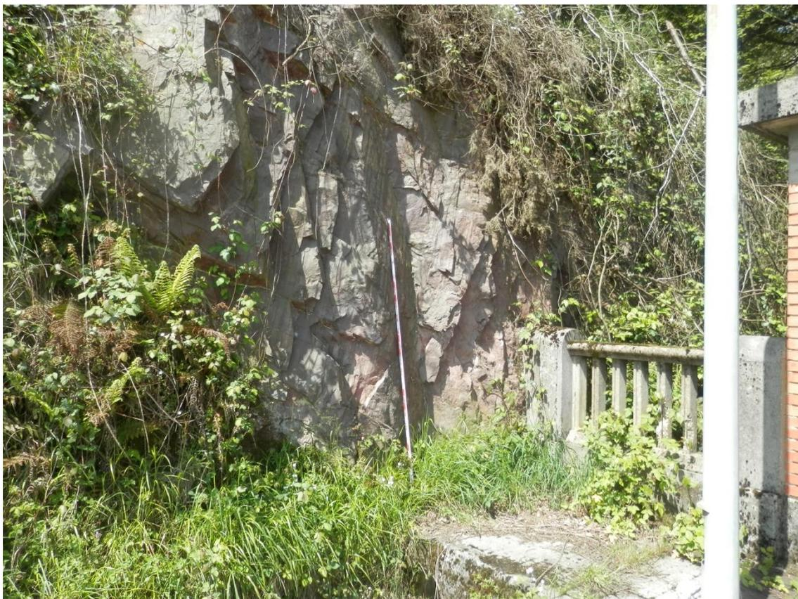
*Figura 3.32.- EG-26.2, donde se puede apreciar, gracias a las juntas observadas, que la rotura más probable es mediante cuñas. Escala gráfica: 2 m.*
