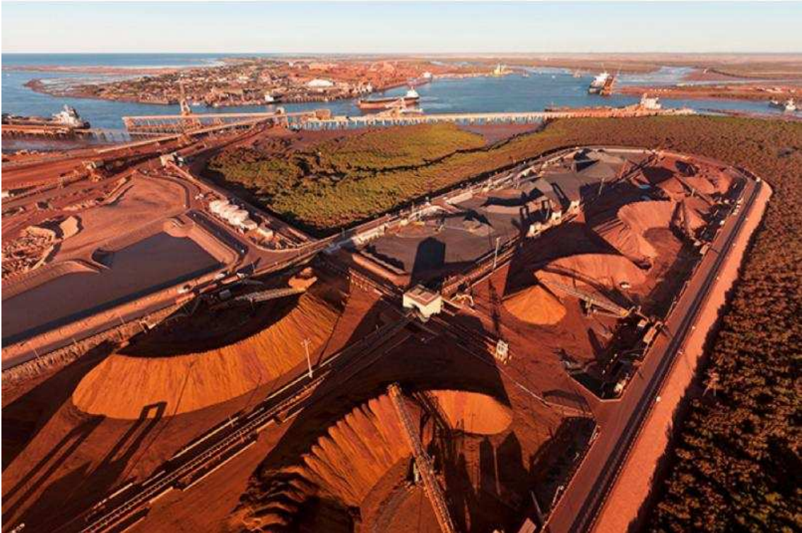
Figura 1: Vista aérea parque almacenamiento de minerales. Fuente: (Topf, 2016)
