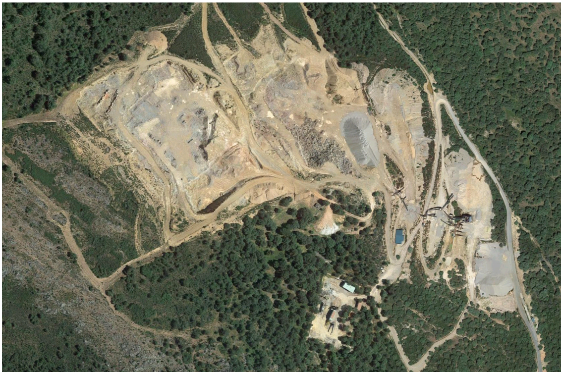
Figura 2 Vista en planta de la cantera de Torralba de áridos de cuarcita
