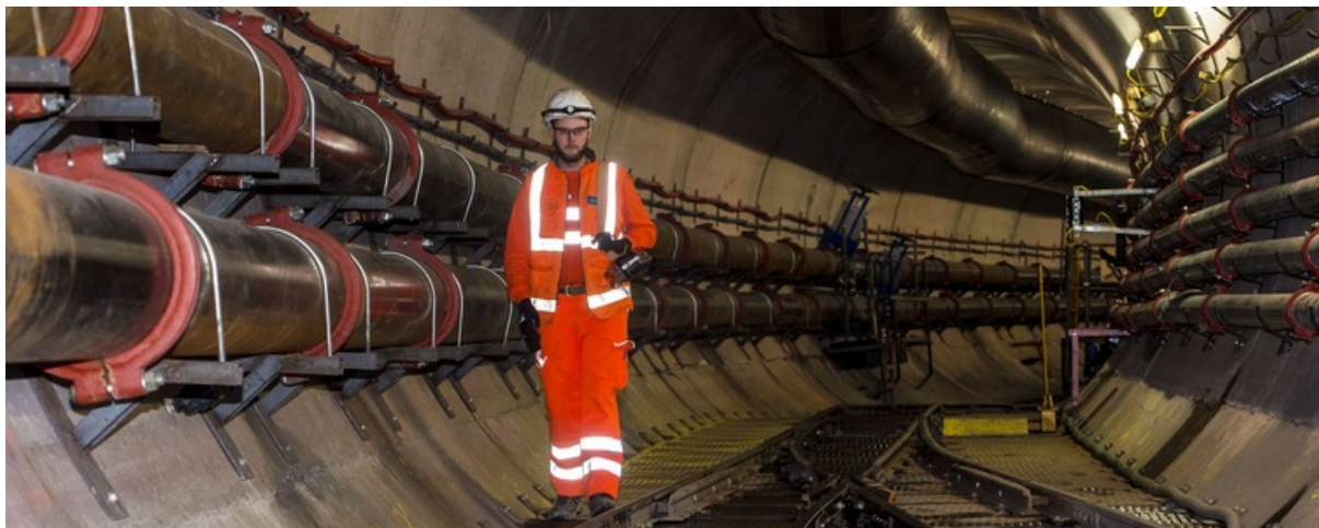
Ilustración 7. Fotografía del túnel principal durante la instalación del equipamiento.
