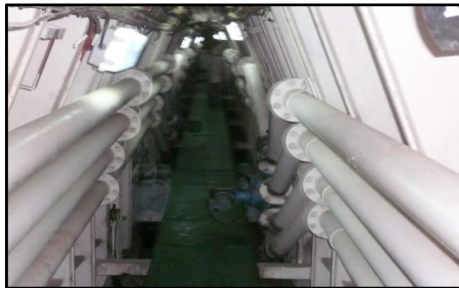
Figura 65. Túnel M/N Cementos cantábrico.
