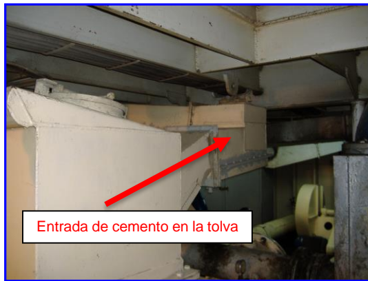
Figura 27. Entrada de cemento en la tolva.
