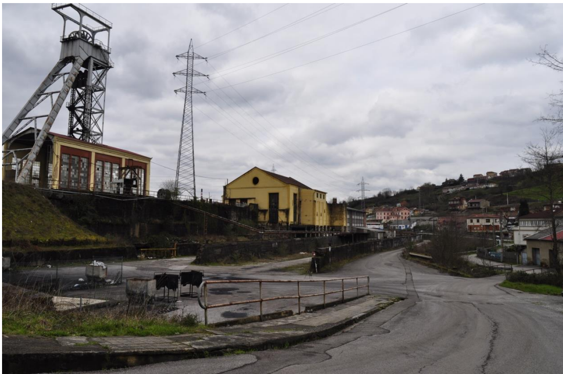
Fig.261. Castillete y pabellón de embarque del Pozo Candín, Langreo. Fotografía de la autora. A la derecha de la imagen el puente sobre el río Candín
