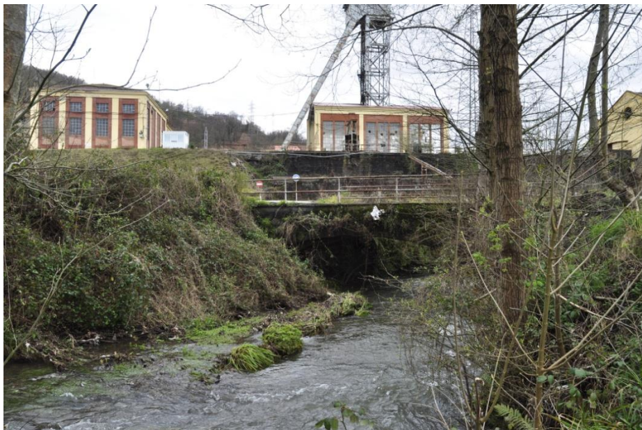
Fig.159. Instalaciones del Pozo Candín con el puente en primer plano. Fotografía de la autora
