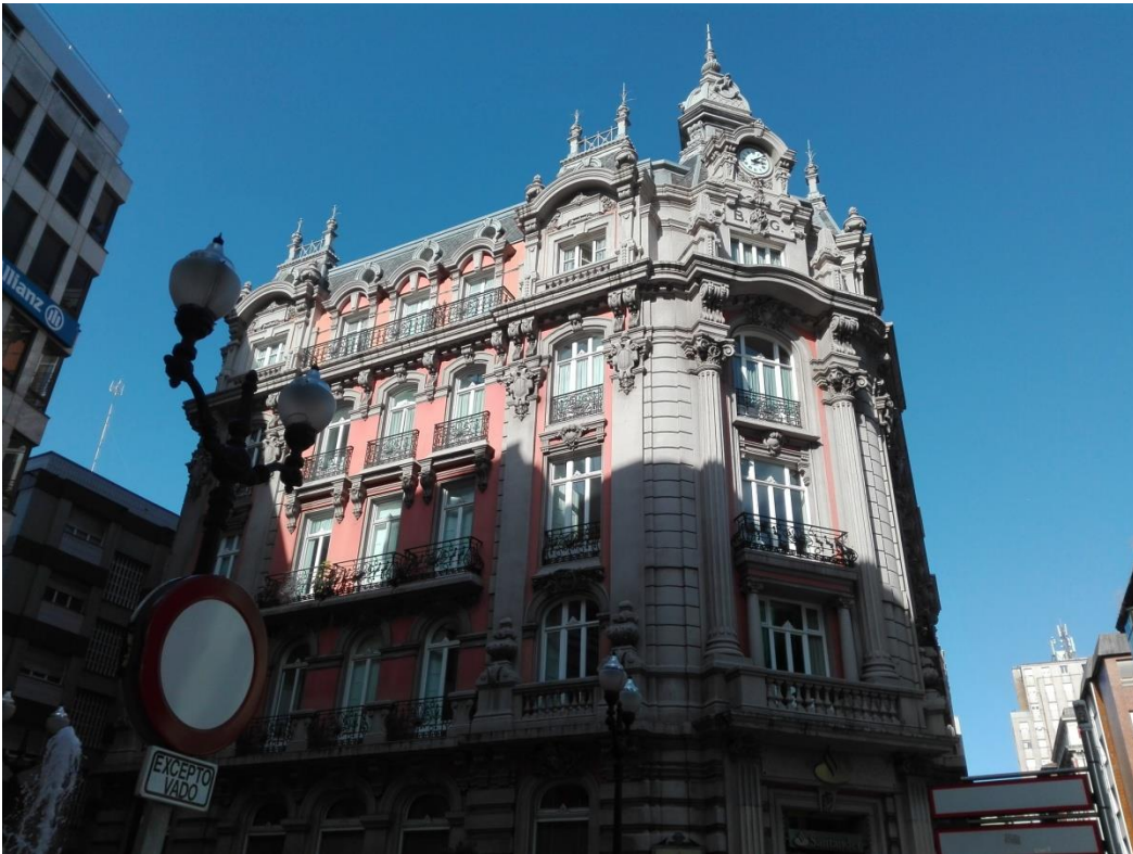
Fig.239. Estado actual del edificio del Cr dito Industrial Gijon s. Fotograf a de la autora
