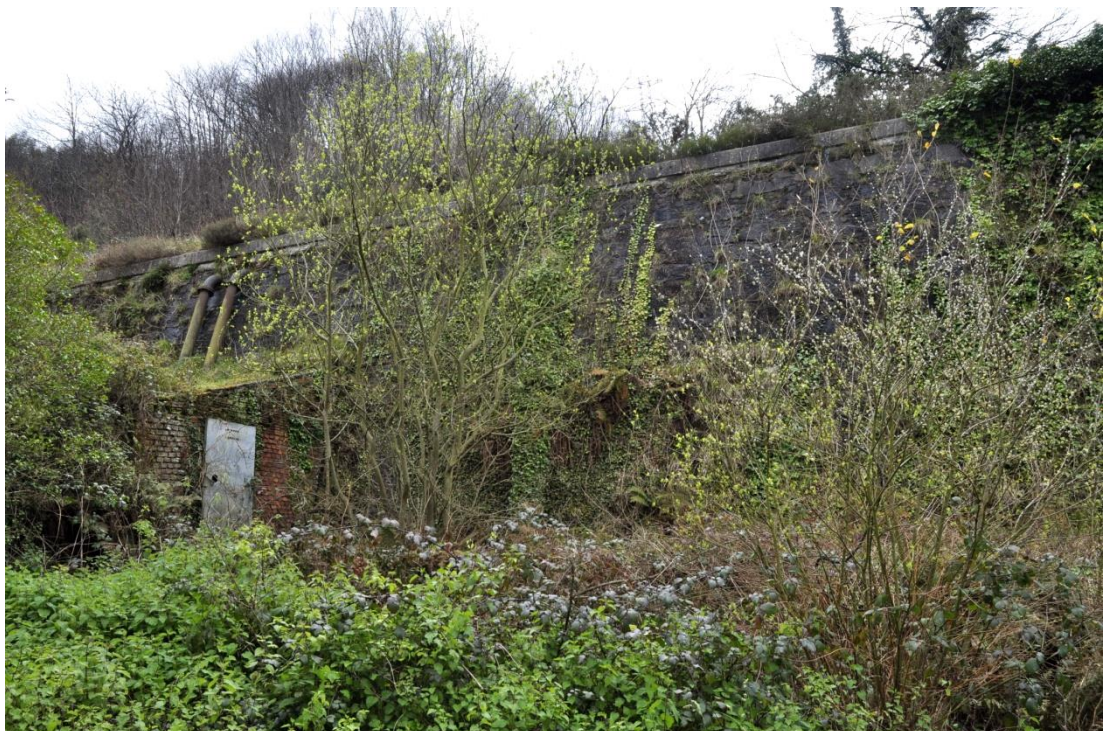
Fig.195. Depósito de aguas de Bazuelo, Mieres. Estado actual. Fotografía de la autora
