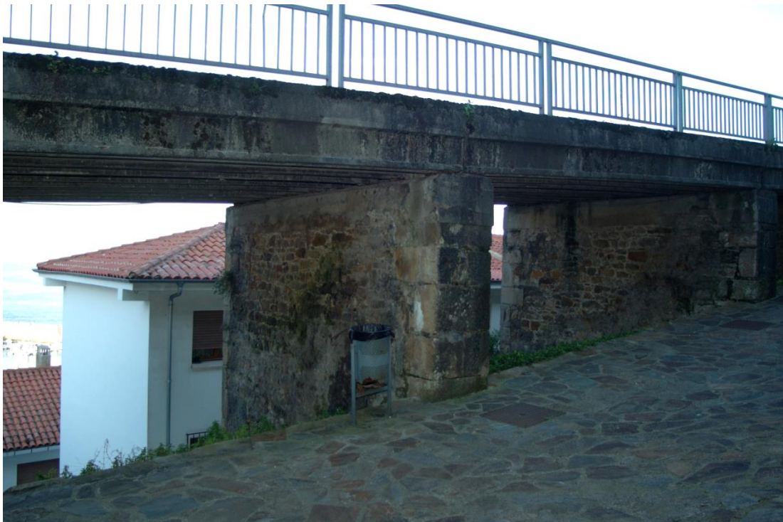
Fig.213. Estado actual del Viaducto de Lastres. Vigas y apoyos intermedios. Fotografía de la autora.
