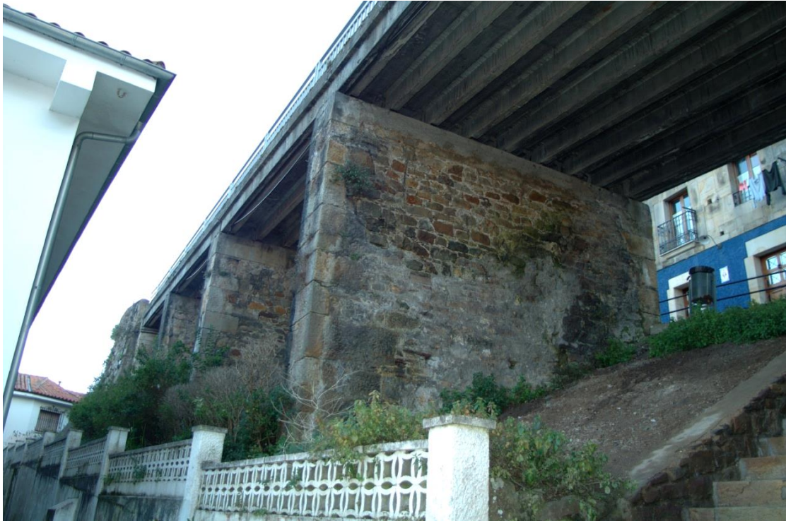
Fig.215. Estado actual del Viaducto de Lastres. Apoyos intermedios. Fotografía de la autora.
