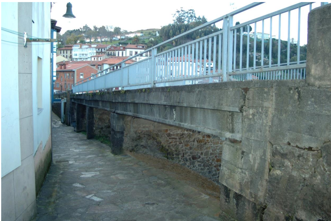
Fig.216. Estado actual del Viaducto de Lastres. Apoyo lateral. Fotografía de la autora.
