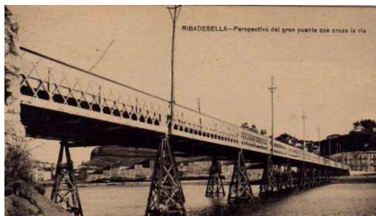
Fig.100. Tablero y palizadas del puente de Ribadesella. Tarjeta postal ©
