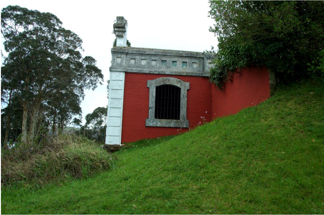
Fig.183. Depósito de aguas de Llanes. Fachada lateral de la cámara de llaves. Fotografía de la autora.
