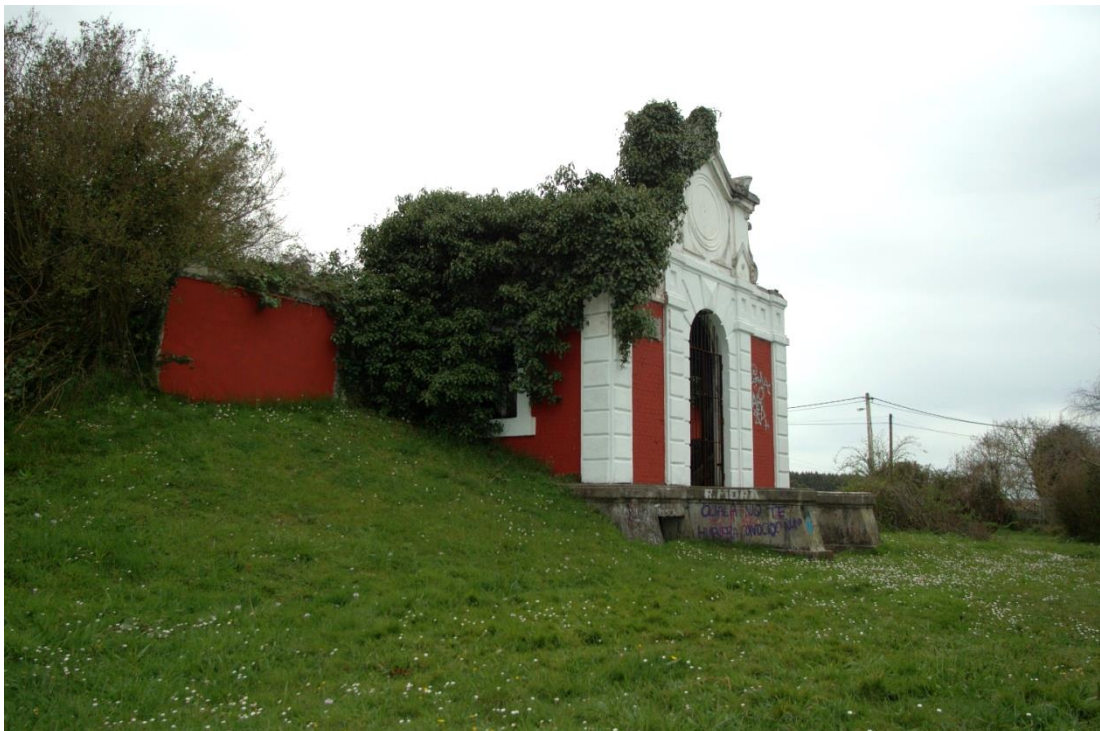
Fig.182. Cámara de llaves del depósito de aguas de Llanes. 1898. Fotografía de la autora
