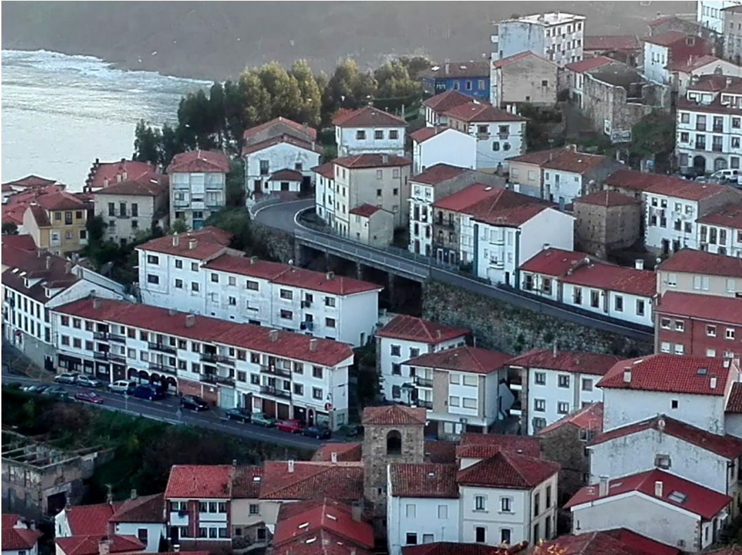
Fig.266. Viaducto de Lastres. Estado actual. Fotografía de la autora
