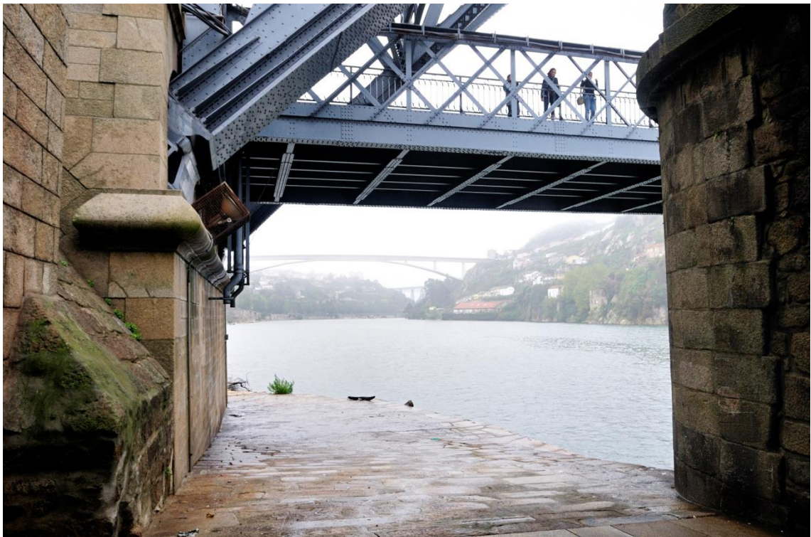
Fig.27. Puente de Don Luis, Oporto. Detalle de la rótula. Fotografía Pablo Herrero Lombardía
