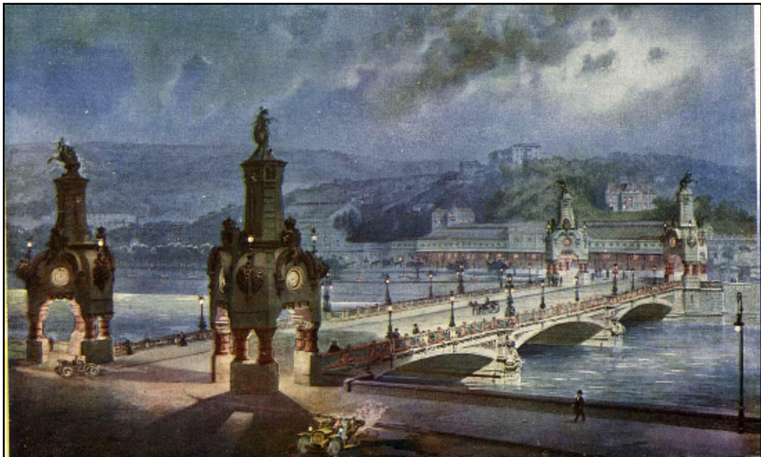
Fig.56. Puente de María Cristina, San Sebastián. Catálogo Ribera y Cía. 1910. Biblioteca Digital Fundación Juanelo Turriano
