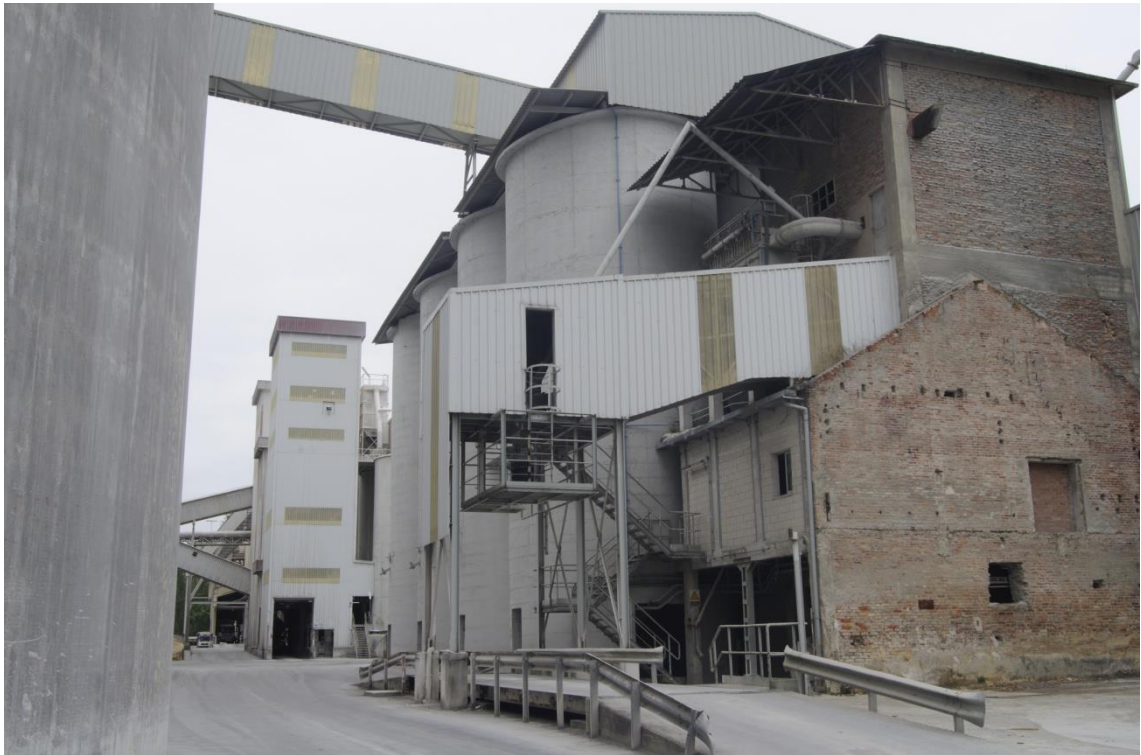
Fig.191. Fábrica de Cementos Tudela Veguín. A la derecha de la imagen los restos de los primitivos silos de almacenamiento y a continuación los actuales de planta circular. Fotografía de la autora
