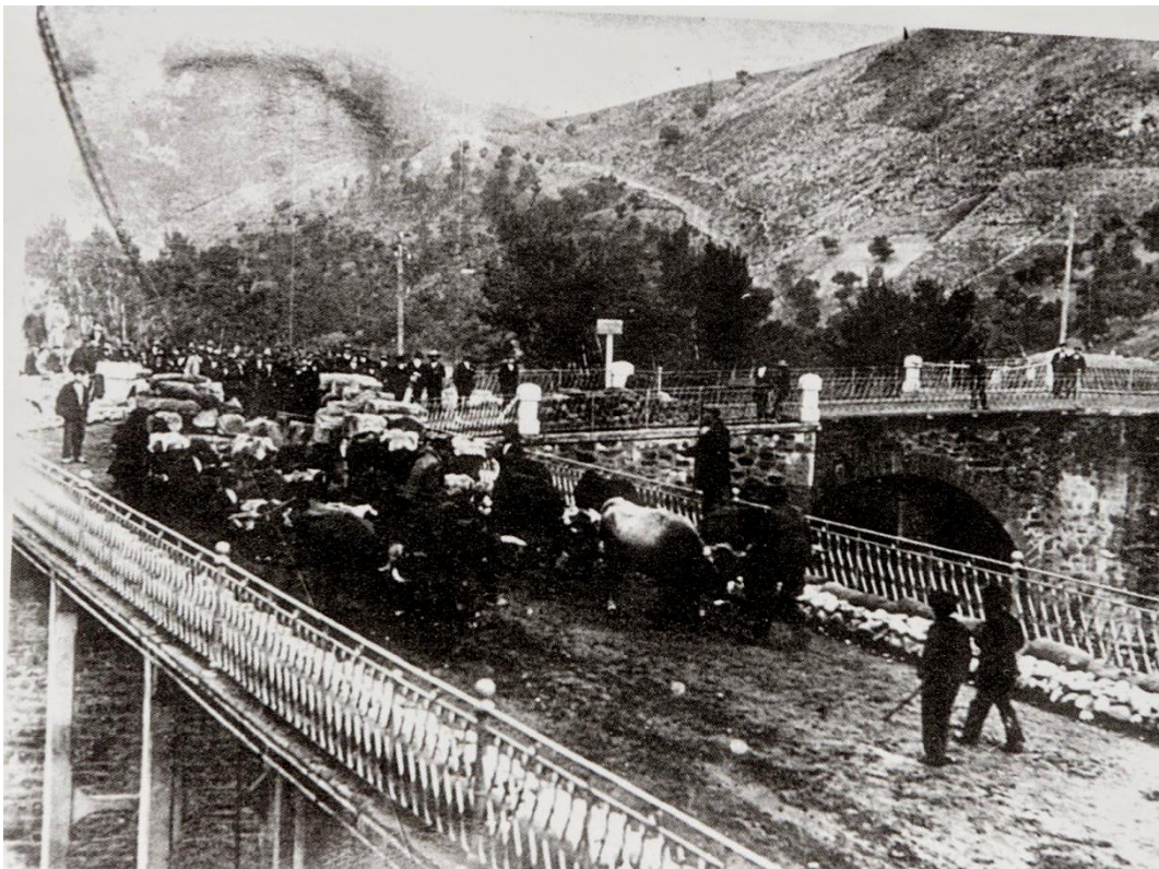
Fig.34. Viaducto de Villafranca del Bierzo ©
