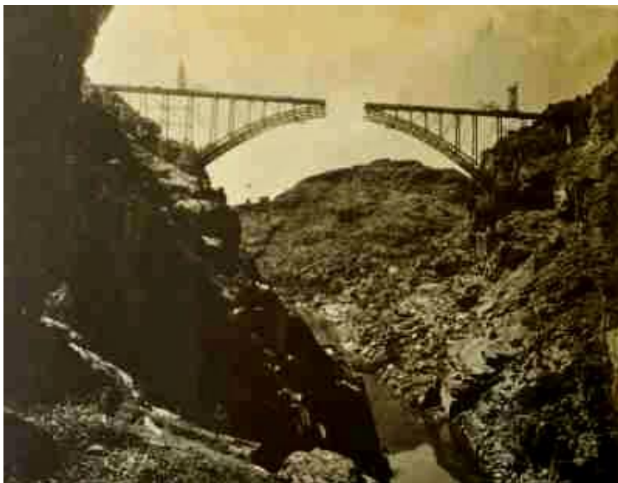
Fig.121. Montaje del puente-viaducto de Pino.1913. Revista de Obras Públicas No.2031 1914
