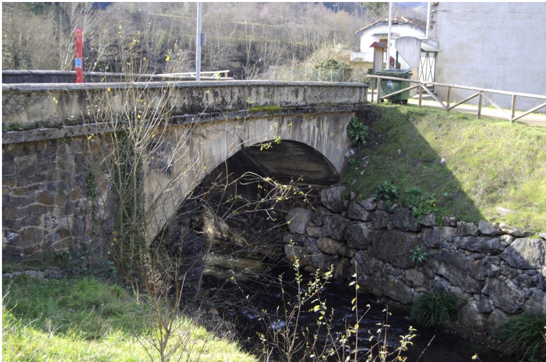
Fig.161. Estado actual del puente. Fotografía de la autora
