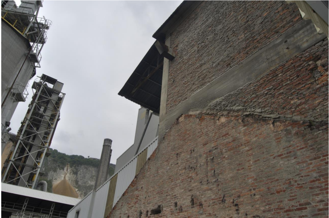
Fig.257. Restos de los antiguos silos de la fábrica Cementos Tudela Veguín. Fachada lateral. Fotografía de la autora
