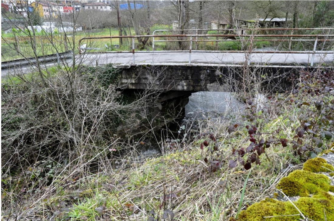
Fig.157. Ampliación de la plataforma aguas abajo. Fotografía de la autora
