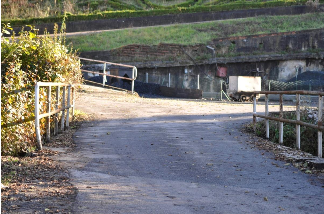
Fig.262. Puente sobre el Candín con las instalaciones mineras al fondo. Fotografía de la autora
