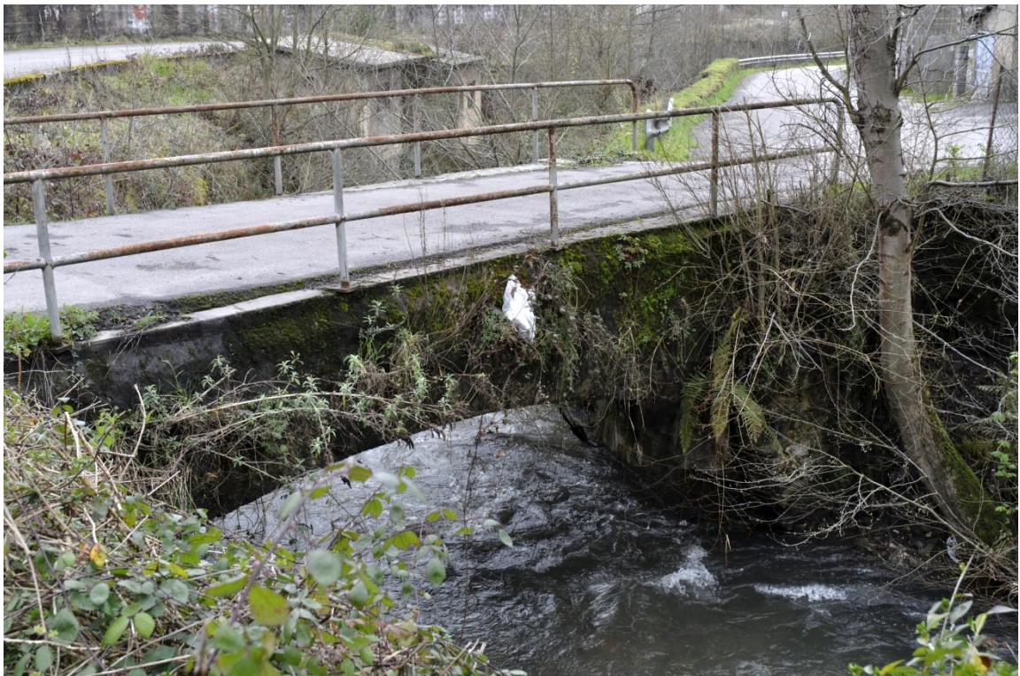
Fig. 154. Altura actual del arco de hormigón aguas arriba. Fotografía de la autora
