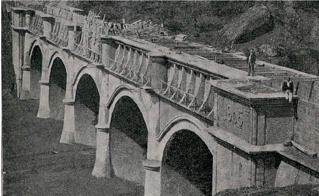
Fig.50. Acueducto de Perera, Lérida, para el Canal de Aragón y Cataluña. Tomo I de Puentes de fábrica y hormigón armado. 1925. Biblioteca digital Fundación Juanelo Turriano
