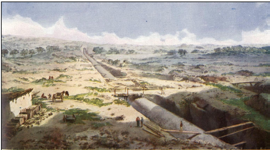
Fig.64. Sifón de Albelda en el Canal de Aragón y Cataluña. Catálogo Ribera y Cía. 1910. Biblioteca Digital Fundación Juanelo Turriano
