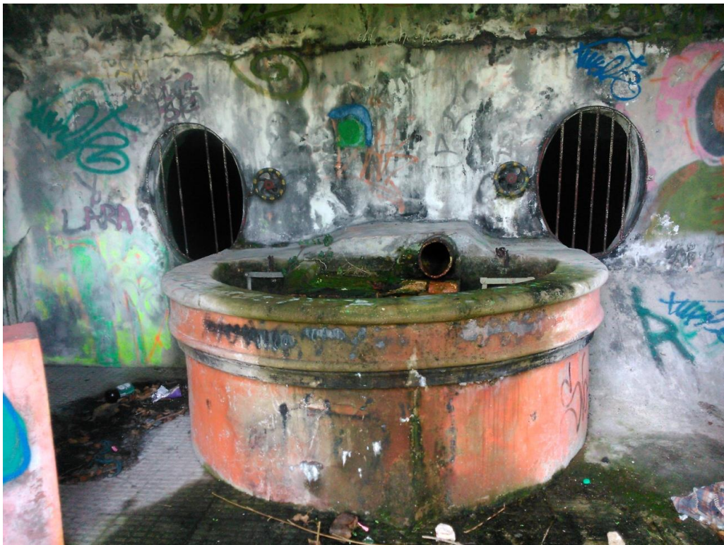
Fig.270. Interior de la cámara de Llanes. Fotografía de la autora
