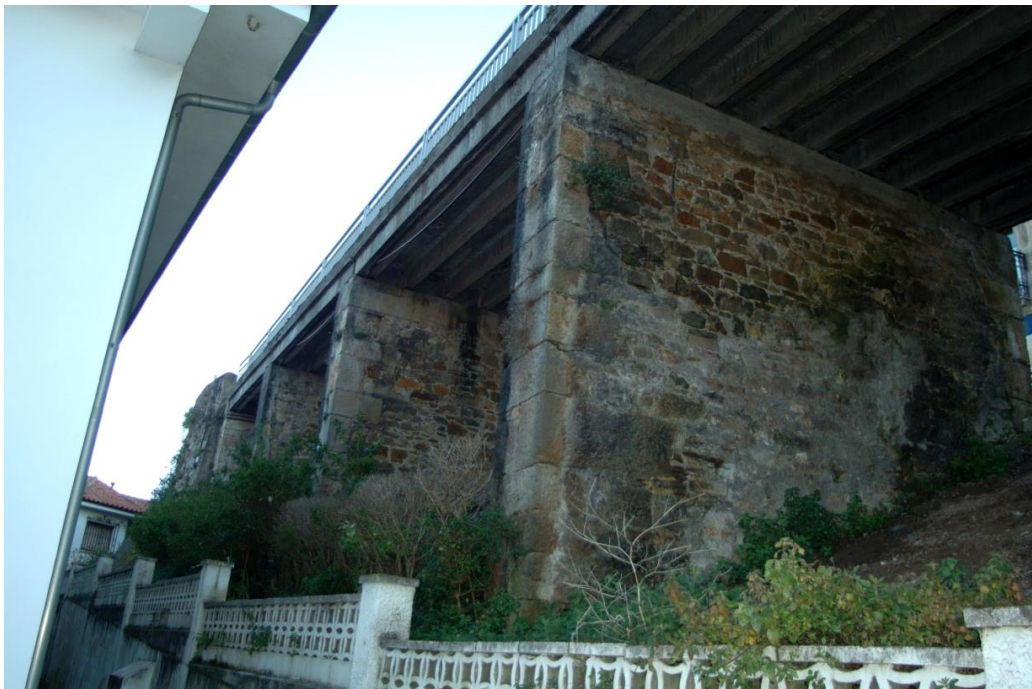
Fig.267. Viaducto de Lastres. Estado actual. Fotografía de la autora
