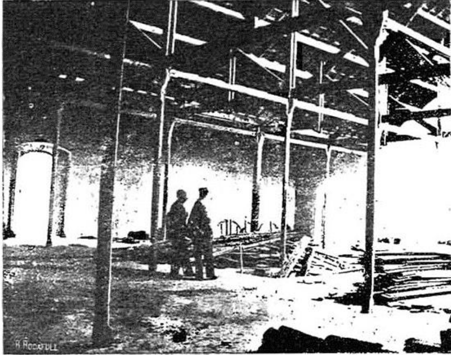
Fig.220. Almacén de la azucarera de Villalegre. Hormigón y cemento armado. Mi sistema y mis obras. 1902
