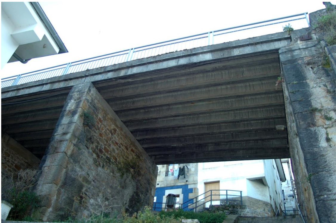
Fig.214. Estado actual del Viaducto de Lastres. Apoyo lateral. Fotografía de la autora.
