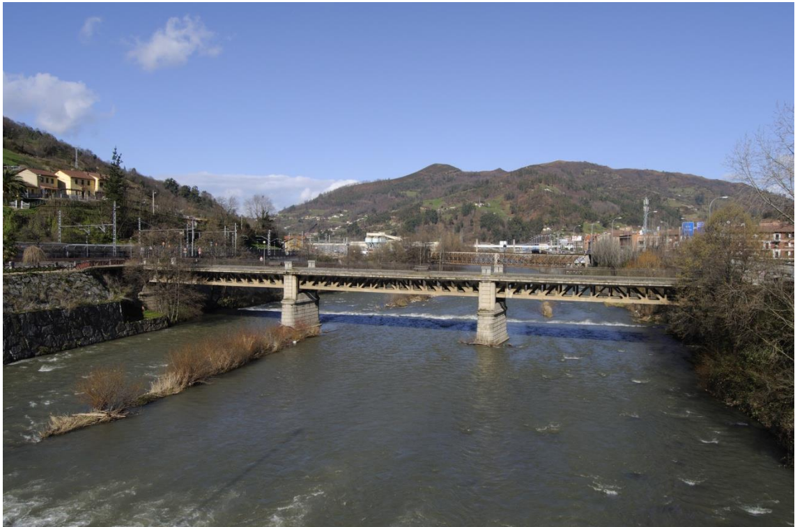
Fig.224. Puente sobre el río Caudal. Fotografía de la autora
