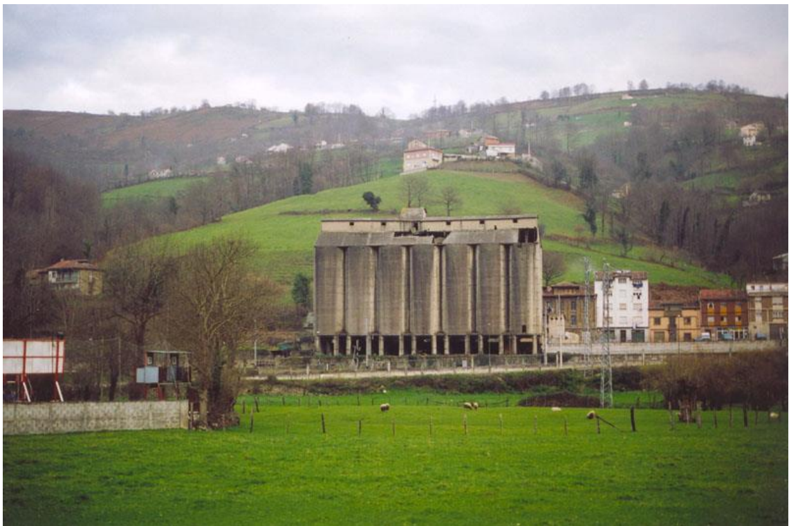
Fig.146. Tolvas de almacenamiento de carbón de la empresa Cementos Fradera en Pola de Laviana. Fotografía de la autora
