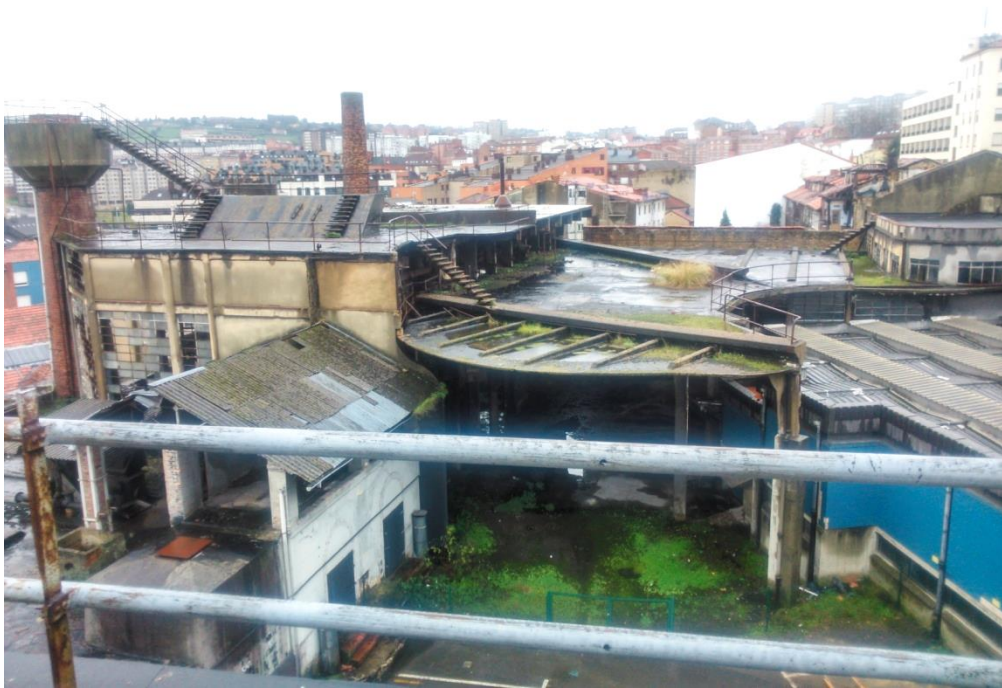
Fig.259. Fábrica de Gas de Oviedo. Interior del recinto. Fotografía de la autora
