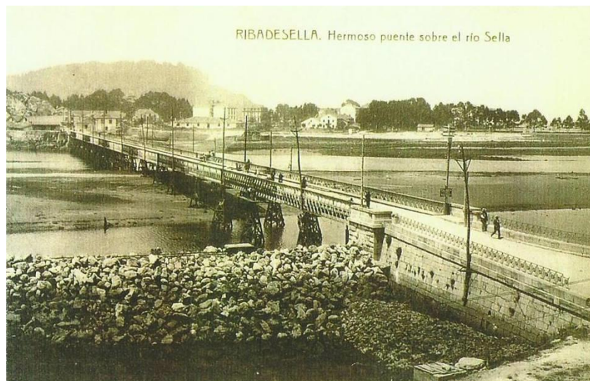
Fig.107. Estribo derecho del puente de Ribadesella en el muelle del puerto. Al fondo los barrios de El Picu y El Arenal de Santa Marina ©
