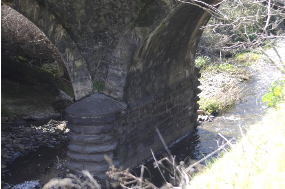
Fig.164. Detalle del apoyo central, bóveda y tímpanos. Fotografía Sara González García
