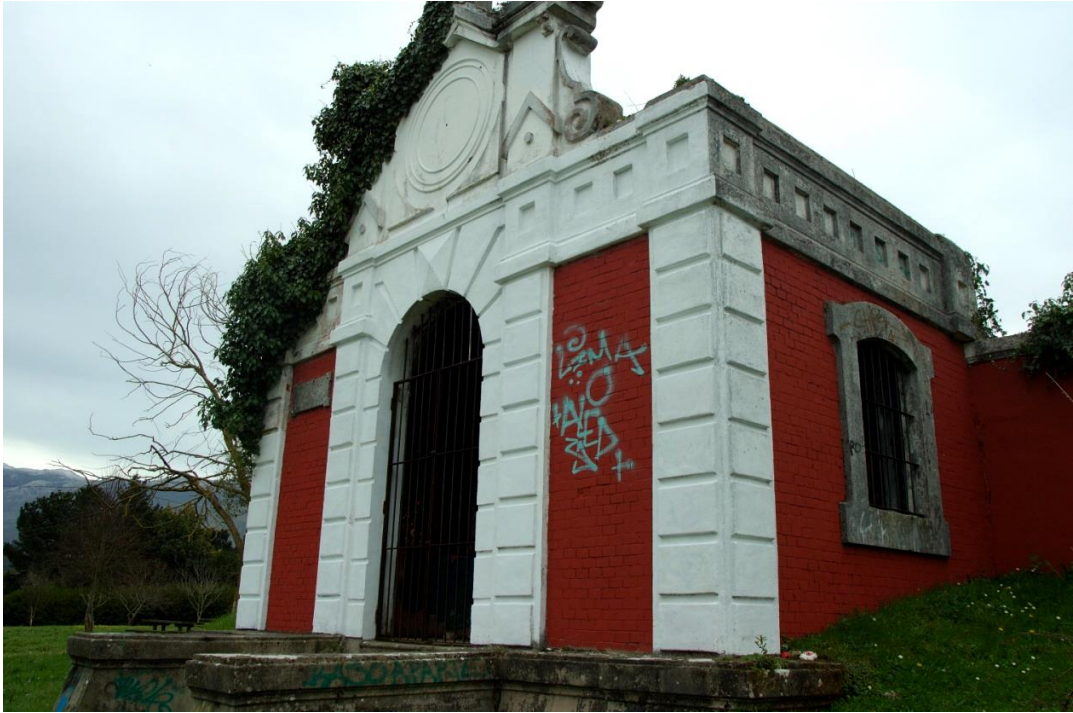
Fig.269. Fachada lateral de la cámara de llaves del depósito de aguas de Llanes. Fotografía de la autora
