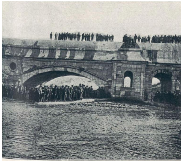
Fig.241. Inauguración de las obras del sifón de Sosa, 3 de marzo de 1906. Catálogo Ribera y Cía. 1910. Biblioteca Digital Fundación Juanelo Turriano
