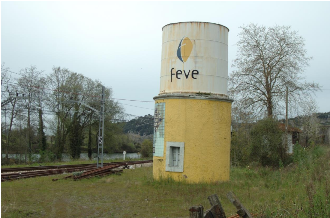
Fig.227. Depósito de agua de la estación de Llovio, Ribadesella. Vaso metálico y base de mampostería y ladrillo macizo. Fotografía de la autora
