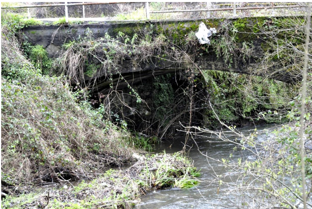
Fig.263. Puente sobre el Candín. Bóveda de hormigón en masa construida por Ribera bajo el tablero añadido posteriormente. Fotografía de la autora
