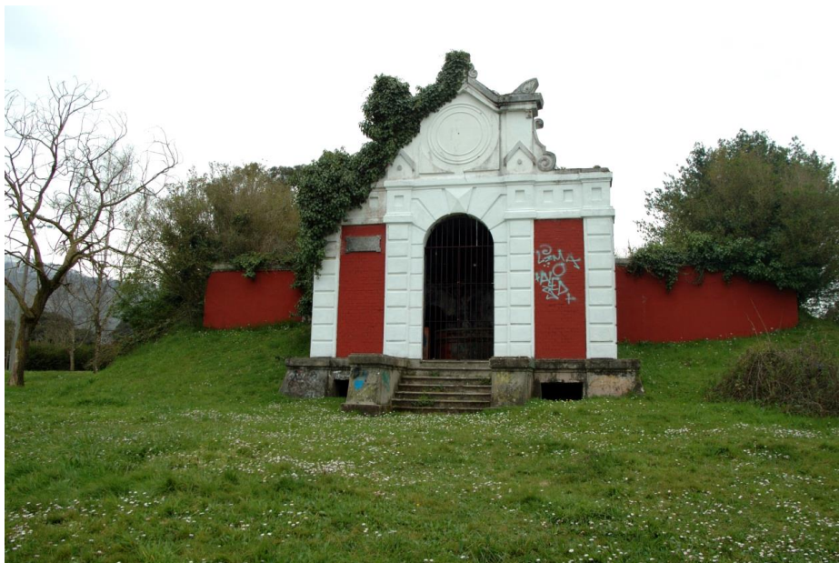
Fig.268. Fachada de la cámara de llaves del depósito de aguas de Llanes. Fotografía de la autora
