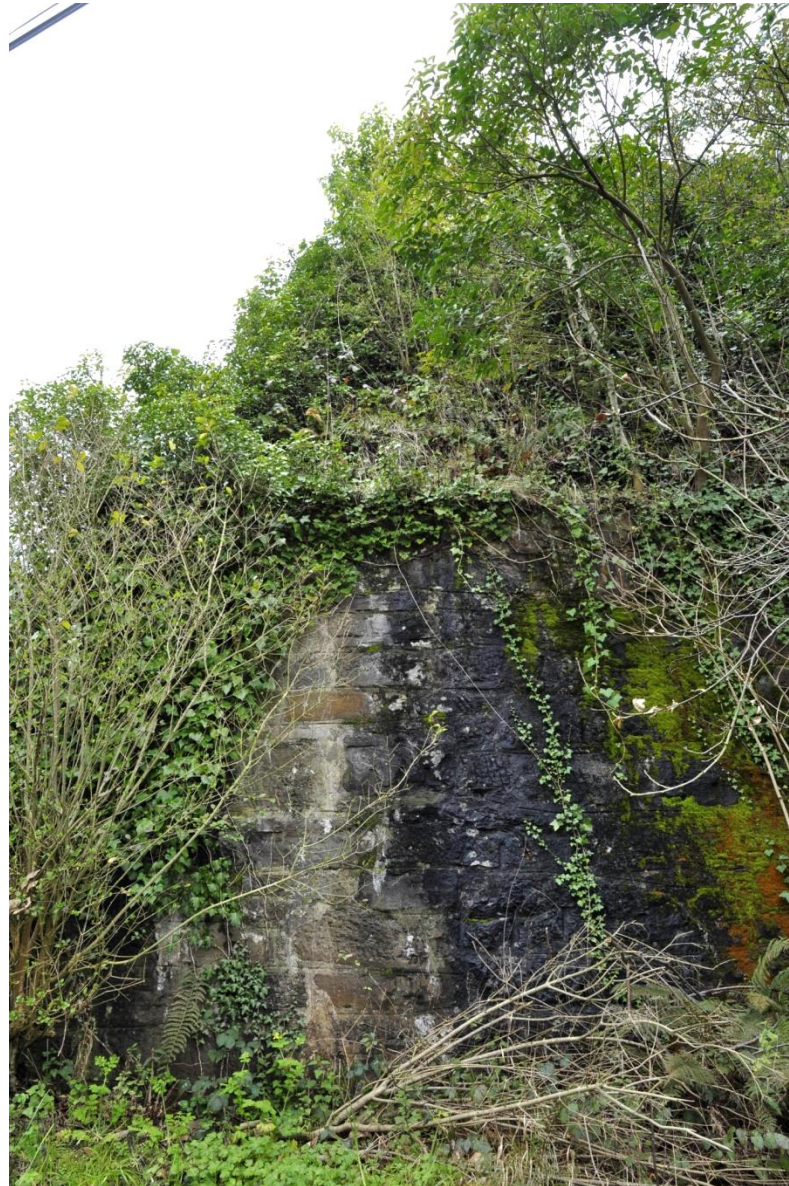
Fig.196. Depósito de aguas de Bazuelo, Mieres. Esquina noroeste. Fotografía de la autora
