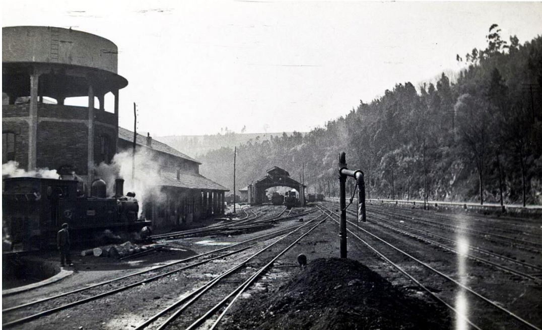
Fig.44. Instalaciones del ferrocarril Vasco-Asturiano en San Esteban de Pravia. A la izquierda el depósito elevado de hormigón armado construido por José Eugenio Ribera. Fondo fotográfico del Museo del Ferrocarril de Asturias.
