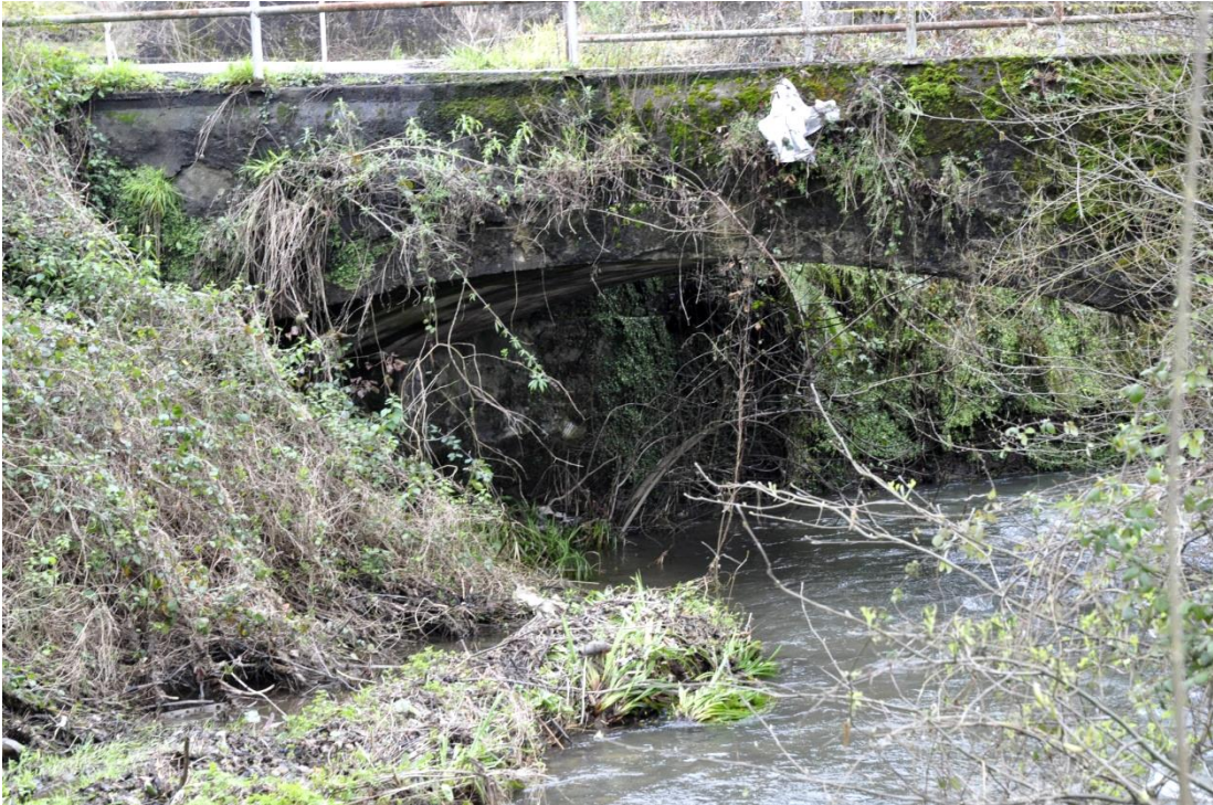
Fig.38. Puente sobre el río Candín, Langreo. Estado actual. Fotografía de la autora
