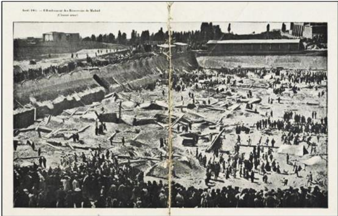
Fig.10. Cubierta del tercer depósito tras el hundimiento. Revista Le Béton Armé, abril 1905
