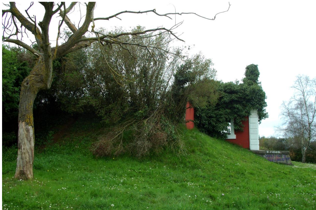
Fig.184. Depósito de aguas de Llanes. Fachada lateral de la cámara de llaves. Fotografía de la autora.
