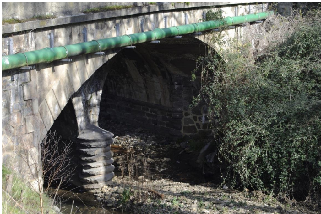
Fig. 163. Estructura primitiva del puente debajo de la actual aguas abajo. Fotografía de la autora
