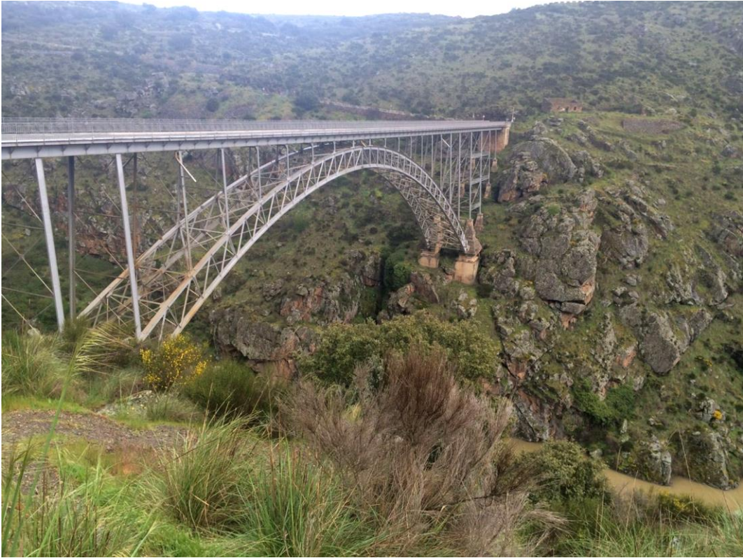
Fig.23. Puente-viaducto de Pino, Zamora. 1894-1914. Fotografía de la autora
