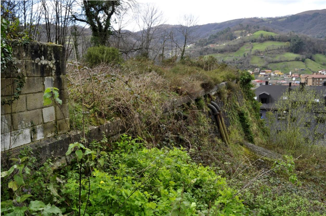
Fig.94. Depósito de aguas de Bazuelo, Mieres. Estado actual. Fotografía de la autora
