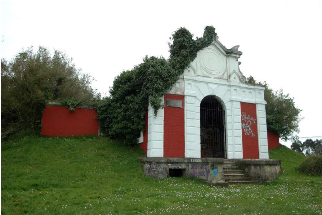
Fig-175. Depósito de aguas de Tieve, Llanes. Fachada de la cámara de llaves. Fotografía de la autora
