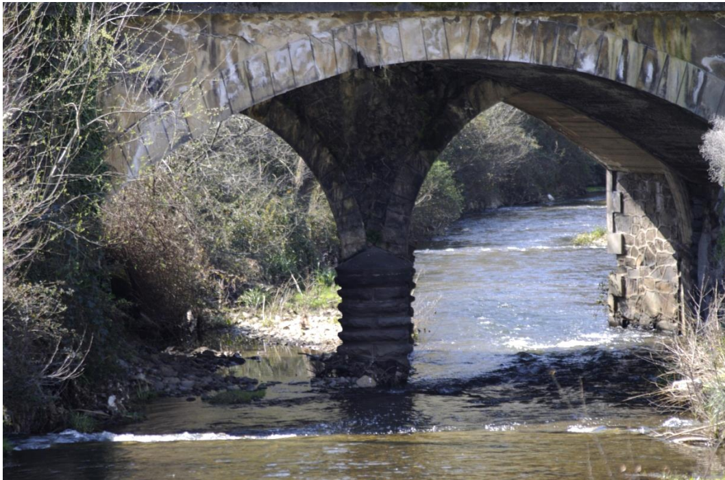
Fig.265. Bóvedas y apoyo intermedio de hormigón en masa de la obra original de Ribera bajo el tablero actual. Fotografía Sara González García
