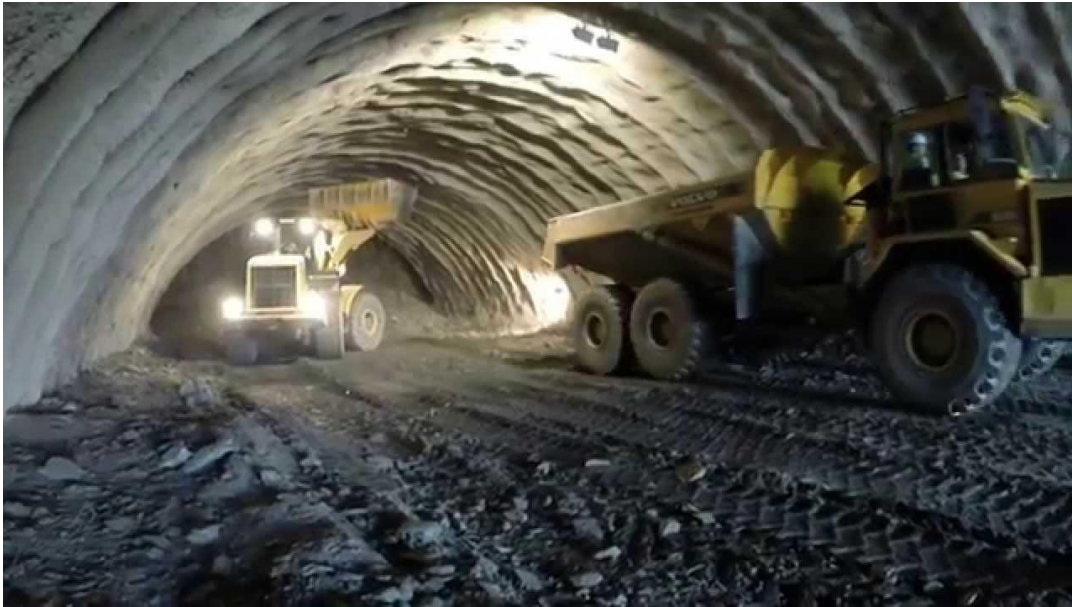
Figura 16. Ejemplo del desescombro mediante pala cargadora y dúmperes articulados.
