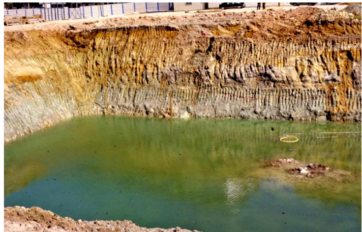
Figura I.13 – Surgencia a través de una fisura en las calizas de la Fm. Oviedo (izq.), y excavación anegada al alcanzar el nivel piezométrico dentro del Paleógeno, ejemplo de la comunicación entre el acuífero cretácico y los niveles yesíferos del Paleógeno (dcha.). Ambas imágenes fueron tomadas por M.G. Claverol.
