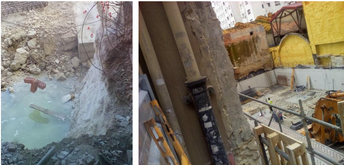
Figura II.6 – Imágenes de excavaciones activas incorporadas a la base de datos.
