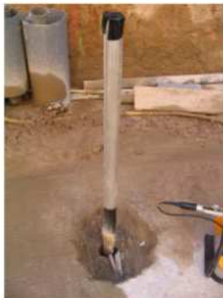
Figura nº3: Tubería inclinométrica instalada.
