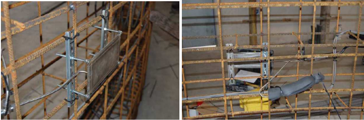
Figura nº7: Instalación de una célula de presión total en el trasdós de una dovela
