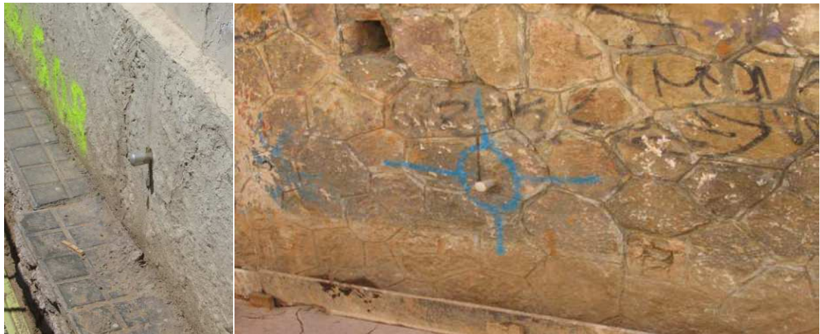
Figura nº4: Clavos de nivelación en muros para control de desplomes.
