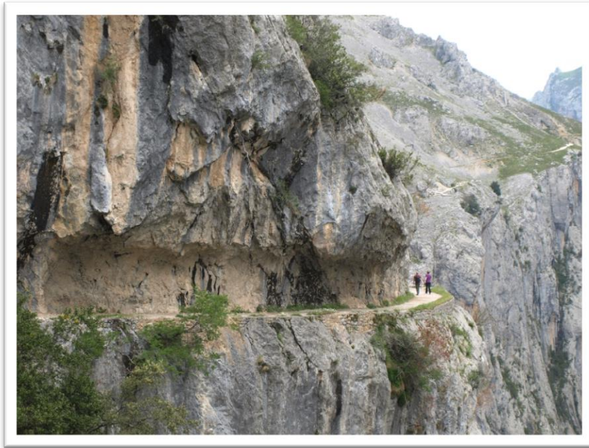
Figura 39. Tramo de senda excavado en el macizo y protegido de la caída de rocas.
