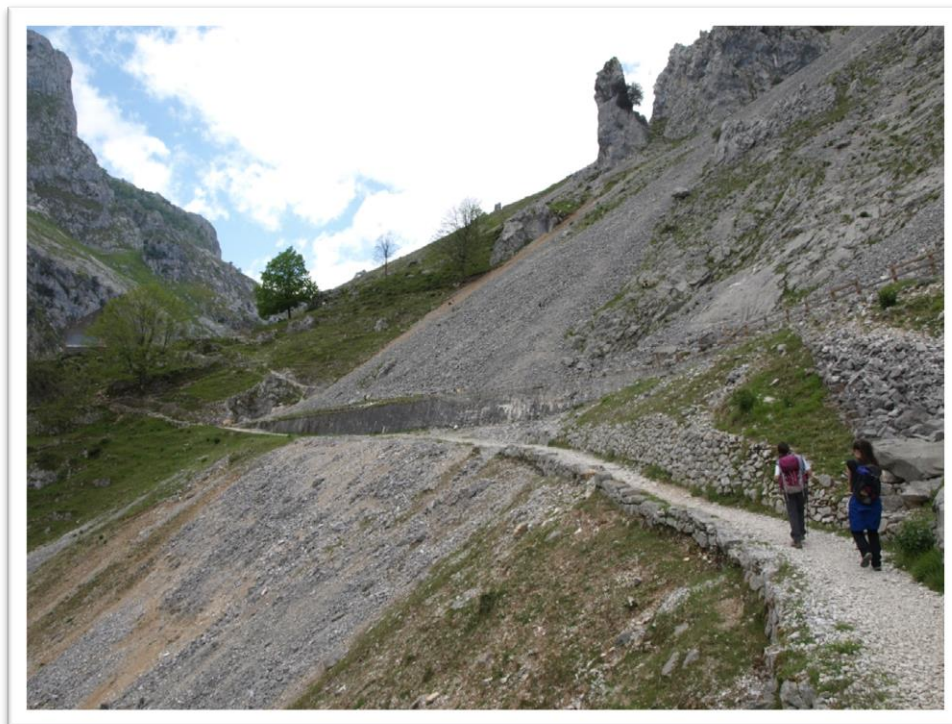
Figura 34. Área cóncava con mayor peligrosidad por impacto de roca.
