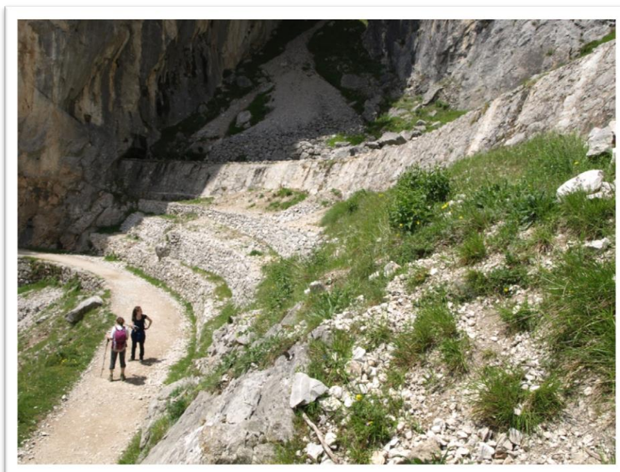
Figura 47. Muros de contención y bermas en zonas aledañas a la Senda del Cares.
