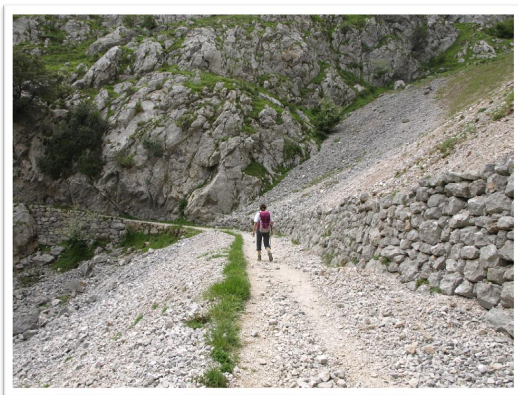
Figura 48. Pequeñas escolleras en un tramo de la Ruta del Cares
