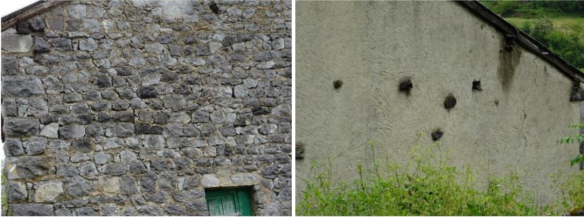
FIGURAS 29-30. Grietas en las paredes de las casas originadas por estos desplazamientos del terreno.
