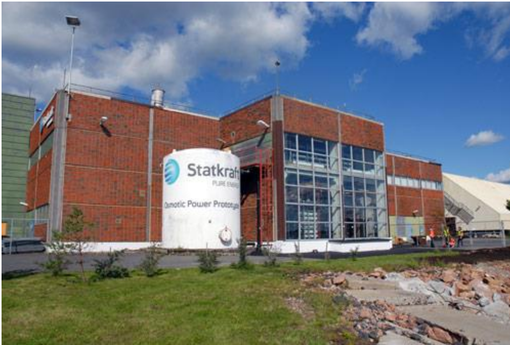
Figura 2 – Central de energía osmótica en tofte, Noruega (TECNOLOGY, S.F.)
