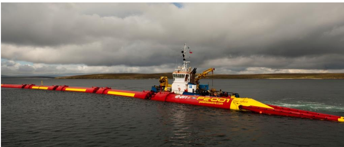
Figura 5 – Colocación del pelamis en Orkney, Escocia (POWER, S.F.)
