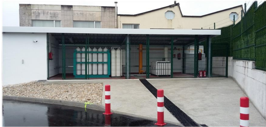
Figura 3. Caseta de zona técnica de compresión y almacenamiento
