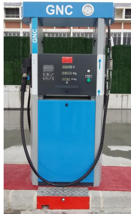
Figura 5. Zona y surtidor de Gas Natural Comprimido
