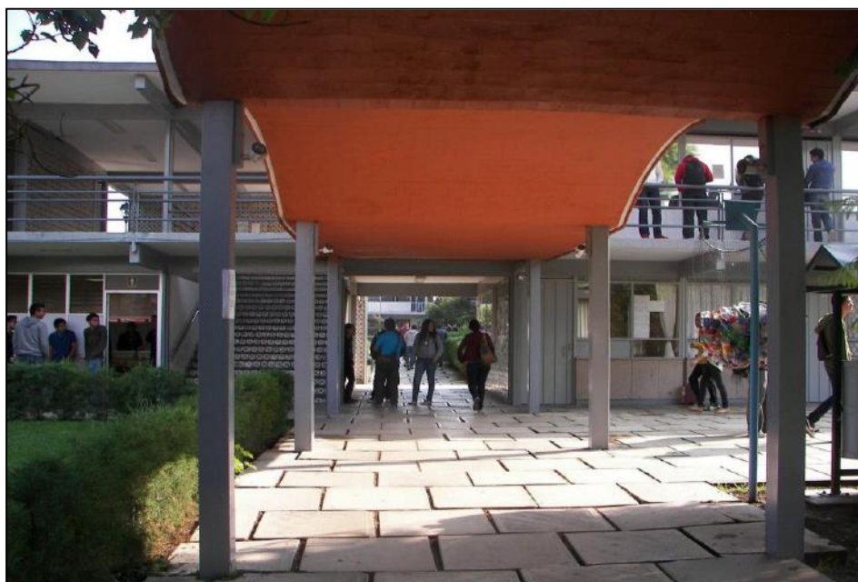
Imagen 2.4. Pasillos del Instituto Tecnológico de Morelia
