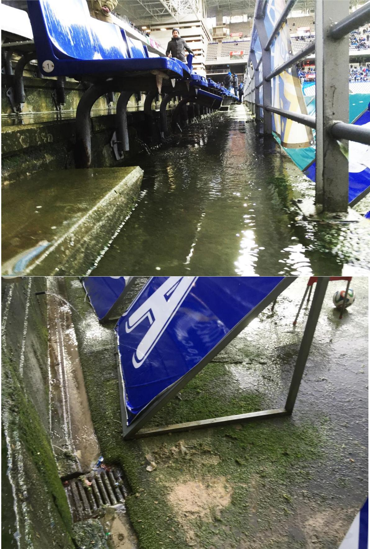
*Figura 4.23: Surgencias de agua bajo los asientos del estadio en tiempo de lluvias. Estas aguas vierten directamente al terreno de juego sedimentando arenas de grano medio amarillentas. Tomada en marzo de 2015.*
