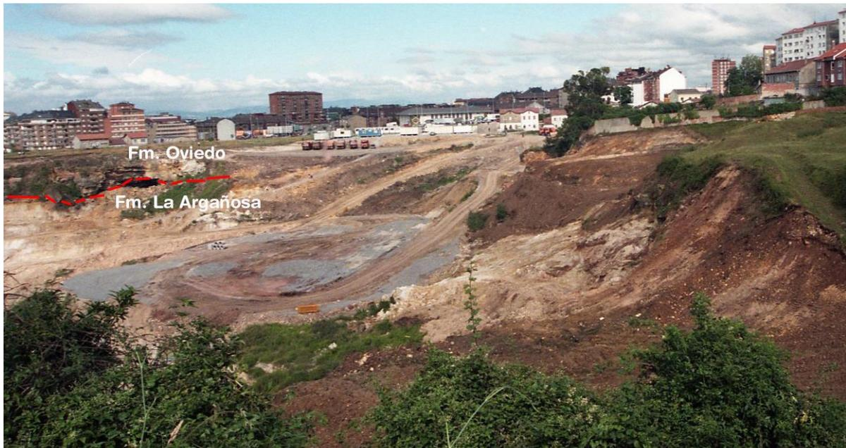
Figura 4.16: Fotografía del mes de julio del año 1998 desde el talud oeste. Se observa el proceso de desmonte del talud este con el contacto entre la Fm. Oviedo y la Fm. La Argañosa. Su geometría corresponde a la existencia de karstificación y la entrada de una galería para explotar las arenas de la Fm. La Argañosa en el límite con la Fm. Oviedo (cortesía LNE)
