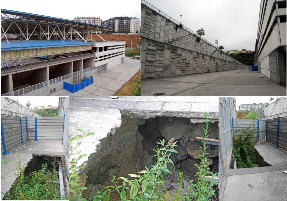
*Figura 4.28: Localización del hundimiento, de unos 1,50 m de profundidad, del pavimento en la calle de acceso al fondo sur del nuevo Estadio Carlos Tartiere. La zona se encuentra vallada en la actualidad.*
