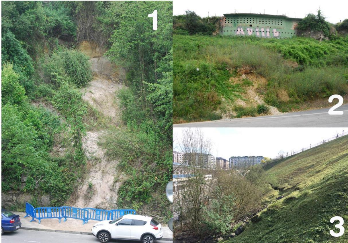
Figura 4.19: Punto 1: Movimiento de ladera (argayu) ocurrido en el mes de mayo de 2015, tras una intensa semana de lluvias en el talud oeste del área de estudio. Nótese los materiales implicados: arenas siliciclásticas blanco-amarillentas muy disgregadas. Punto 2: Movimiento de ladera en el talud este del área de estudio. Punto 3: Cicatriz erosiva y formas provocadas típicamente en taludes inestables.
