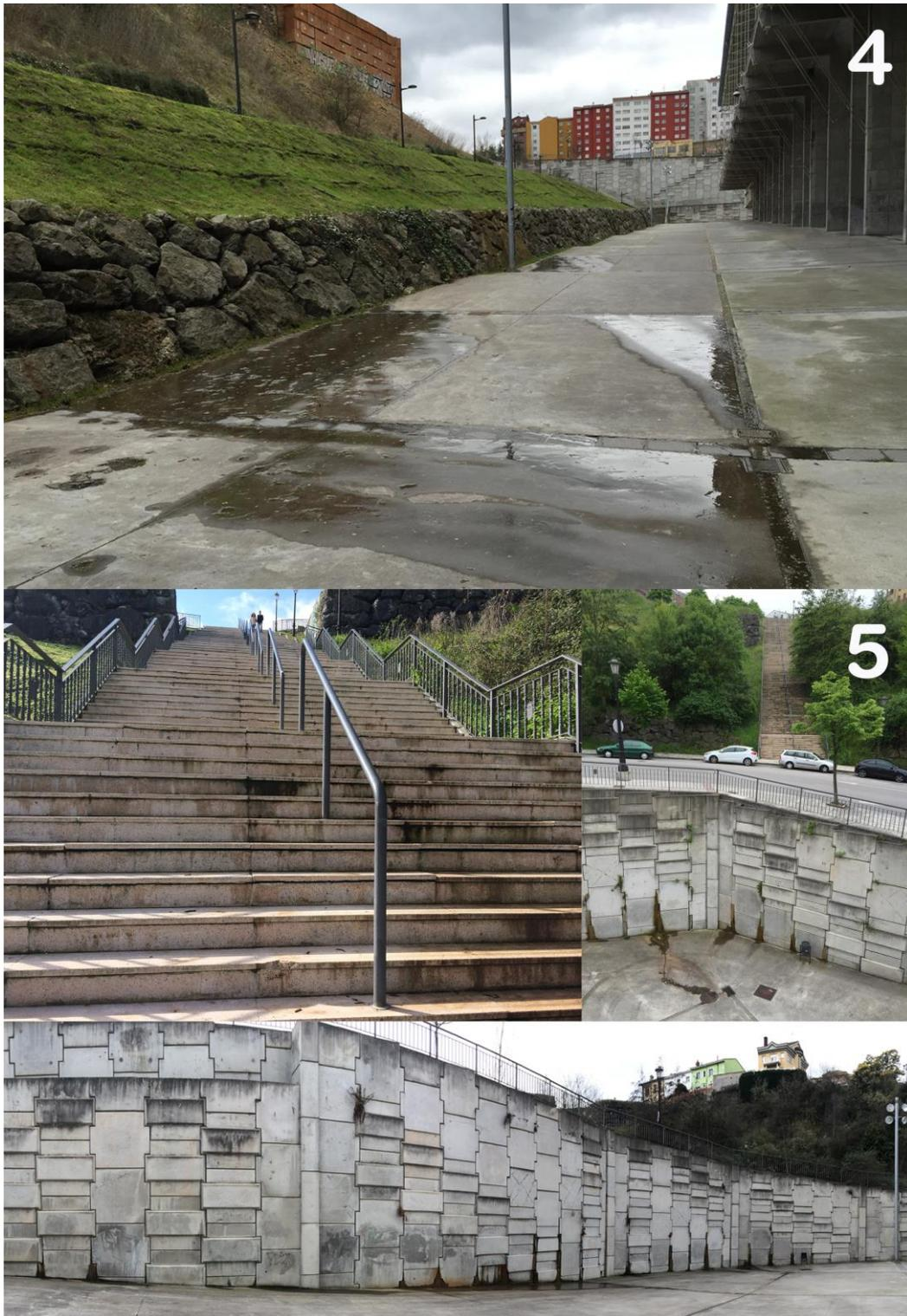
Figura 4.20: Punto 4: Surgencias de agua en el talud este del área de estudio, que se filtra bajo la escollera. En el Punto 5: Se observa la zona SO del área de estudio, con gran presencia de filtraciones y humedades a lo largo del muro pantalla y la vaguada que ocupan las escaleras de acceso al barrio de El Cristo.
