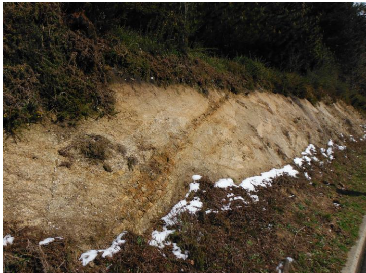
Figura 21. Talud de carretera donde se aprecia la alteración en el granito y su color característico (UTM: 675693, 4812365)
