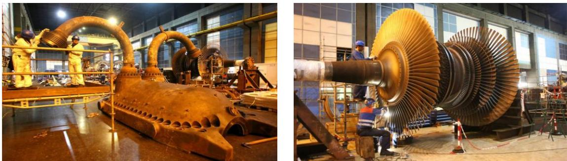
*Figura 3. Ejemplo de trabajos de inspección turbina durante una Revisión General de una Central Térmica.*
