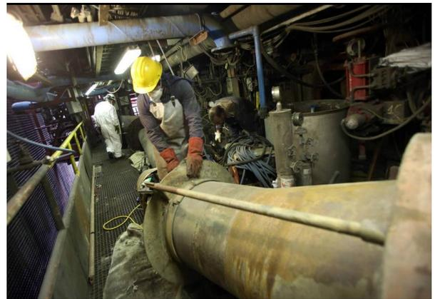
*Figura 4. Ejemplo de trabajos en caldera y auxiliares durante una Revisión General de una Central Térmica.*
