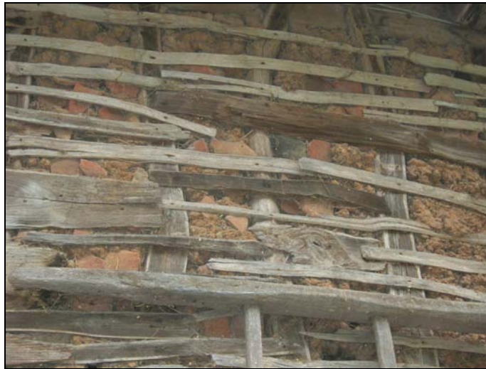
Fig. 107 c. Detalle de la carga de arcilla, piedra y tejas que cubre las juntas del entramado de listones en el frente occidental más húmedo.
