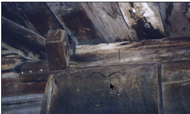
Fig. 161. La flecha señala la serpe sobre colondra, un motivo protector habitual en los hórreos y paneras acaicos, común nuevamente al ejemplar de Vallinaoscura.
