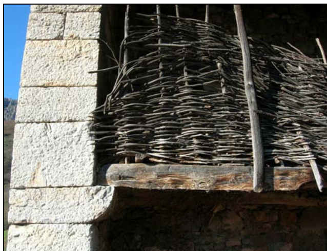
Fig. 119 a. Puede apreciarse la fábrica mixta, con el excelente careado de los sillares en el muro cortafuegos y la imposta sobre la que apoya el xebatu.
