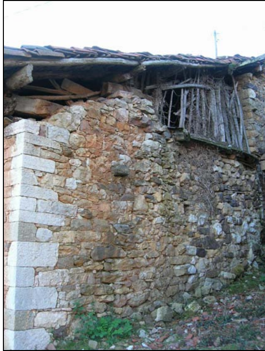
Fig. 117 c. Lateral de la construcción, en el que se observa la precisa fábrica de sillares del esquinual, el desmochado de la testa y la nueva y ruda techumbre, acompañada del pequeño recreado lúneo.
