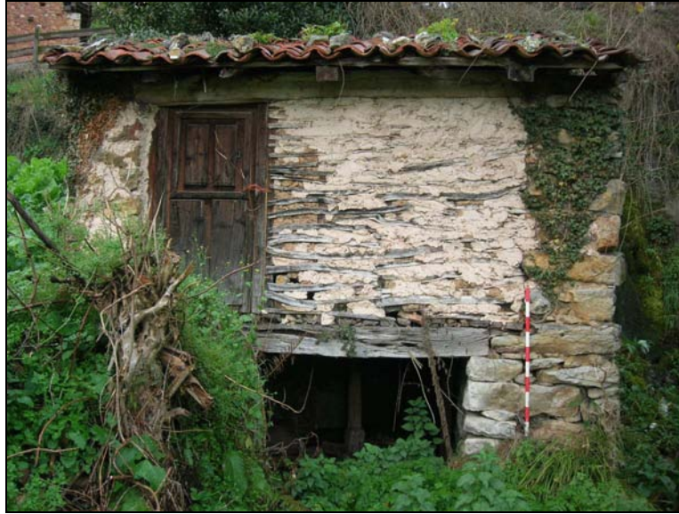
Fig. 213. Fachada frontal del molino del Real
