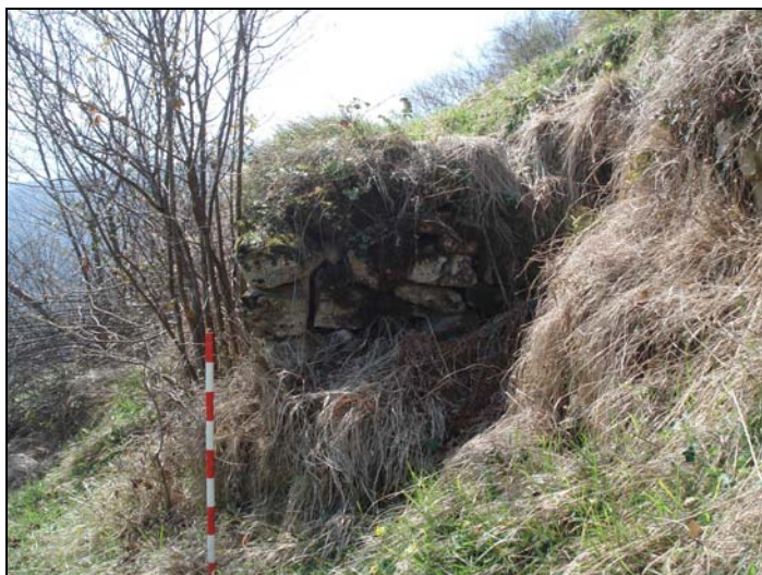
Fig. 175. En ocasiones, el parapeto sobresale con respecto a la línea del bancal, permitiendo ganar espacio a la terraza.
