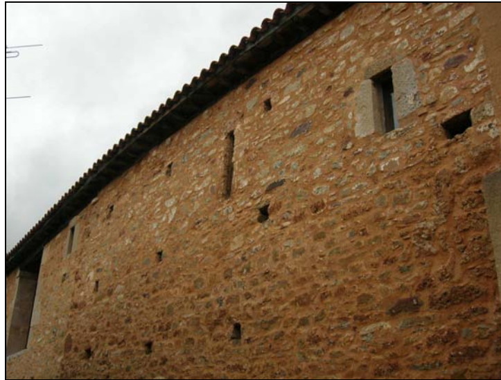
Fig. 13 a. Puede apreciarse la diferencia entre el vano abocinado de la iglesia románica y el vano adintelado de la reforma iniciada en 1797
