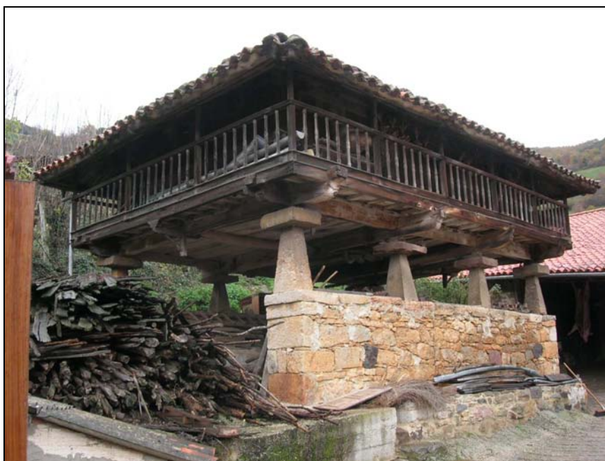
Fig. 173. Panera de los Muñiz Prada en la antojana de su palacio. Ocupa el solar de otra panera citada en 1752 y representa el modelo más refinado y reciente de la aldea, propio del XIX, como confirman los pegollos de cantería isódoma sobre banqueta de mampostería y el largo corredor con balaustres a torno.
