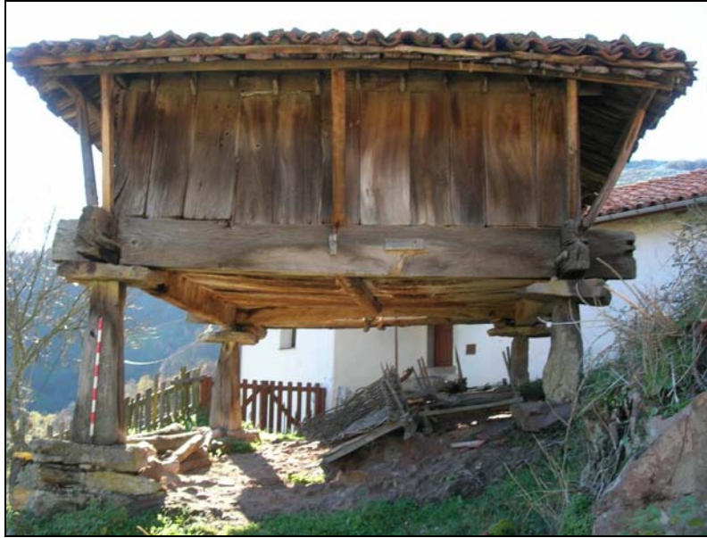
Fig. 142 a. Hórreo desde el NW. Se aprecian los tentemosos sobre los que apoya el amplio faldón. El peso de la caja y la cubierta ha arqueado los traveses y las pontas y sobigaños del suelo.
