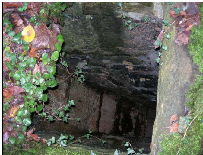
Fig. 211 c. Interior del cubo, con una fábrica de sillares que señala un notable cambio en la tecnología constructiva con respecto a los molinos precedentes.
