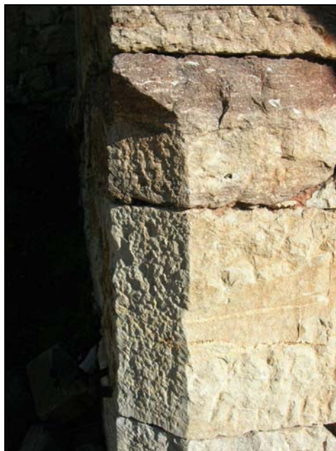
Fig. 104. Esquina moldurada con rebaje a listel, muy empleada en las arquitecturas del XVII-XVIII, incluyendo los hórreos.
