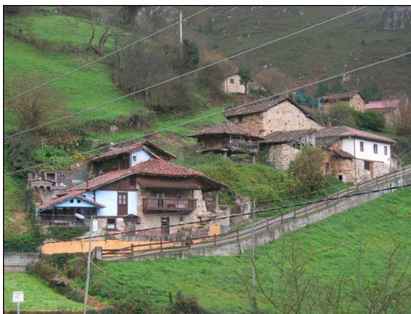
Fig. 20. Barrio del Campal en la subida desde la plazuela del Real.
