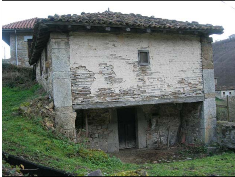
Fig. 120. Fachada frontal, con la pallareta en voladizo. Se aprecian los esquinales de sillería labrada y en contraste, el entramado de tablillas con carga externa de la pallareta.
