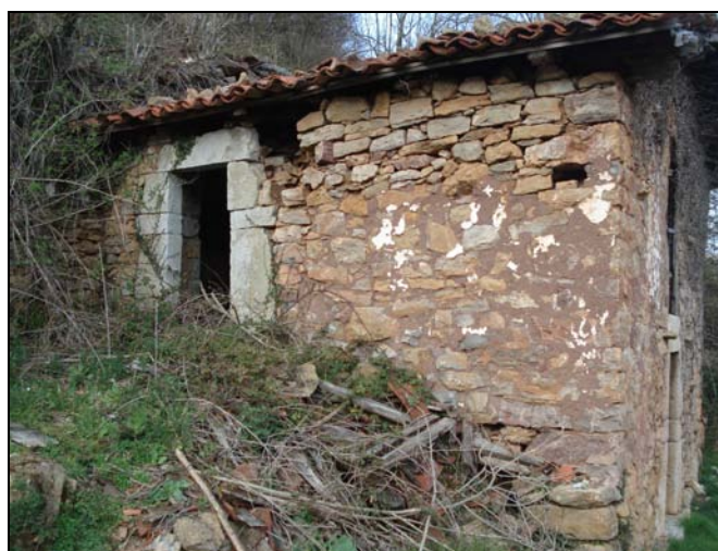
Fig. 83 b. Lateral de la vivienda, con la puerta en cantería y los restos de revoco encalado
