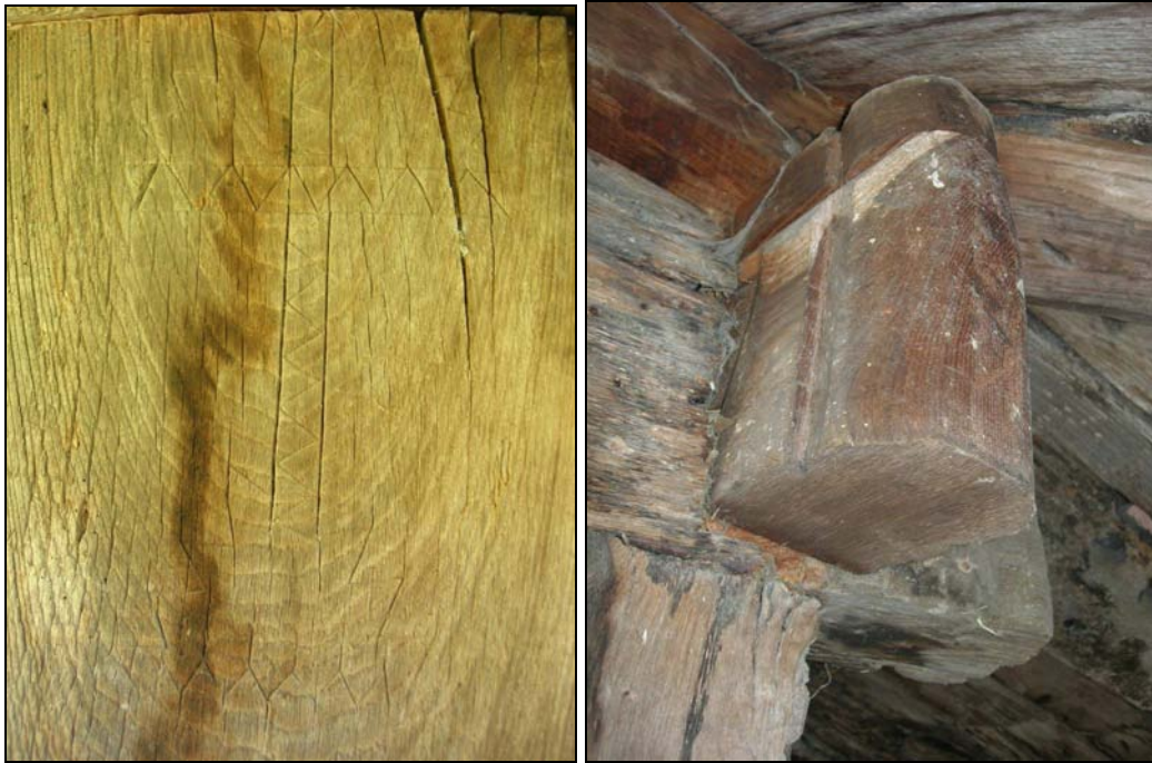
Fig. 149 d y e. Cruz sobre peana con decoración en zigzag. Cabezas de liño en barril, rasgo de estilo propio de la reforma del XVIII-XIX.
