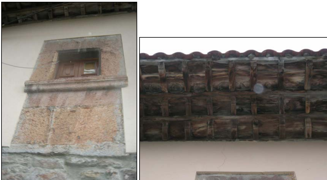
Fig. 59 a y b. En el detalle de esta ventana abierta en la fachada trasera aparece el delicado trabajo de sillería y la presencia de una moldura biselada en el antepecho. Detalle del artesanado de madera que cubre el faldón del alero marcando la antojana de la casa.
