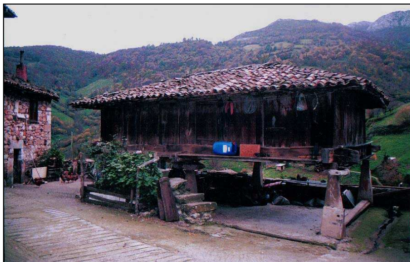
Fig. 162 a. Aspecto general de la panera de los Arias Miranda, que constituye uno de los ejemplos más grandes del pueblo. Se encuentra en la antojana del palacio. La panera fue construida en el siglo XVII, de forma paralela a la edificación de la torre fuerte y pudo aprovechar piezas de un hórreo anterior.
