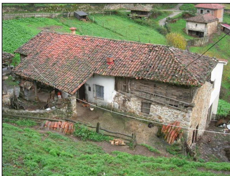
Fig. 55 b. Alzado general desde la fachada NW, con la vivienda en la mitad septentrional y la cuadra y pajar, la “corte” y “paxar” del siglo XVIII, en la meridional.
