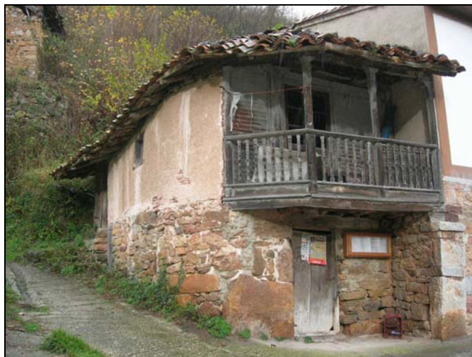
Fig. 87. Casa de Cesarea, la mujer de Manolo, que supone la adaptación de la casa de doble altura y corredor a las arquitecturas campesinas del XIX-XX. En la fábrica, combina la mampostería del piso bajo y el entramado de listones de madera con carga externa en el alto. El interior respetaba la distribución arcaica de cocina y una sola habitación, pese a que introducía la cocina económica de leña frente al llar.
