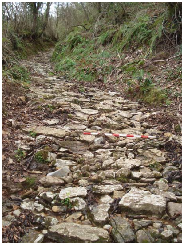
Fig. 59. Pavimentación en la carril del Bandeiro, bifurcación del camino romano hacia la mortera del Vandeiro citada en 1533.
