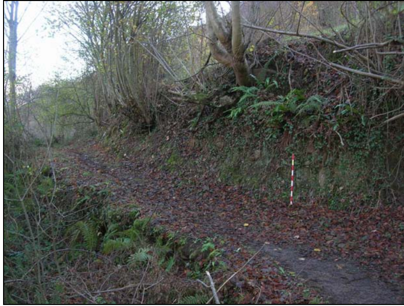
Fig. 62 b. Caja del camino real en su primer tramo, con la superficie arcillosa y el corte efectuado en la pendiente sin muro de revestimiento.
