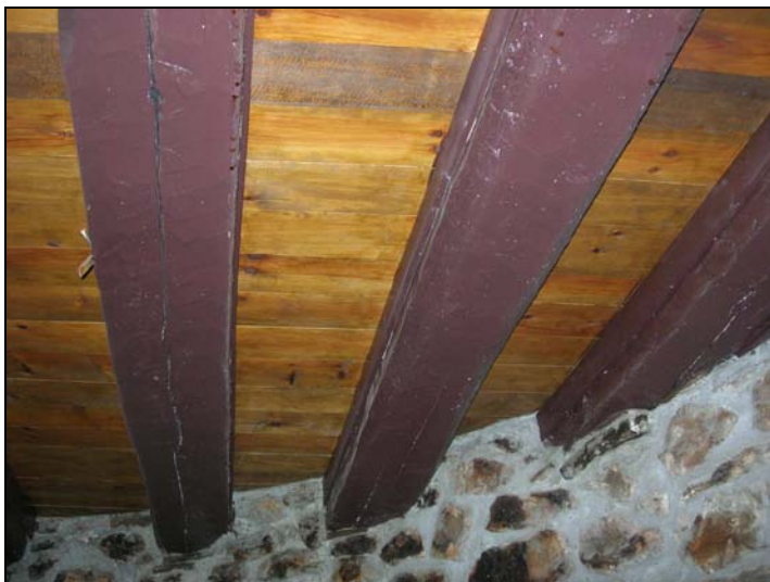
Fig. 33. Forjado del segundo piso. Las vigas actuales emplean los mechinales originales de la construcción.
