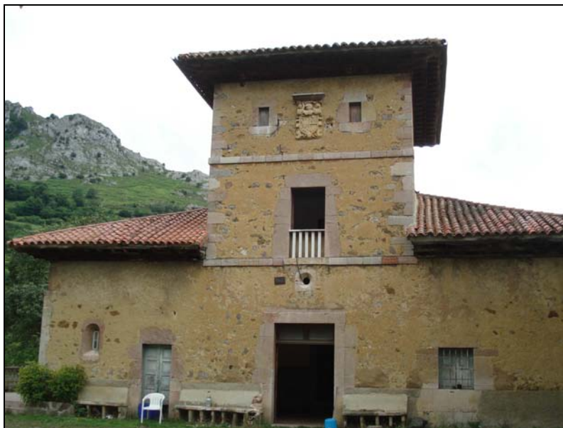
Fig. 99. Palacio de Villamexín (Proaza). A partir del siglo XVII, las elites rurales inician un nuevo proceso de mudanza arquitectónica coincidente con una fase de esplendor económico y social. Las edificaciones constituyen extensiones de los prototipos jerárquicos del XIV-XVI, entre los que se cuenta la importancia de la torre como símbolo de poder. En Banduxu, el palacio torreado será introducido por los Arias Miranda.
