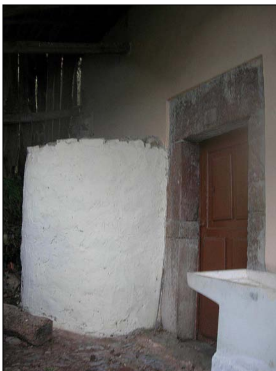
Fig. 217. Horno volado de cúpula en la casona de la Pandiella. Las viviendas del siglo XVIII incorporan este elemento a la cocina.
