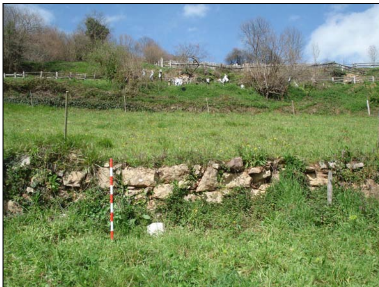
Fig. 137. Parapeto empleado en la 2ª terraza superior del cortinal, con su tosca composición a base de mampuestos calizos sin concertar ni carear.
