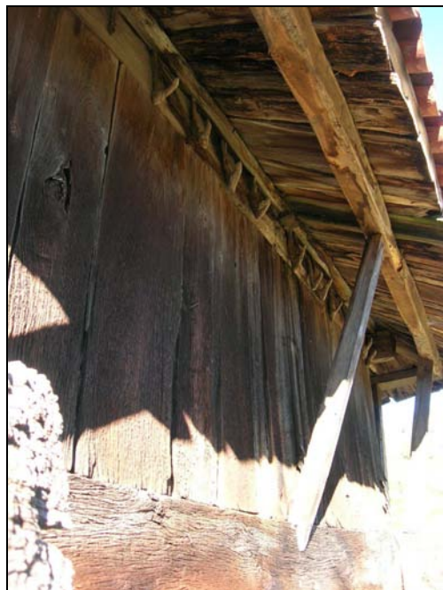
Fig. 142 b. Detalle del amplio faldón sobre tentemosos y de los gabitos destinados a colocar las panoyas de maíz o las cebollas.
