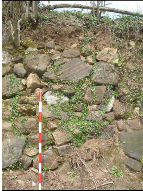
Fig. 135. Muro de cierre colectivo que recorre el límite sur del cortinal. En este caso también actúa de muro de contención de los sedimentos internos.
