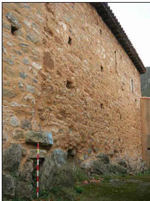
Fig. 4. Cimentación de la iglesia sobre la roca. En los puntos de mayor irregularidad, se añade una banqueta de mampuestos.
