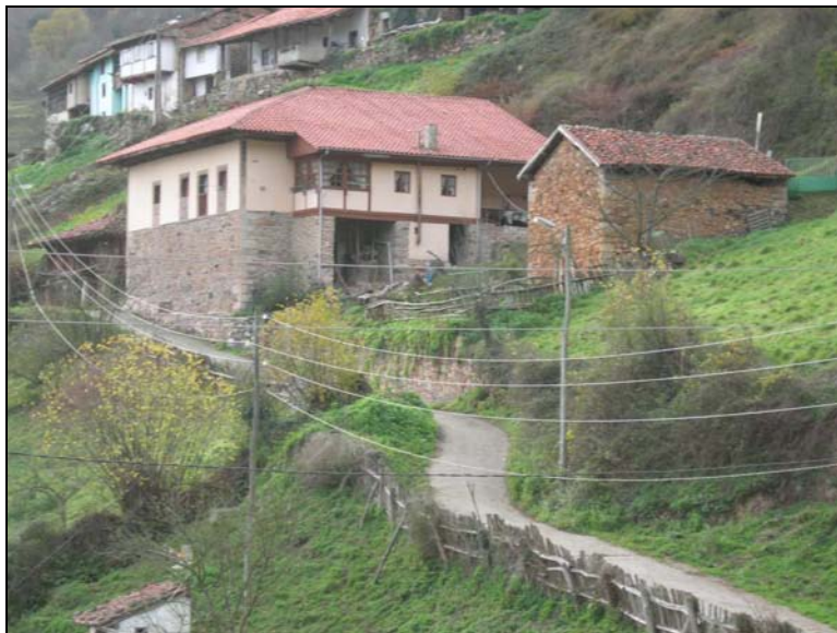
Fig. 60. Puede apreciarse el contraste entre la fábrica de mampostería y la sillería labrada de los vanos con sus mandiles, además del balcón abierto con posterioridad a la fábrica original.
