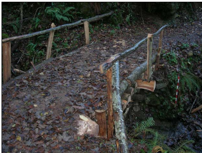
Fig. 64 b. Pontón del Paladón. Detalle de la fábrica de madera sobre base de piedra.
