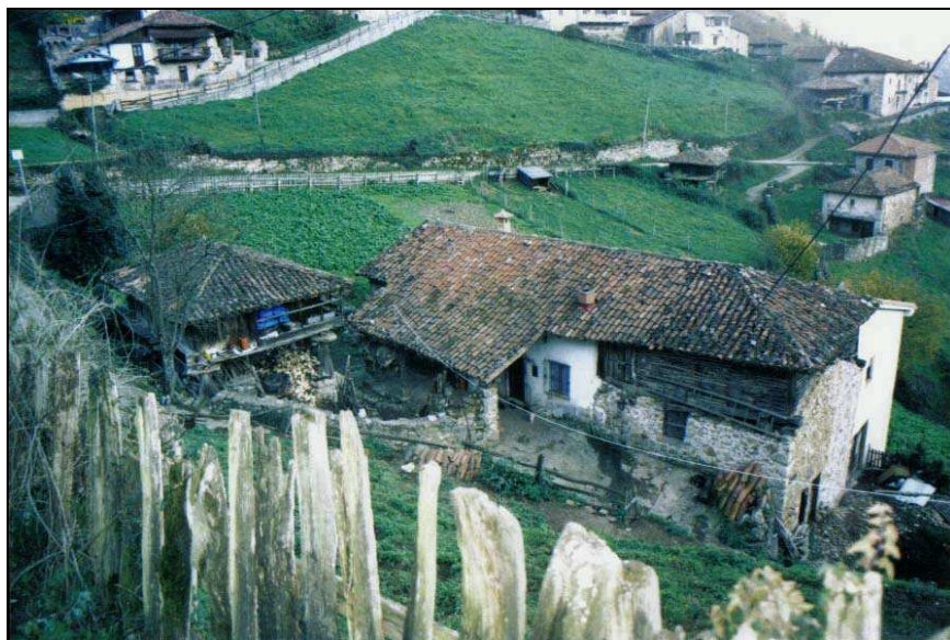
Fig. 55 a. Conjunto de la casona de los Tuñón, que constan asentados allí en 1533. En el siglo XVIII era dueño su descendiente, el presbítero Pedro Tuñón. En ese siglo, el edificio constituía el núcleo de una casería dotada de cuadras y pajares, panera y huertos y árboles frutales, todo ello presente hoy en día.
