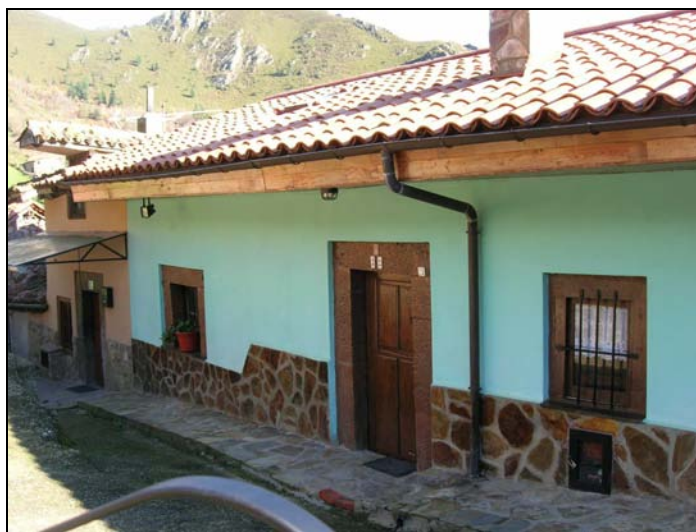
Fig. 84 a. Fachada trasera orientada al oeste de una sola altura de las casas de Andrés y Pedro Fernández en 1752. con la entrada actual al inmueble flanqueada por dos ventanas
