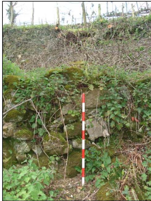
Fig. 127. Parapeto de la 5ª terraza, donde se observa su peor composición, agravada por el crecimiento de una vegetación que contribuye a su ruina progresiva.
