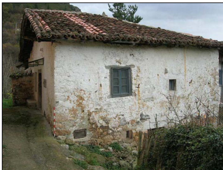
Fig. 65. La casa rectoral de Santa María, situada a escasos dos metros al S de la propia iglesia, aparece citada ya en 1737 y representa el arquetipo de casa turria de doble altura adaptada a la pendiente. Esta característica puede apreciarse en la foto, enfocada hacia el lateral W, donde se abre la puerta de acceso a la caballeriza. A la izquierda se aprecia la entrada principal flanqueada por el horno que el cura don Fabián Tuñón construye entre 1752 y 1765.
