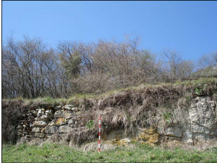
Fig. 174 b. En la segunda modalidad se emplea una técnica mixta (parapeto combinado con afloramiento kárstico).
