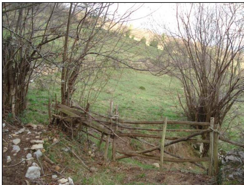
Fig. 168. Portiella de ingreso en el cortinal, que permitía llegar a las terrazas inferiores.
