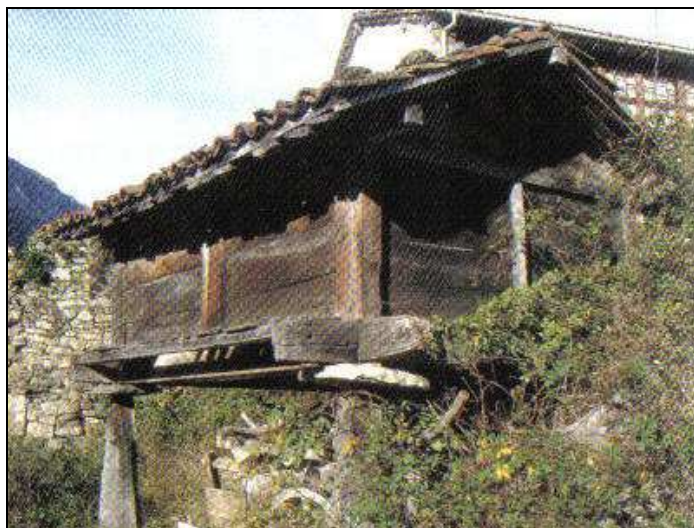
Fig. 175 a y b. Hórreos representados en las Cantigas de Santa María (Menéndez Pidal, 1986) y hórreo tipo “Los Beyos” (Rivas Andina, 2004), característico de la montaña oriental asturleonés. Junto al modelo gallego, parece ser una pervivencia de las construcciones existentes hasta el siglo XIII. El hórreo de las cantigas es un buen ejemplo de los “hórreos buenos” con cubierta de teja citados en la diplomática del período y constituye un excepcional testimonio del repertorio decorativo empleado en los hórreos señoriales.
