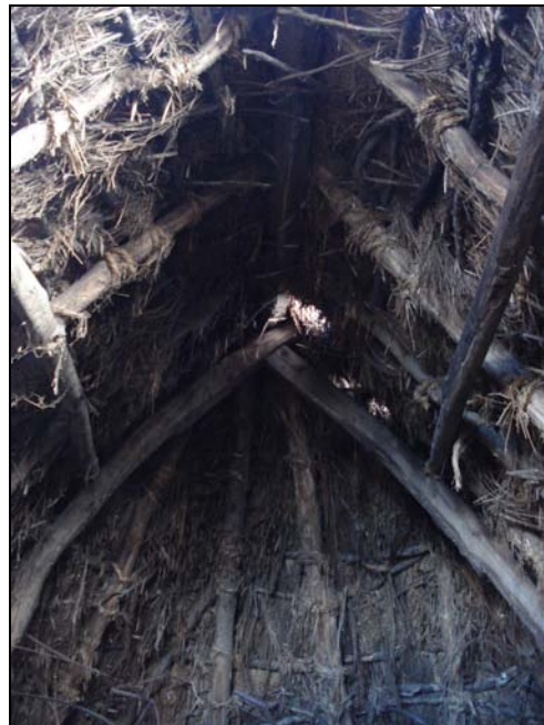
Fig. 98. Detalle de composición de la cubierta en la palloza de casa Xalvín, donde pueden apreciarse los “tiseiraos” o tijeras que sustentan la viga maestra (“cumal”). A su vez, se advierten las vigas secundarias (“cangos”) a las que se ata la urdimbre vegetal.
