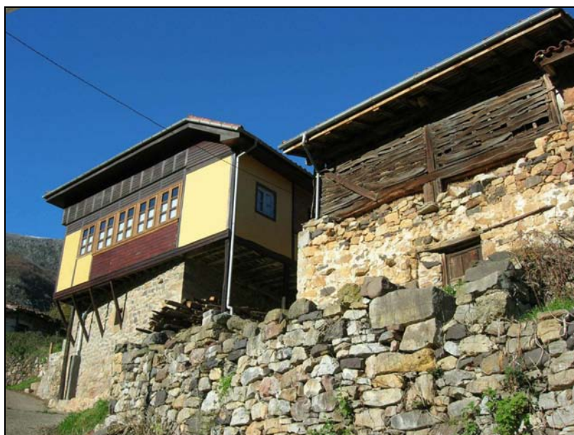
Fig. 64. A la izquierda, solar del presbítero don Andrés González Tuñón, uno de los grandes propietarios de la aldea en 1752. Fachada lateral orientada al fondo de valle (SW), con el amplio corredor en voladizo reconvertido en galería y sobre él, el espacio del desván.
