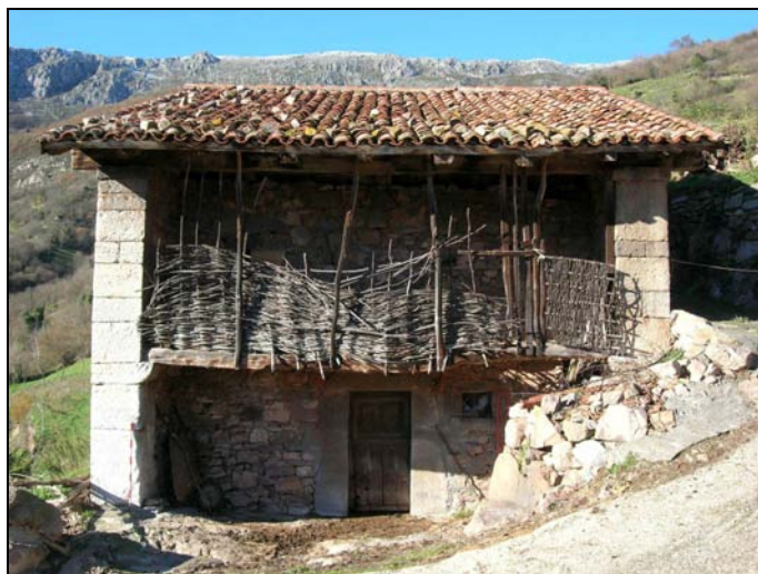
Fig. 118. Frontal de esta bella edificación con el xebatu o cesteadado en voladizo que da nombre a la construcción: “pallareta”. El empleo de muros cortafuegos en sillería, esquinas recortadas en rebaje a listel e impostas redondeadas supone la adaptación de la casa de corredor que emplean los señores de la aldea desde el XVII.
