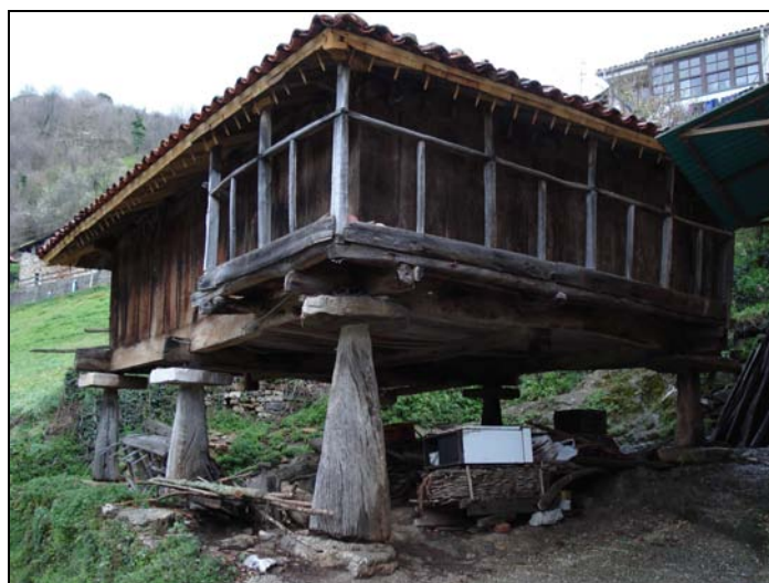
Fig. 163. Panera del convento, que sustituye a un hórreo en pie hasta 1757, del que aprovecha los engüelgos de una pieza. Esta sustitución está marcada por el paso del viejo hórreo, propiedad de dos familias campesinas, al patrimonio señorial del presbítero don Diego González Tuñón entre 1737 y 1757. Se aprecia el corredor añadido con posterioridad y la cubierta repuesta recientemente.
