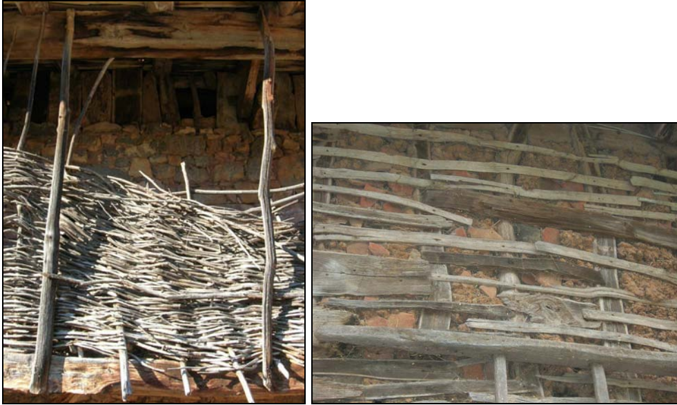
Fig. 88 y 89 a. Ejemplos de xebatu y entramado de madera relleno de piedra y teja (tabique de barretes). Pese a la desaparición de las arquitecturas aldeanas de los siglos IX-XII, la aldea conserva algunas de sus técnicas constructivas, empleadas, sobre todo, en edificios agropecuarios.
