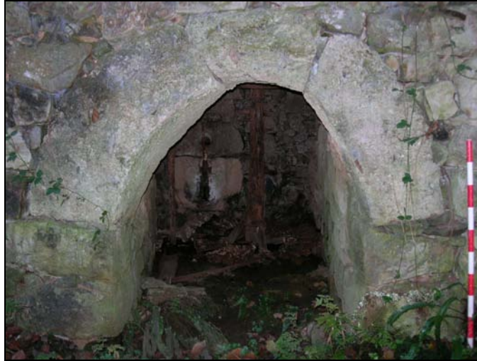
Fig. 211b. Bóveda del rodezno, con el arco despiezado en dovelas. En el fondo, se aprecia el rodezno en trances de desaparición
