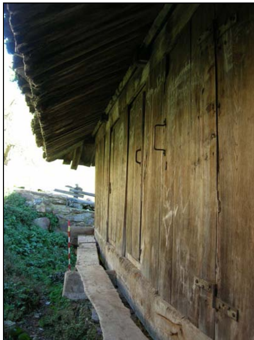
Fig. 170 b. Puertas y talamera del costado NE
