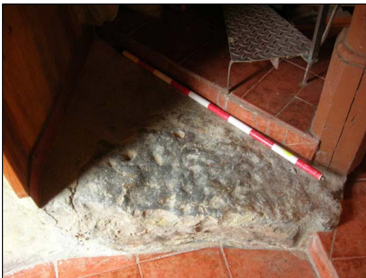
Fig. 34. Escalón basal de la antigua escalera de acceso entre el sótano y el primer piso.
