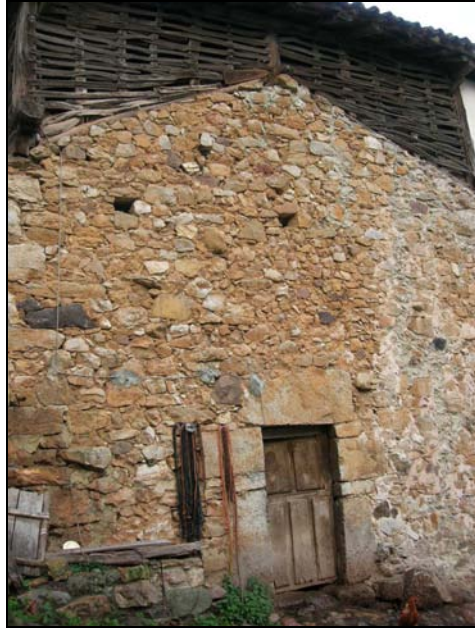
Fig. 107 b. Lateral sur del edificio. Puede apreciarse el alzado original en piedra con la puerta de la cuadra y el añadido en listones de madera adaptado a la antigua cumbre a dos aguas del edificio.
