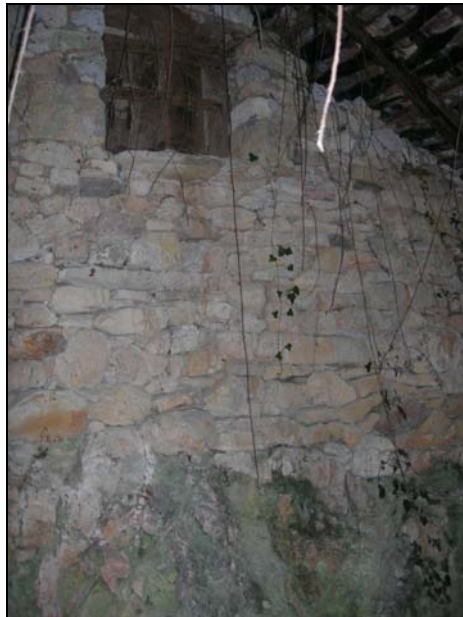
Fig. 116 b. Detalle en el que se aprecia la cimentación del muro directamente sobre la roca y el recrecido pétreo del muro en el que se incorpora una nueva ventana.
