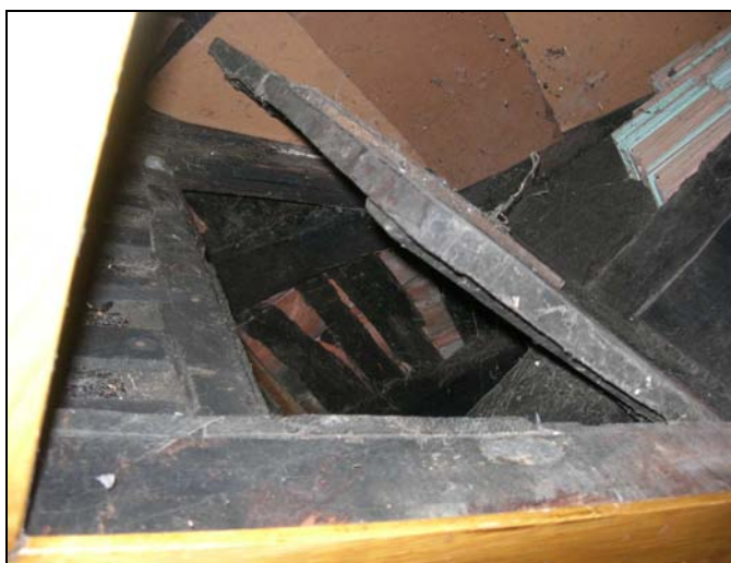
Fig. 37. Trampilla con la armadura del tejado al fondo.
