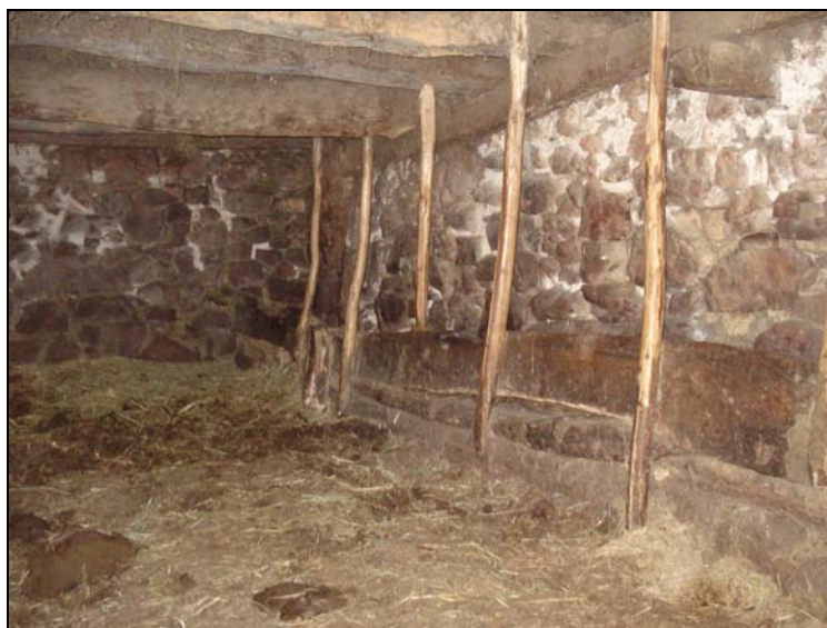
Fig. 134. La cuadra cuenta con una ordenación muy clara y habitual en el campo asturiano. El suelo está empedrado y se inclina hacia un riego central que permite evacuar los excrementos. A ambos lados se sitúan los pesebres y los postes o retrigas.
