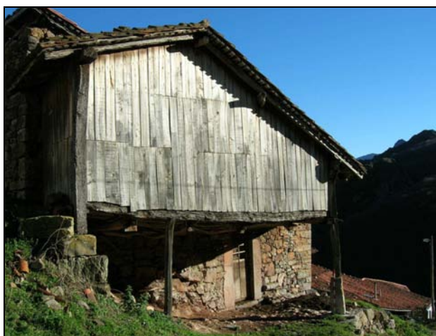
Fig. 122 a. En este ejemplo, la pallareta adosada al viejo edificio y originalmente de xebatu de avellano obedece a criterios más modestos. La fábrica de listones de madera es reciente, dentro de la tónica general de sustitución del entramado de varas.
