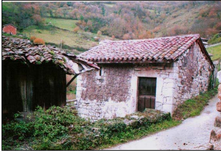
Fig. 214 a. Casa del molino de mano que don Toribio Tuñón cedía en mayorazgo a su hijo don Agustín de Tuñón antes de 1737 y que formaba parte de la casa de Tuñón en el barrio del Palacio. Se mantuvo en funcionamiento hasta fines del XX.
