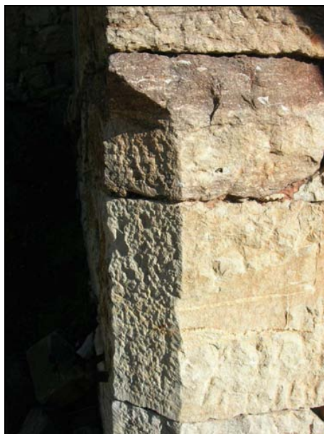
Fig. 121 b. Moldura en rebaje a listel del codo avanzado, ampliamente utilizada en los pegollos de hórreos construidos o reformados en la segunda mitad del XVIII y en la caballeriza del palacio de los Arias Miranda.
