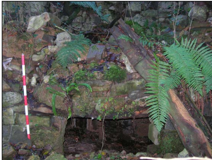
Fig. 208 b. Entre las ruinas se aprecia el infiernu del rodezno, con un dintel de madera
