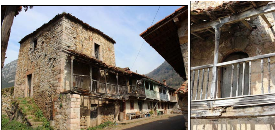
Fig. 49 a y b. Conjunto de La Abadía (Tuñón) con la torre señorial y detalle de la puerta del primer piso, con arco de medio punto. Considerada tradicionalmente como solar de los Tuñones, es un modelo de torre evolucionada del XVI-XVII que pudo influir en el edificio de los Arias Miranda.
