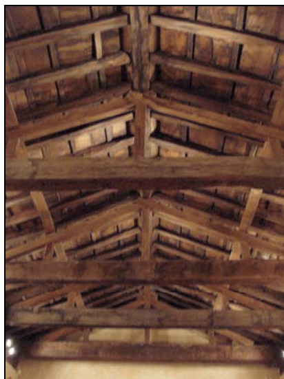
Fig. 10. Armazón de la cubierta
