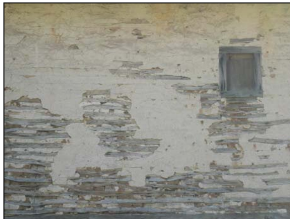
Fig. 89 b. Tabique de barretes con revoco exterior. En los ejemplos conocidos procede de aplicaciones tardías (siglos XIX-XX).
