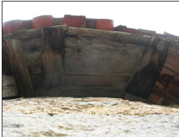
Fig. 32. Detalle del alero con las grapas de madera que permiten el encastramiento al muro
