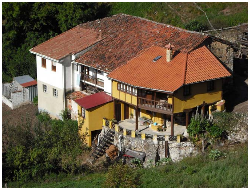
Fig. 56 a. Fachada orientada al SE, donde se aprecia la doble altura del edificio en esta zona. El alzado original, dotado de un amplio corredor, se ha visto alterado por la ampliación de un cuerpo lateral que prolongaba el corredor, la posterior transformación de una parte de este corredor en galería, y el añadido en fechas más recientes del siglo XX de otro cuerpo de vivienda a la izquierda y otros dos cuerpos menores (en el centro).
