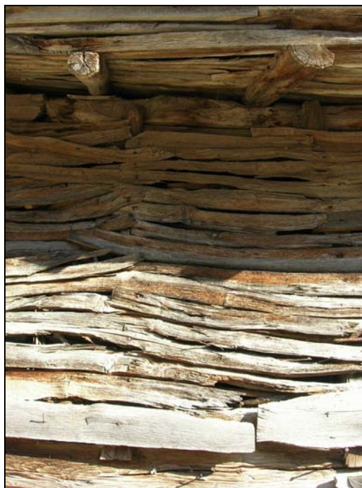
Fig. 90. Entramado de madera con tablas costeras sin trabajar, que ha ido sustituyendo al xebatu en los últimos tiempos.
