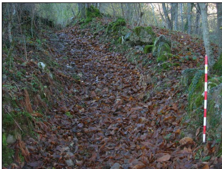
Fig. 62 a. Caja del camino real al poco de dejar el pueblo. Puede apreciarse, en el lateral que da hacia el arroyo del Trigal, la colocación de pequeñas murias de piedra muy endebles, apenas apilamientos de bloques y mampuestos. Su función no es constructiva sino jurídica. Se trata de delimitar con claridad los límites del camino.
