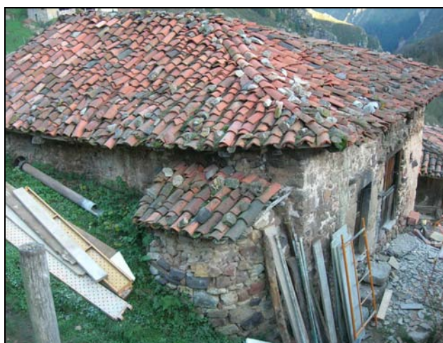
Fig. 82 c. Fachada trasera, con el primer horno
