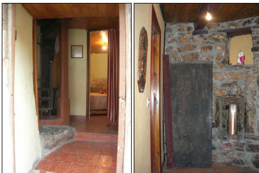
Fig. 43 a y b. A la izquierda, división actual del primer piso y a la derecha, tabique que divide el segundo piso entre un pasillo-recibidor y la zona de dos habitaciones. Al fondo de esta última puede observarse la saetera y el nicho del escudo
