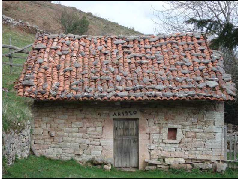
Fig. 136. Casa de monte cercana a la braña de Los Acebos. Construida en 1920, marca el modelo tardío, que introduce un diseño de fábrica más regular, con sillarejo y mampostería careada y concertada. Constituye el arquetipo mayoritario en la ruta hacia Los Acebos y confirma la implantación tardía de la casa de monte en el nuevo mapa de rompimientos.
