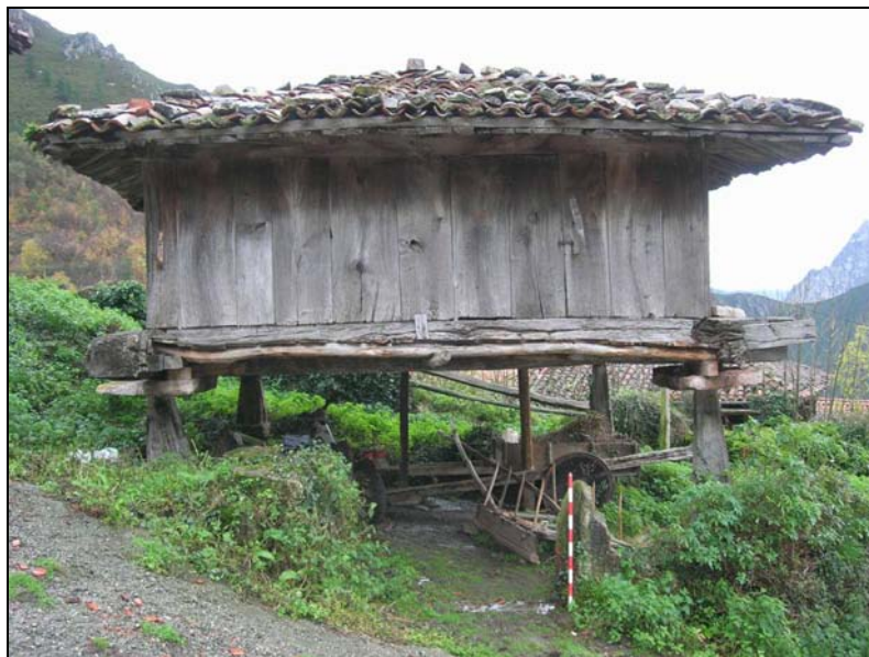
Fig. 165 a. Hórreo nuevo que Francisco Santos construye entre fines del XVIII y 1809 al lado del heredado de sus padres. Aspecto general del hórreo, donde se perciben los dos puntales que refuerzan la viga central o sobigañu
