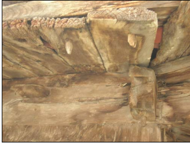
Fig. 147 c. Empleo de tornos de aire en los cabrios, propios de la reforma de la cubierta en el siglo XVIII.
