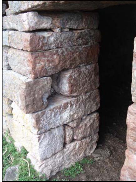
Fig. 127. Lateral interior de la puerta, con el hueco de la tranquera. Puede verse el buen trabajo de cantería.
