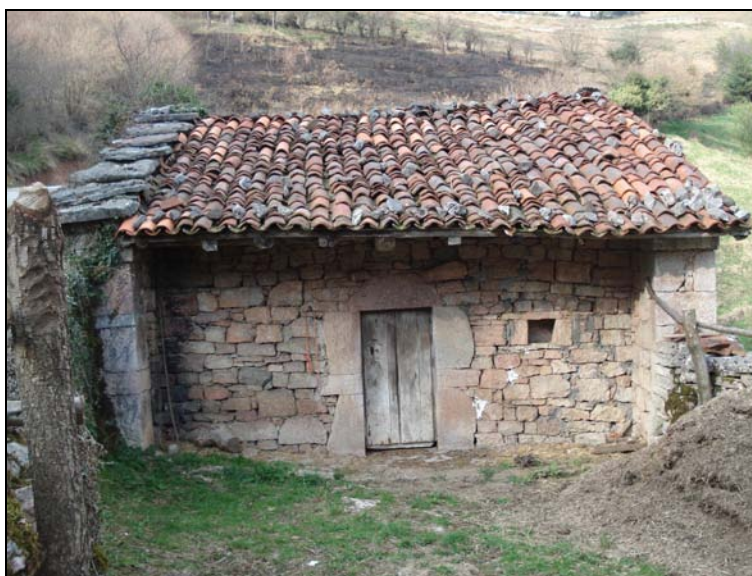
Fig. 138. Casa de monte contigua a las praderas de Las Beras y Aguiñón. Es una variante del modelo evolucionado, caracterizado por la presencia de dos antepechos o muros salientes que sostienen al alero, generando un pequeño pórtico cubierto. Guarda evidentes similitudes con las pallaretas de la aldea y con soluciones propias de las capillas rurales.
