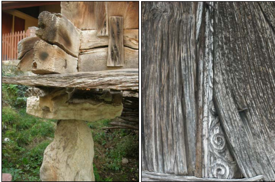
Fig. 146 b y c. Detalle de los pequeños pegollos que sustituyen a los de madera de 1752 y el ensamblaje completo de los traveses. A la derecha, barrotillo reaprovechado.
