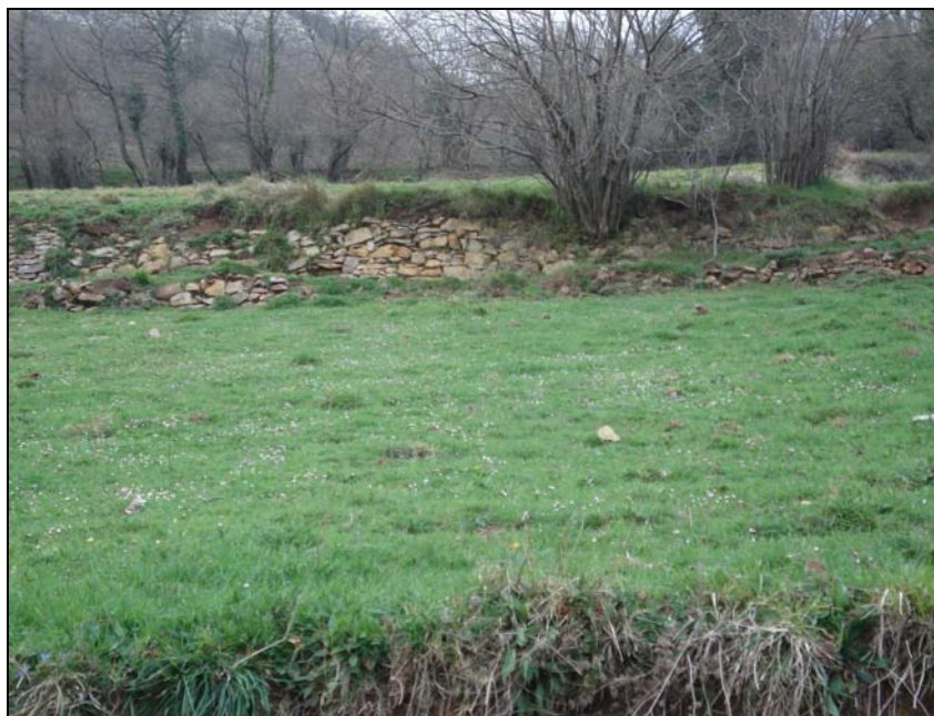
Fig. 186 b. En la fotografía puede apreciarse uno de los parapetos del sistema de terrazas desarrollado en Folgueras en el siglo XIX. Emplea la misma técnica de muro con mampostería a hueso, lo que demuestra la extraordinaria vigencia temporal de estos recursos constructivos. Hoy, el abandono del modesto barrio ha supuesto su irrefrenable proceso de ruina.
