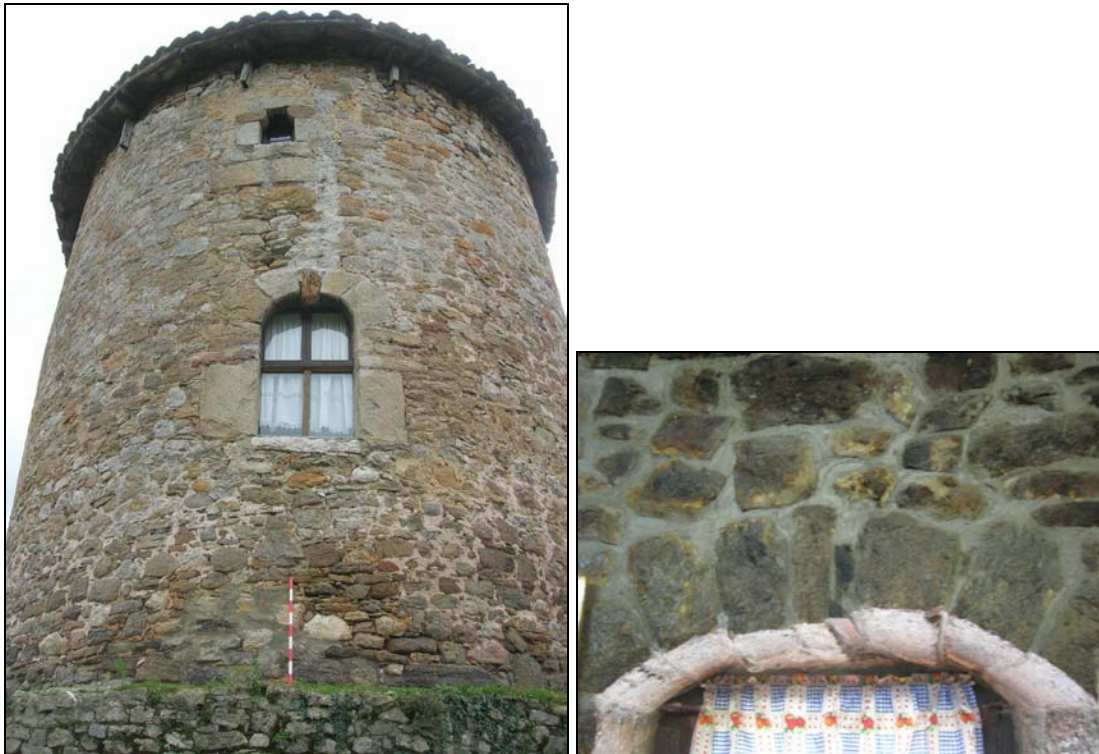
Fig. 28 a y b. Puerta de medio punto colgada que señala el acceso original a la torre y despiece interior en dovelas del arco de entrada
