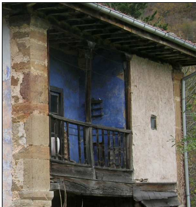
Fig. 101 a y b. El corredor es un espacio de poder, vinculado a la sala en el interior de la edificación y se embellece con repertorios pictóricos. En la primera fotografía, restos de pintura en la torre de la Abadía (Tuñón). Abajo, corredor de la casa nueva de los Muñiz Prada.
