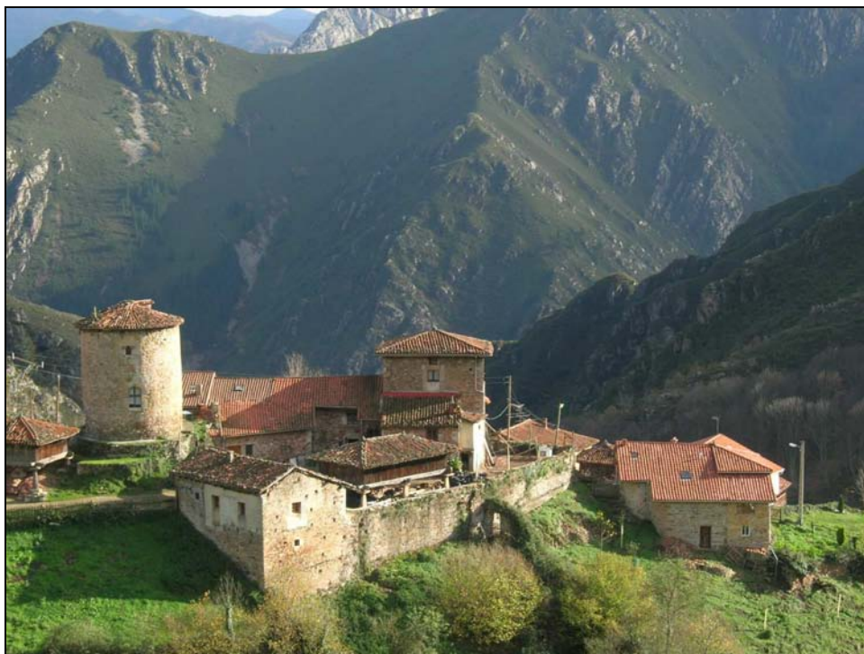
Fig. 45. Conjunto de la torre y palacio de los Arias Miranda, con la corralada delimitada por una potente cerca que permite sujetar los rellenos del aterrazamiento y le otorga aspecto fortificado. Edificado en el XVII, suponía una renovación del modelo de torre de sus antepasados, los Álvarez de Banduxu, y tomaba como ejemplo otras arquitecturas del valle de Proaza, como la casa fuerte de los Prada.
