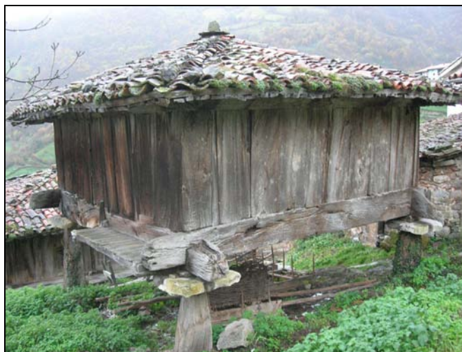
Fig. 164 b. En el lateral puede apreciarse la reducida talamera, a modo de tenobia.
