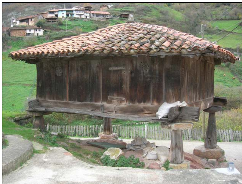
Fig. 143. Hórreo de los Tuñón. El edificio primitivo se levanta en el siglo XVI asociado a la torre y será reedificado por don Fabián Tuñón, señor de la torre y cura de la aldea, en 1756. Se aprecian los ventiladeros decorados en el colondrame sur.
