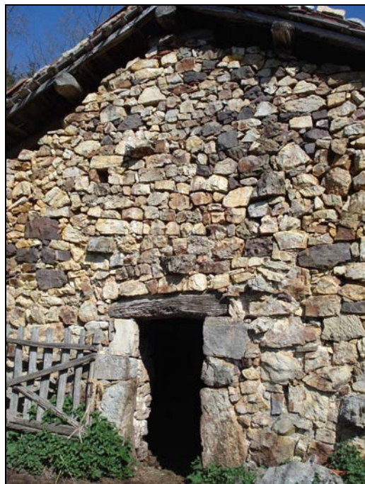
Fig. 130 a. Las características edilicias responden al prototipo más arcaico, con empleo de mampostería muy tosca sin concertar, aglutinada con arcilla, escasez de vanos y ausencia absoluta de sillería. El propio dintel de la puerta es sustituido aquí por una viga o “cargadeiro” de madera.
