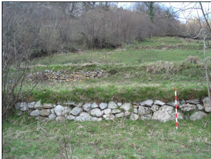
Fig. 170 a. Parapeto de mampostería caliza a hueso correspondiente a la primera terraza inferior.
