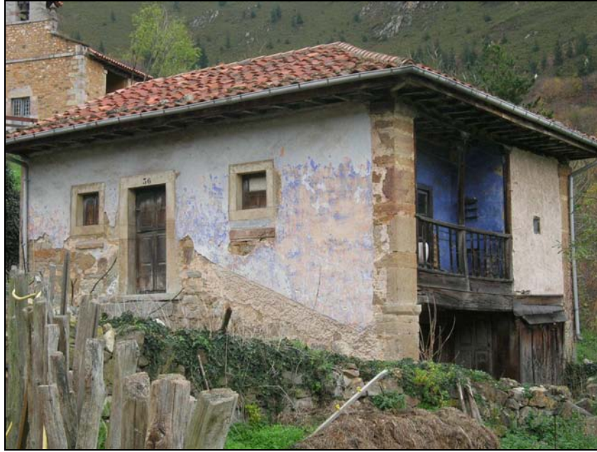
Fig. 73. Casa nueva de los Muñiz Prada, construida entre 1752 y 1805. Sigue fielmente el prototipo de casa de corredor entre muros cortafuegos que se documenta en el campo asturiano desde el siglo XVII al servicio de las jerarquías.
