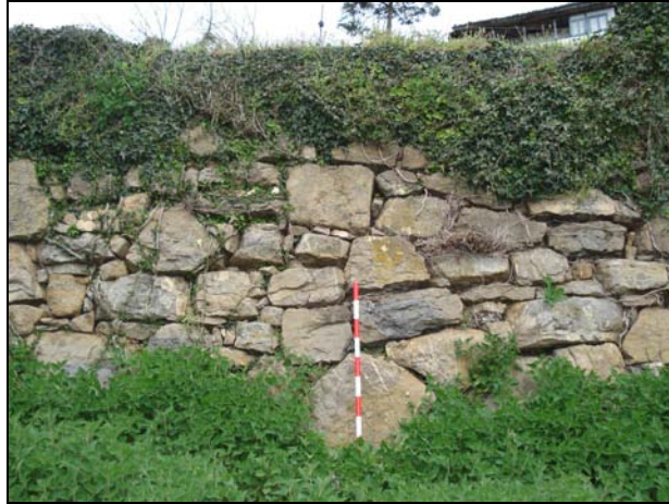
Fig. 124 b. Detalle de la excelente fábrica de mampostería empleada en el parapeto de la primera terraza.
