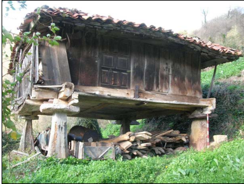
Fig. 166 a. Hórreo desde el SE, con las dos puertas, una de ellas de casetones tardía. En la esquina aparece el tentemosos y en el lateral el corredor abalaustrado, todo ello fruto de reformas que alteraron la fábrica original del XVIII, fruto de la progresiva colonización habitacional de una zona sin indicios de arquitecturas en 1752.
