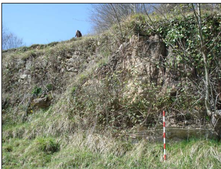
Fig. 176. En la última modalidad, las terrazas se adaptan a los afloramientos kársticos cuando éstos son muy potentes, lo que proporciona saltos de hasta 3 metros de altura.
