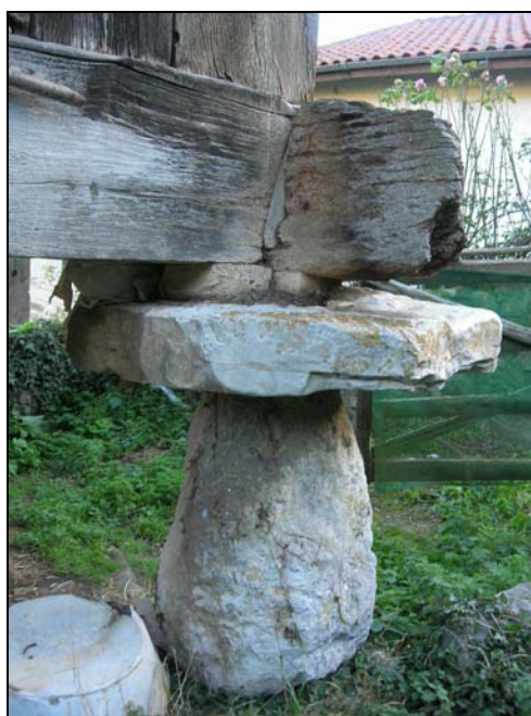
Fig. 153 b. Detalle del pegollo de piedra fruto de la reforma, en el que se aprecia su escaso volumen, con muela más ancha y taco. Los traveses ensamblan a madera completa.
