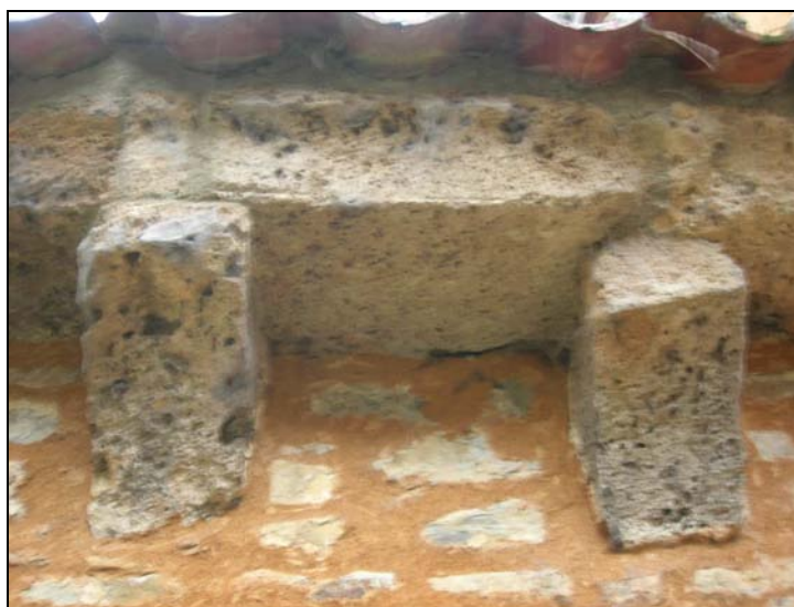
Fig. 203. Canecillos y moldura labrada en piedra toba del ábside de la iglesia, construido en los siglos XII-XIII. Las canteras de la aldea se emplazan en espacios periféricos al caserío y cercanos al viario. Los usos más antiguos corresponden a la arenisca, la cuarcita y la toba, presentes en edificaciones medievales. Esta última se destina, por su mayor blandura, a la cantería de mayor pujanza. El más reciente, detectado a partir del XVII-XVIII, se refiere a la caliza de montaña.
