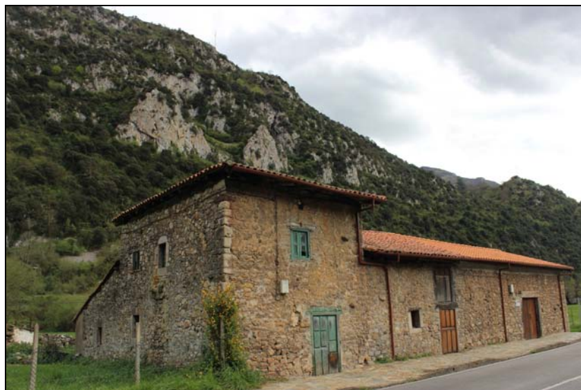
Fig. 50. Casa torreada de El Xabil.
