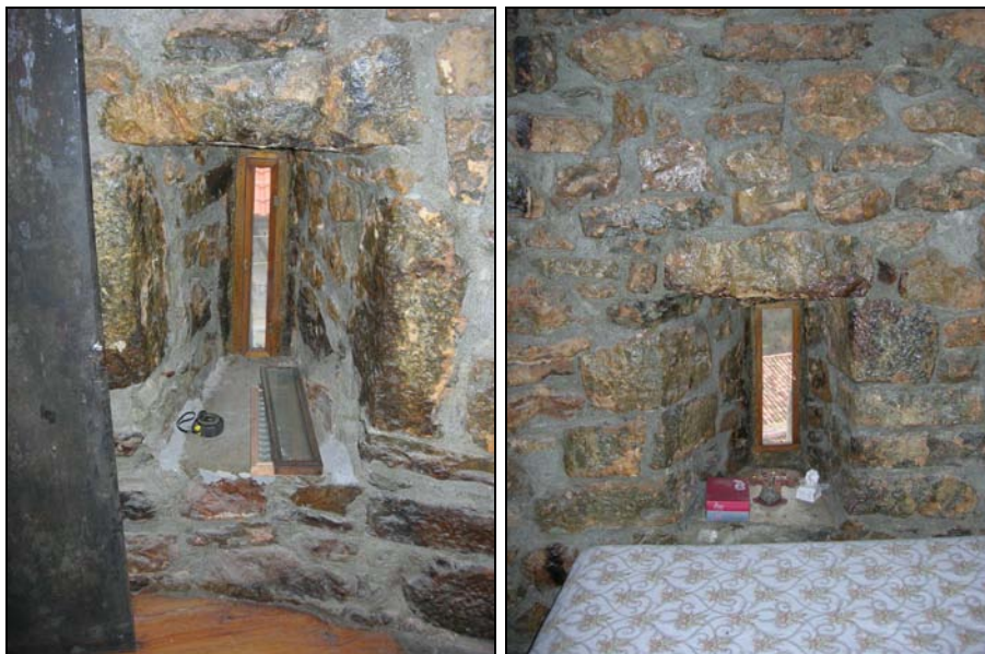
Fig. 29 b y c. Saeteras NW y NE del segundo piso
