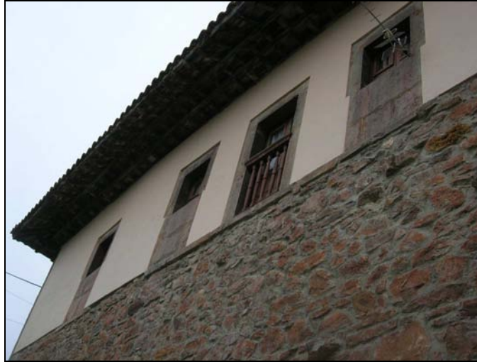
Fig. 60. Puede apreciarse el contraste entre la fábrica de mampostería y la sillería labrada de los vanos con sus mandiles, además del balcón abierto con posterioridad a la fábrica original.
