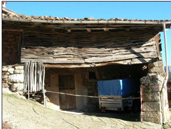
Fig. 121 a. Cuadra y tenada del Toral, con la pallareta formada por un entramado de tablas irregulares. Puede verse cómo apoya sobre un codo avanzado de sillería
