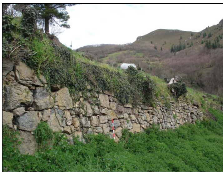
Fig. 124 a. Parapeto pétreo correspondiente a la primera terraza superior del cortinal. Es el muro más perfecto de los construidos en el término aldeano. Presenta una altura de más de dos metros, con fábrica de mampostería caliza a hueso.
