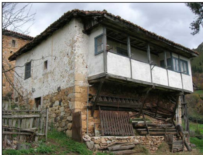
Fig. 66. Fachada trasera de la casa rectoral, orientada hacia el sureste. Puede apreciarse, en este caso, la doble altura creada por la pendiente y el amplio corredor que domina visualmente las cortinas de la aldea, hoy transformado en galería. En esta zona, el suelo ha sido aterrizado y la cimentación se fortalece con una banqueta.
