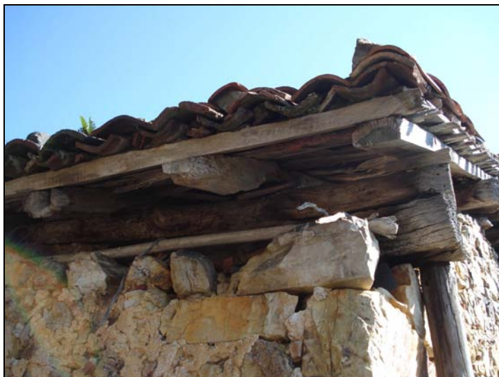
Fig. 131. El sistema de cubiertas emplea la tejavana sobre armadura de madera que apoya directamente en el “sobremurio”, aunque sin cerrar del todo el hueco existente entre ambos para el mejor curado de la hierba.
