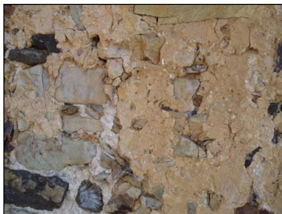
Fig. 130 b. La pobreza del núcleo edilicio se ocultaba mediante un revoco igualmente primario, consistente en la aplicación de una capa de arcillas sobre la mampostería. Se conservan algunos vestigios en el lateral W.
