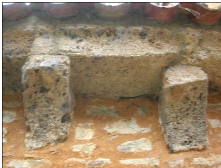
Fig. 3. Detalle del alero y los modillones en piedra toba del testero románico
