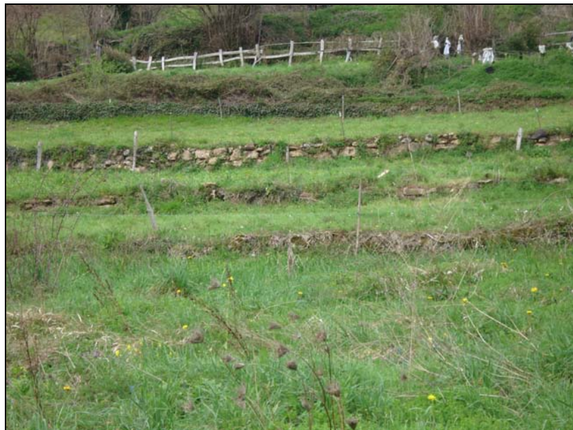
Fig. 136. Detalle del sistema de terrazas lineales con parapetos pétreos
