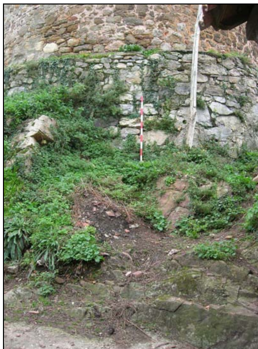
Fig. 27. Detalle con la banqueta de cimentación de la torre en su punto de mayor altura, construida sobre la roca
