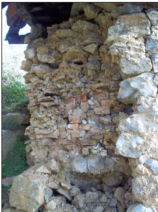
Fig. 216. Sección de un horno doméstico en Viescas (Teverga), donde puede apreciarse el material refractario (ladrillo) empleado.
