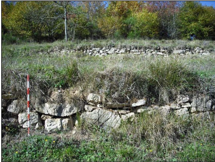
Fig. 182 a. Bancal con muro de contención a hueso
