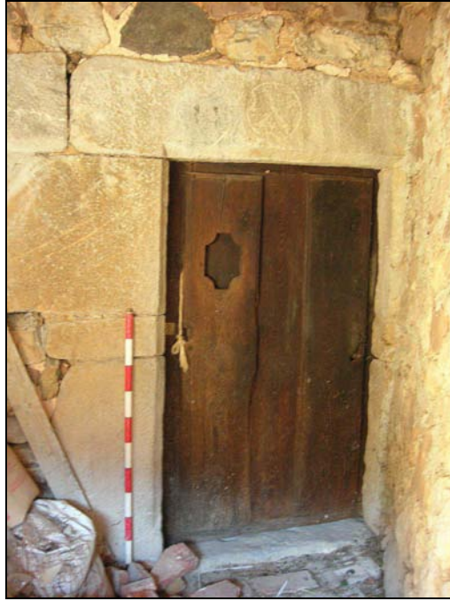
Fig. 83 b. Entrada original, con el dintel decorado y el paño del nuevo portal adosado a la jamba derecha, que queda oculta.
