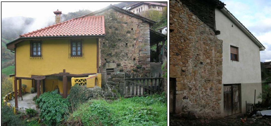
Fig. 56 b y c. Flanco N. de la casa. Puede observarse el contraste entre el volumen recio y cuadrangular del cuerpo original, con fábrica de mampostería y cantería en los esquinales y el añadido que prolongaba la línea de corredor en voladizo. A la derecha, flanco sur, con el adosamiento entre la cuadra citada en 1752 y el nuevo cuerpo de vivienda del siglo XX.
