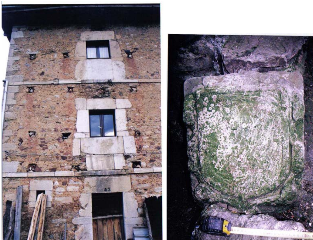
Fig. 47 a y b. Paño meridional de la torre, donde puede observarse la división en tres pisos marcada por impostas de sillares, la puerta inferior y los dos vanos superiores con recercado y mandiles, los orificios correspondientes a los pasantes y el pequeño nicho entre la última ventana y el alero, destinado a la colocación de un escudo. A la derecha, escudo de armas, que conserva muy desgastado el blasón de los Álvarez de Banduxu.
