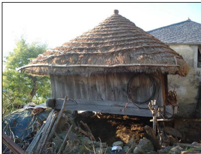
Fig. 96. Hórreo de Casa Barredo (Peneda, Ibias), con el teitado a baguna. Es el “cimborrio de fina paja” rodeado con “rollos de bimbres” que Eugenio de Salazar observa en las casas del pueblo de Tormaleo a inicios del siglo XVII.
