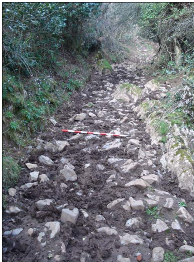
Fig. 57. Empedrado del camino real entre Los Acebos y Cuevallagar
