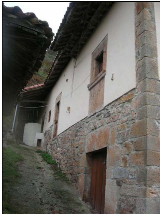
Fig. 58. Entrada trasera. Se aprecia la perfecta adaptación a la pendiente, que permite una vez más estructurar la vivienda en dos alturas, la inferior destinadas a cuadra y bodega y la superior a vivienda. Excelente careado de los sillares reservados a las aberturas.
