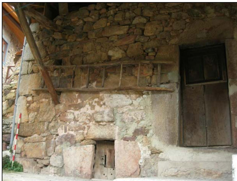
Fig. 81 b. Fachada trasera orientada al Sur, que conserva mejor los rasgos originales de la construcción, con fábrica de mampuestos y arcilla y sillarejo en los esquinales y recercado de vanos. La puerta es una reforma abierta como consecuencia de la partición familiar. También puede observarse el pequeño ventanuco a ras de calle que airea la cuadra, el “suétano” de 1794.
