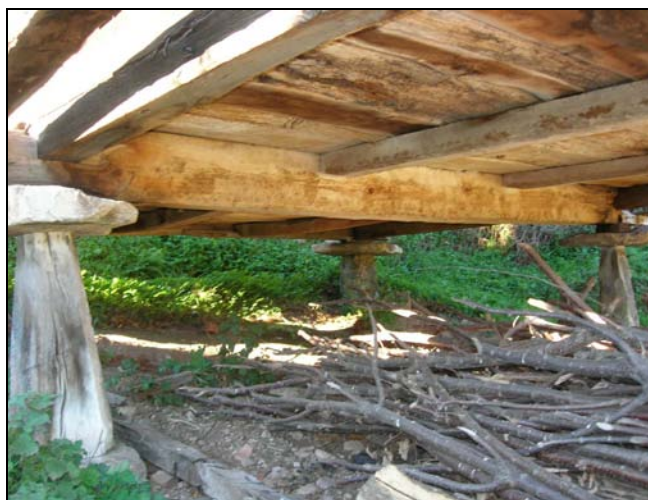
Fig. 172 b. Detalle de los sobigaños y pontas
