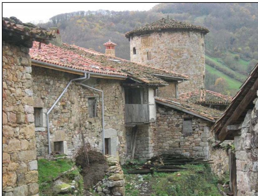
Fig. 108. Conjunto de cuadras y pajares de los Tuñón, ligados a la residencia señorial que hereda la propiedad sobre la torre circular. Al fondo, el edificio con el pequeño corredor de madera, señala el origen del conjunto.
