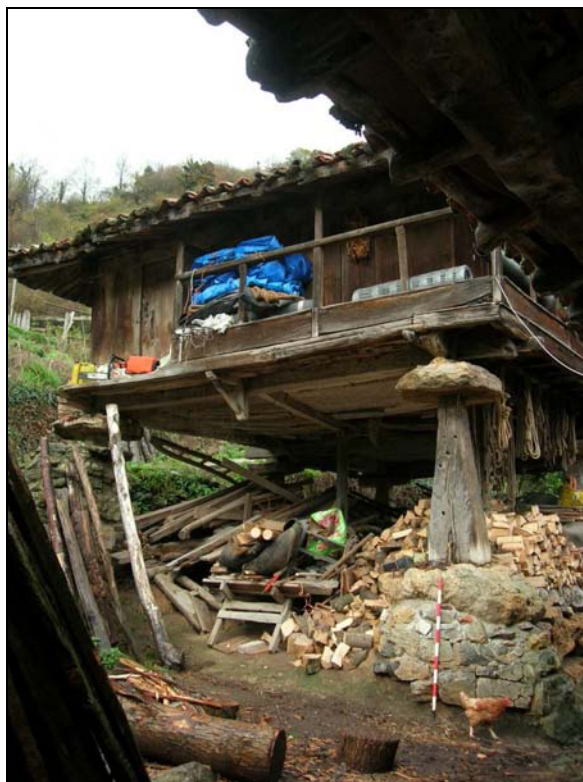
Fig. 169 b. El jalón señala los grandes pilpayos de mampostería. Es el único ejemplar de la aldea que emplea este sistema.
