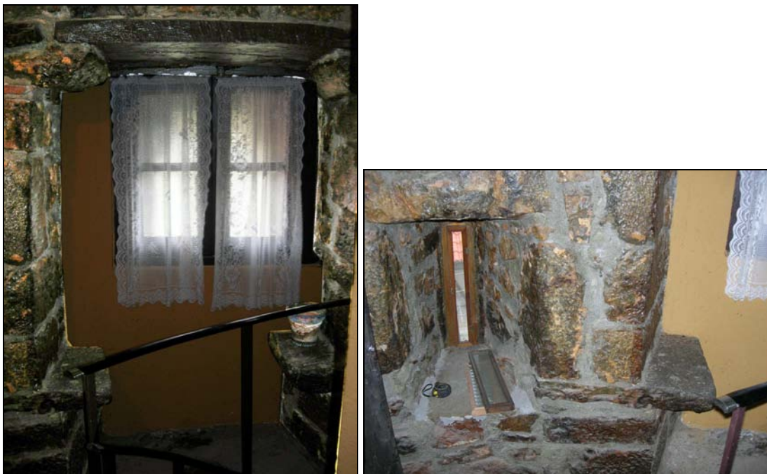
Fig. 30 a y b. Ventana cortejadora y detalle de una de las sillas.
