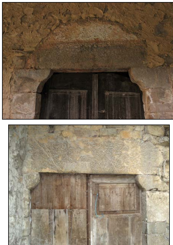
Fig. 102 y 103. Dintel sobre impostas de ápice redondeado en el claustro de San Pedro de Teverga (siglo XVII) y en una edificación aldeana de Bermiego (Quirós). En Banduxu ya se aprecia en la torre circular y sigue empleándose en construcciones de los siglos XVII y XVIII, cuando parece extenderse de forma generalizada.
