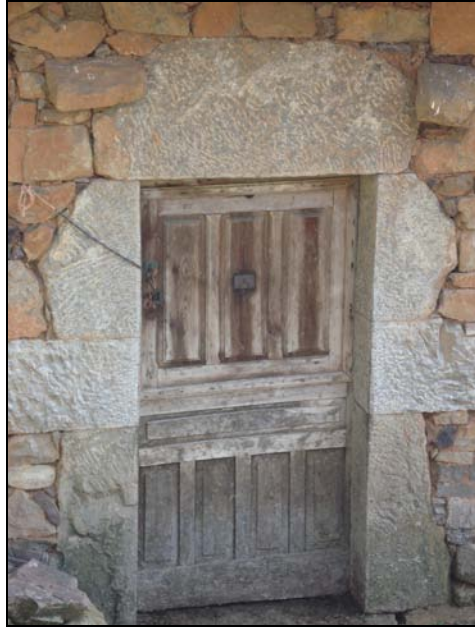
Fig. 135 b. Detalle de la puerta de entrada con la fábrica de sillería a cincel, característica de estas construcciones tardías del siglo XIX.
