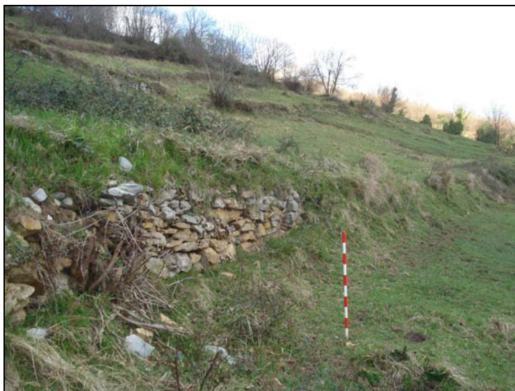
Fig. 170 b. Talud correspondiente a la tercera terraza inferior, donde puede apreciarse la aplicación de un sistema mixto de bancal simple cortado en la matriz terrosa del cortinal y de parapetos a hueso.
