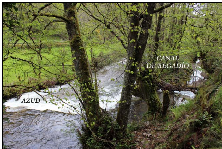
Fig. 219. Sistema de regadío con azud y canal paralelo.
