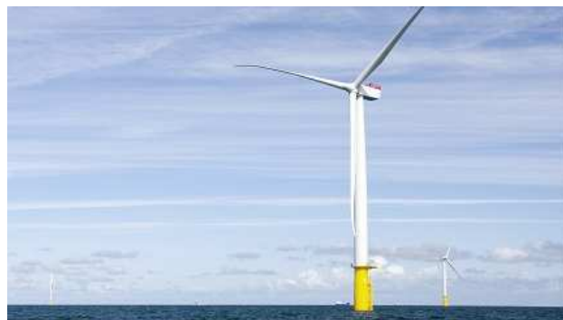
Fig. 4 Torre eólica marina
