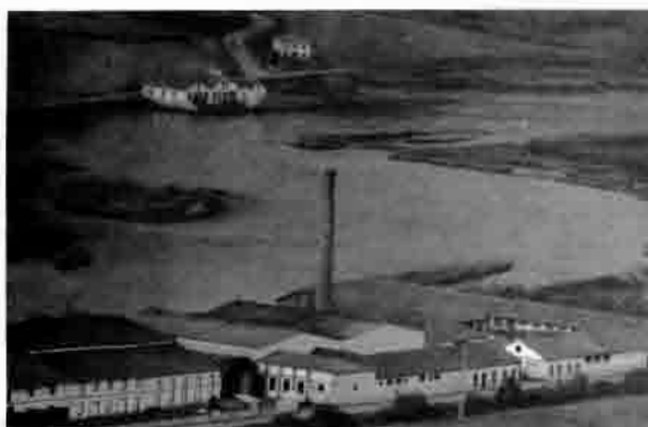
Lám. 54.-Fábrica de sidra El Gaitero.
