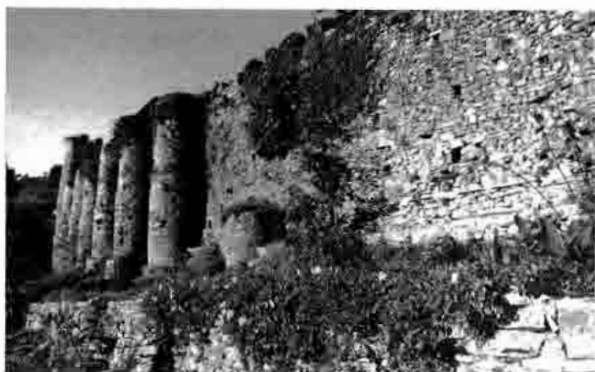
Lám. 37.—Murallas de La Torre. Nievares.
