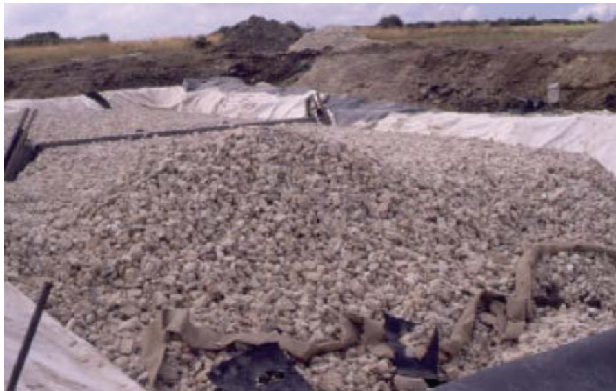
Figura 33. Sustrato de caliza localizado en el fondo de un S.A.P.S. 4
