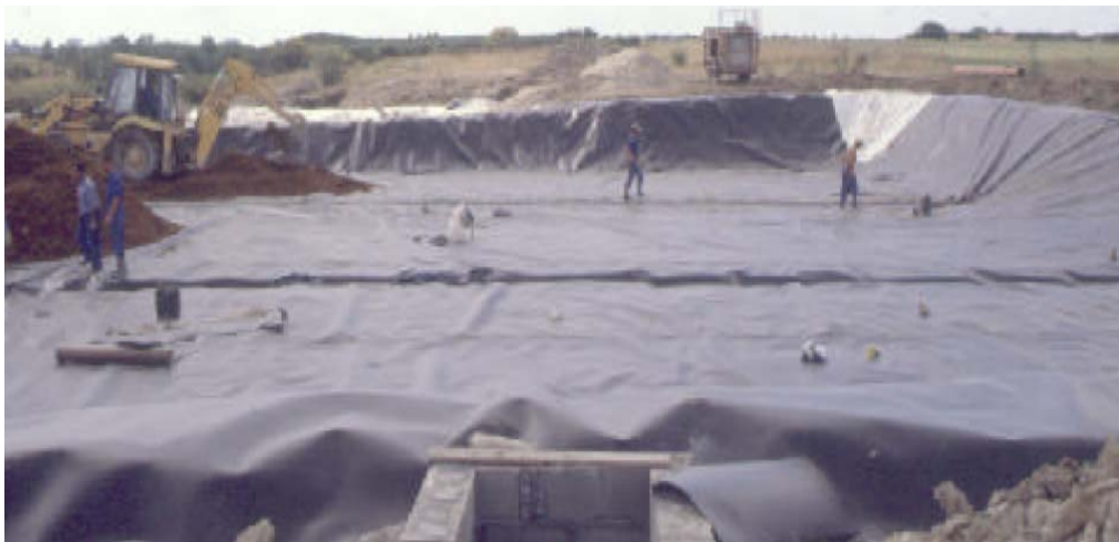
Figura 36. Detalle del relleno e impermeabilización de una balsa.
