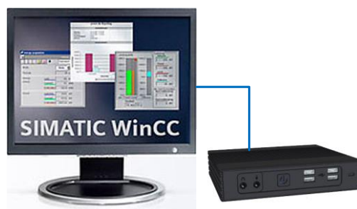
Equipos del puesto de operación de Molienda
