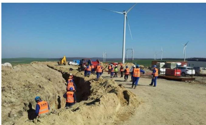
**Figura 13. Tendido de cable eléctrico en zanja (Albesti- Rumanía)**
