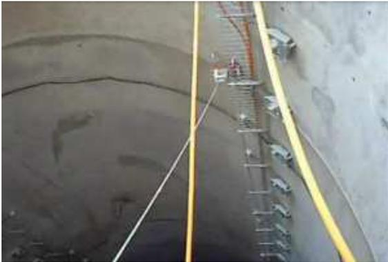
**5. Tiro del cable mediante máquina de tiro**
