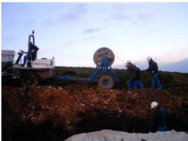
**Figura 46. Operarios utilizando carro con gatos porta bobinas**
