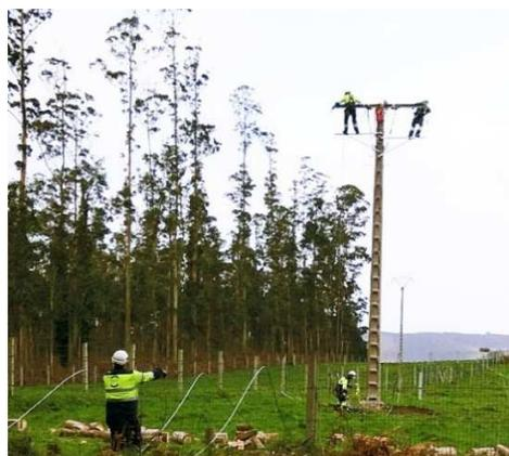
**Figura 15. Tendido de cable aéreo (Ferrol-España)**
