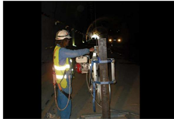
**10. Operario manejando la máquina de tiro, la cual está afianzada a un bastidor sujeto al suelo para evitar un posible vuelco de la misma. (La bobina de cable estaría situada en el lado contrario a la máquina de tiro)**
