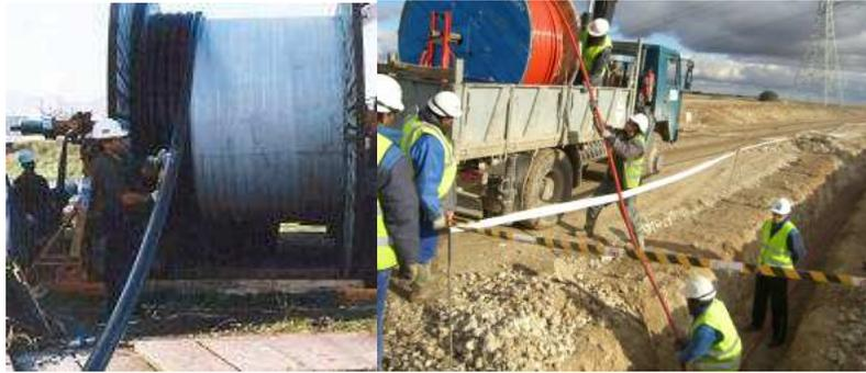
**Figura 59. Operarios colaborando en el desbobinado de cable**
