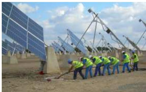
**Figura 12. Operarios colaborando en un tendido subterráneo**
