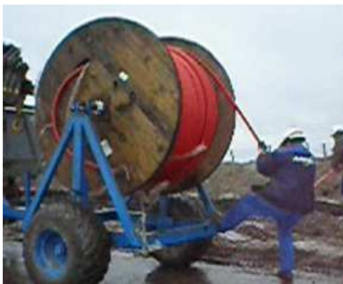
**Figura 37. Desbobinado manual de cable eléctrico**
