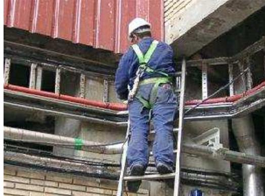
**Figura 11. Operario tendiendo cable sobre bandeja en altura**
