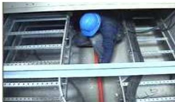
**Figura 16. Operario colaborando en un tendido en una postura forzada**
