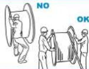
Evitar posturas forzadas en los esfuerzos de tracción. Hacer el desbobinado entre dos trabajadores y tirar siempre de frente a la bobina, sin giros de columna, extremidades inferiores, etc.
