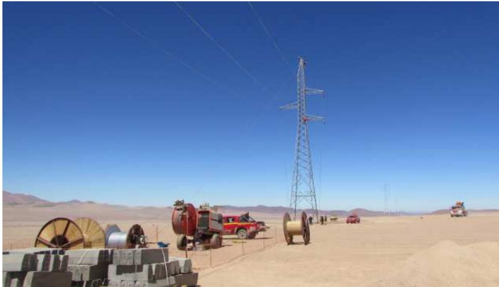
**Figura 42. Accesorios y ayudas mecánicas utilizados en el tendido de cable aéreo (Pampa Norte-Chile)**
