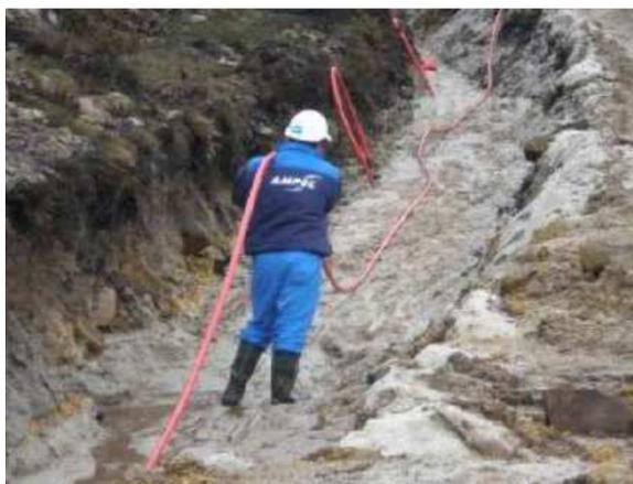
**Figura 36. Detalle del esfuerzo de un trabajador en el tendido del cable en zanja**
