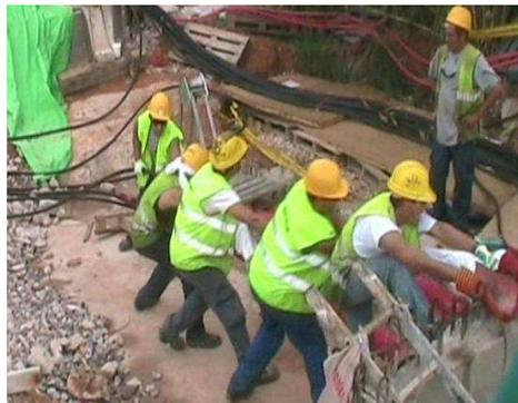
**Figura 62. Trabajadores realizando esfuerzo en el tendido de cable**
