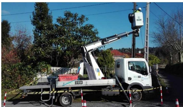
**Figura 39. Plataforma elevadora utilizada para el tendido de cable (Ferrol-España)**
