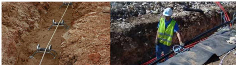
**Figura 35. Equipos auxiliares para el tendido de cable en zanja
