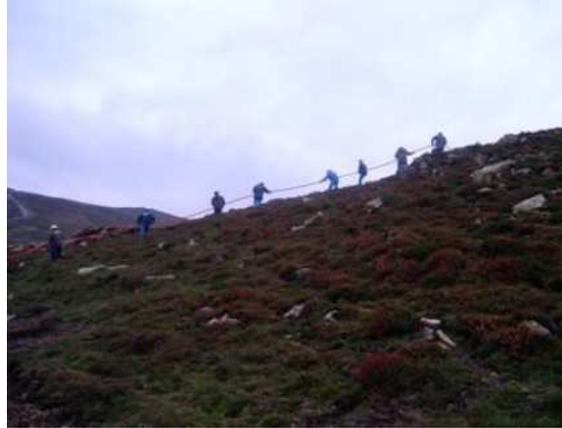
**Figura 14. Operarios tendiendo cable sobre zanja en pendiente**
