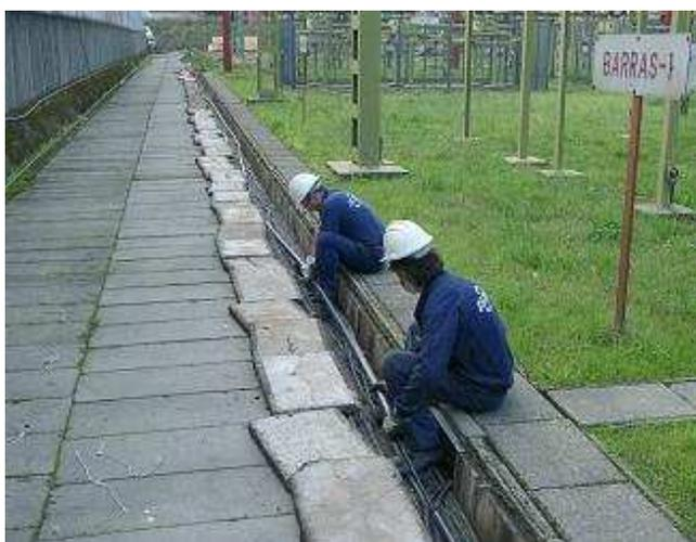
**Figura 56. Operarios tendiendo cable en la arqueta de una subestación eléctrica**
