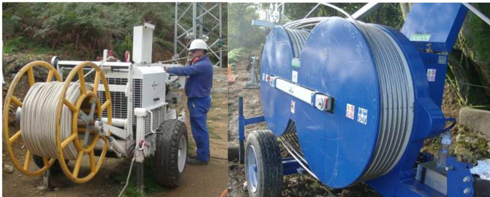
**Figura 41. Máquina de tiro y frenadora**
