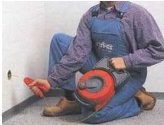
**Figura 30. Accesorios y ayudas mecánicas en el tendido de cable por tubería (Loimex, 2016)**
