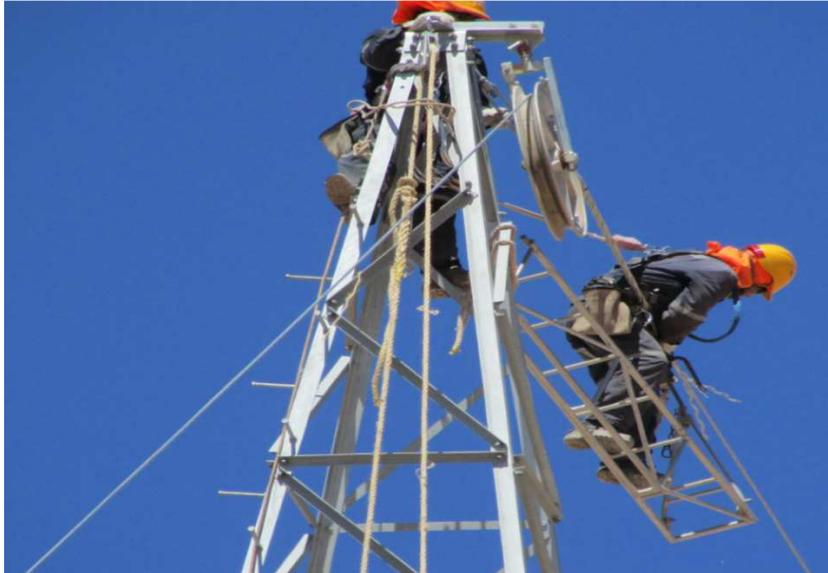
**Figura 43. Escalera de sujeción utilizada en el tendido de cable aéreo (Pampa Norte-Chile)**
