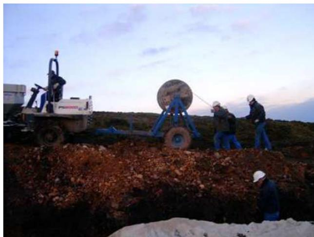
Para levantar y trasladar las bobinas se utilizará el carro porta bobinas y el vehículo autopropulsado más adecuado a las características de cada terreno. No colocarse cerca del radio de acción de las bobinas para evitar posibles golpes y/o atrapamientos.
