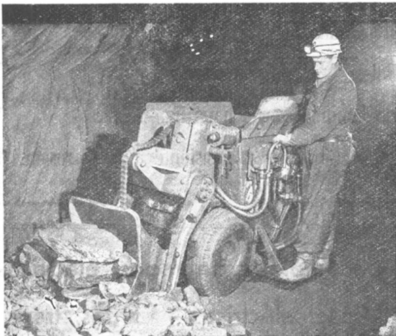
Las auto-cargadoras de Atlas Copco les da una nueva solución al problema de desescombro. Un hombre con una máquina puede hacer ahora los tres trabajos: carga, transporte y descarga.
