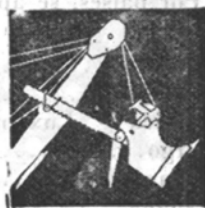
Una excavadora UNIVERSAL MENCK, Modelo M 110, arrancando piedras en un frente de basalto.
