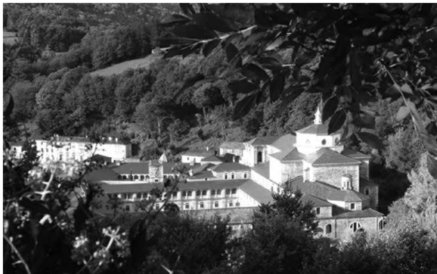
Panorámica del monasterio de San Julián de Samos desde el NE, por el camino que viene de Triacastela, que es el del Camino de Santiago. Fotografía del autor.
