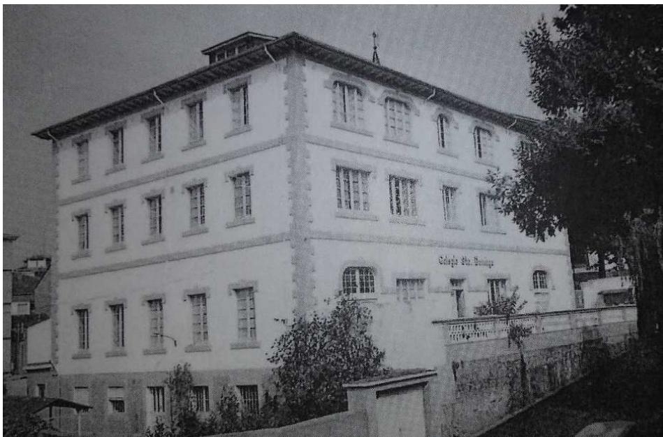
Segundo edificio del Colegio Santo Domingo de Navia. - Archivo de la Congregación.
