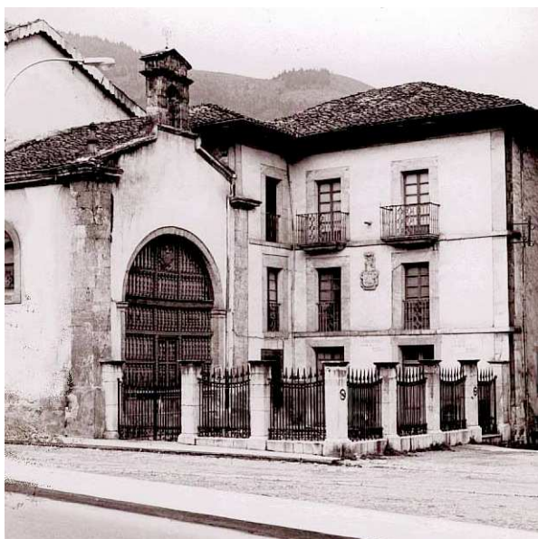
Fachada principal del Colegio Ntra. Sra. del Carmen de Infiesto. - Archivo particular del autor.
