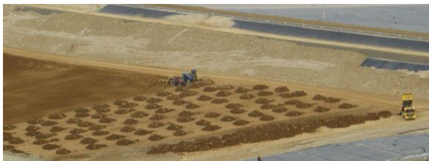
Figura 19: Apilamiento de relaves en seco utilizando transporte mediante camión (Jon Engels)
