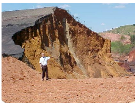
Figura 1: Rotura de una presa de relaves de Cataguases (Brasil)
