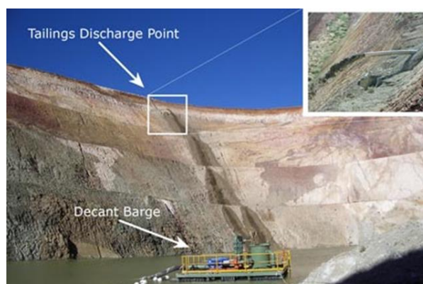
Figura 9: Típico almacenamiento en pozo
