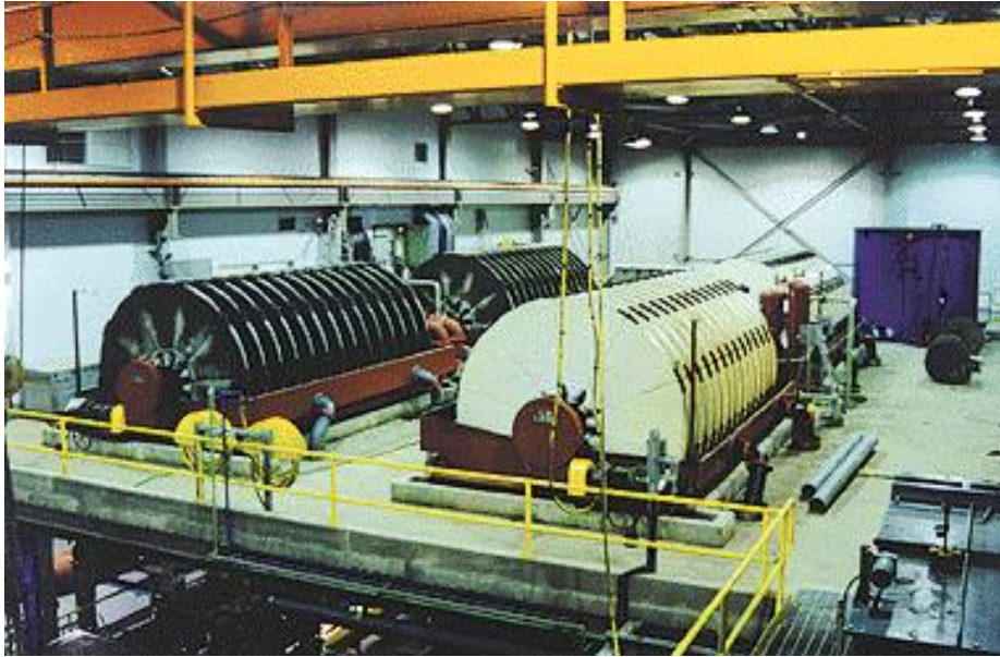
Figura 28: Ejemplo de una planta de filtrado
