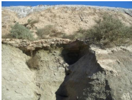
Imagen 2: Fallo en una tubería y posterior erosión en una cara aguas abajo (Engels, 2004)
