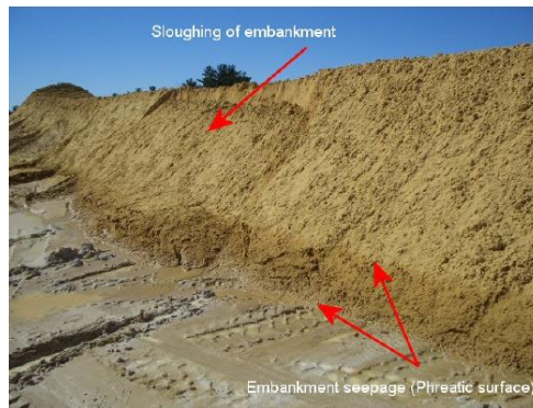
Imagen 3: Desprendimiento de un terraplén de relaves causado por una superficie con alto nivel freático (Engels, 2004)
