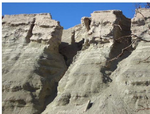
Imagen 4: Erosión en la cara aguas abajo de un terraplén de relaves debida a una extensa canalización del agua (Engels, 2004).
