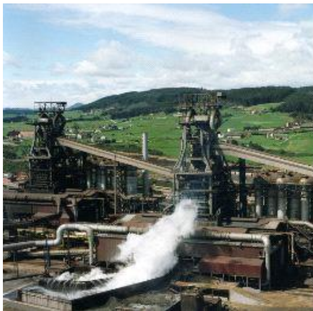
Figura 4. Vista de los hornos altos de Arcelor-Mittal en Veriña (Gijón). (CITOULA, 2013).
