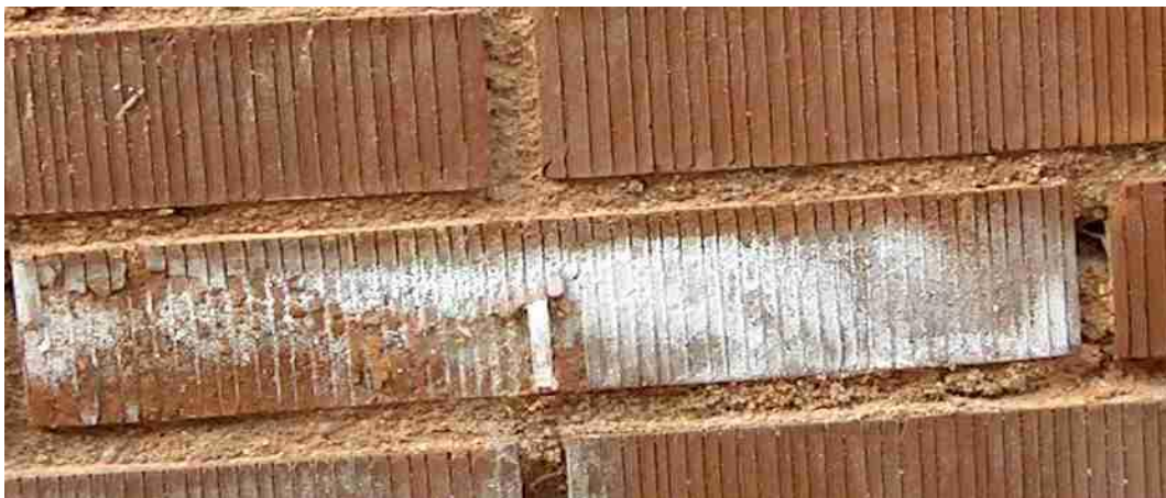
Figura 66. Detalle de ladrillo con eflorescencias en obra (Blanco(I), 2007).
