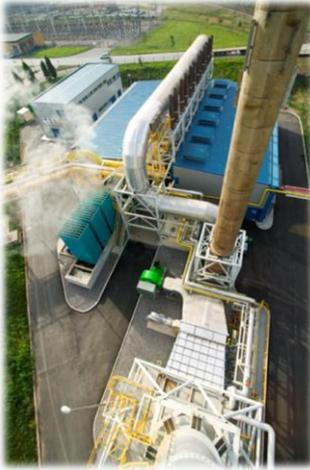
La temperatura de los gases de escape de la combustión de los motores es lo suficientemente elevada para la producción de vapor en una caldera de recuperación (GEA) con una capacidad nominal de producción de 20 ton/h de vapor (300 °C y 21,5 bar).
