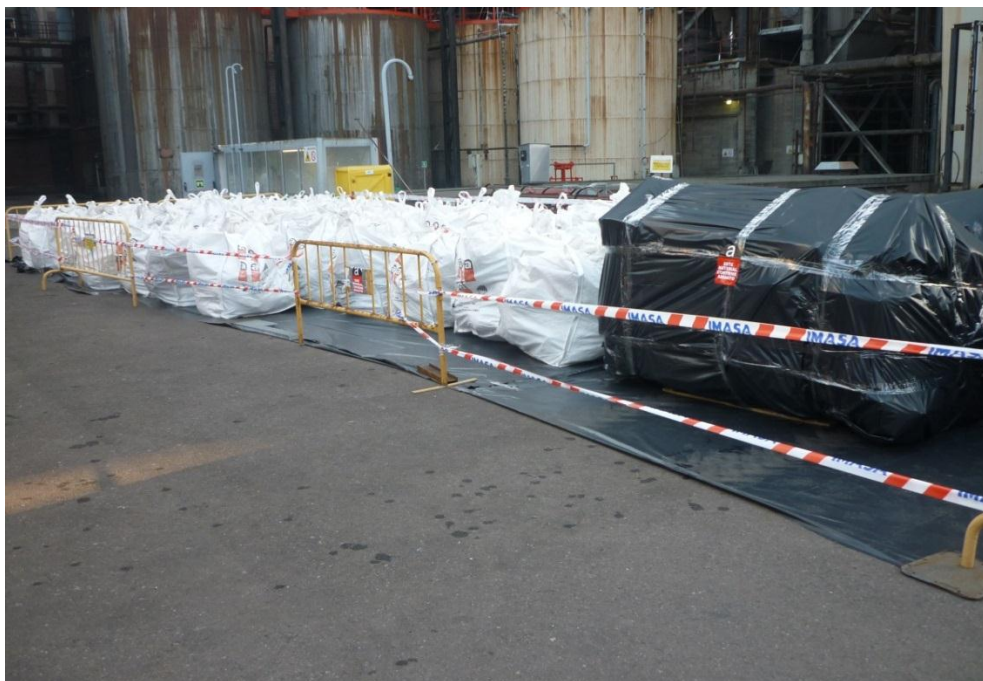
Imagen 6. Acopio de residuos de amianto
