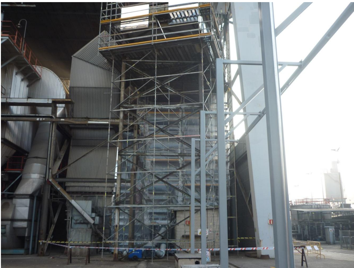
Imagen 1. Estructura de andamios
