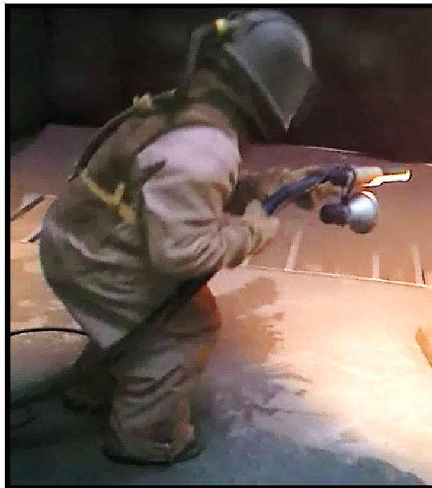
*Figura 3.19 Postura 2. Trabajador de Chorro en cuclillas/agachado. Método REBA*
